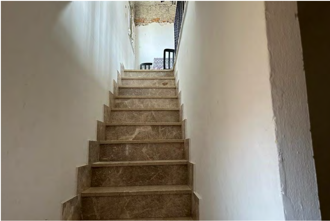
Foto n.9 Scala di collegamento fra i piani
