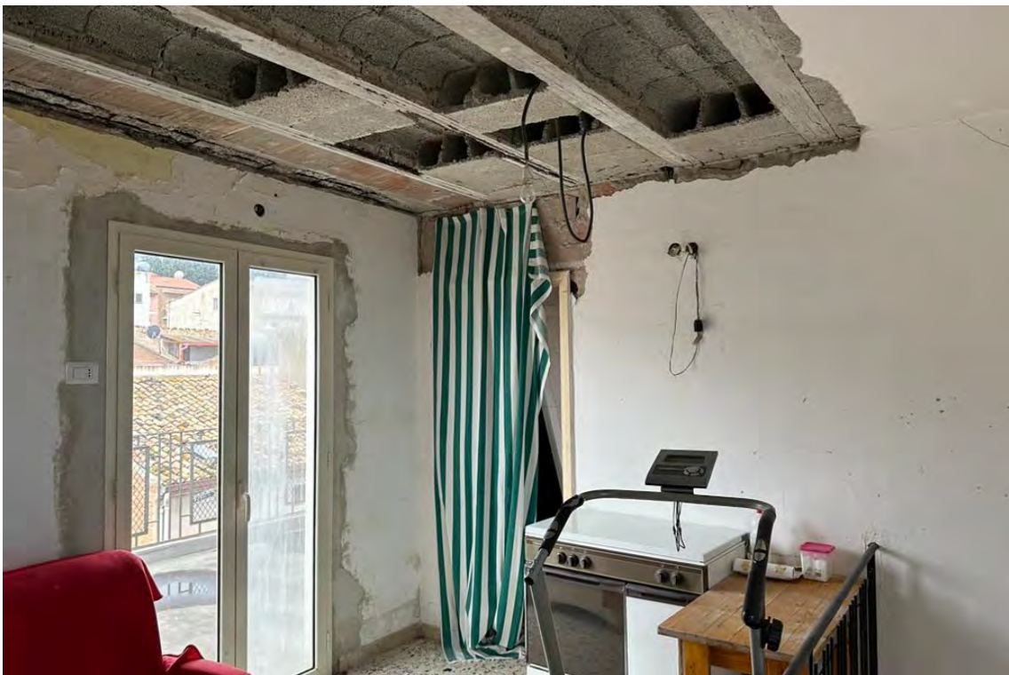
Foto n.16 Soggiorno al 4 piano
