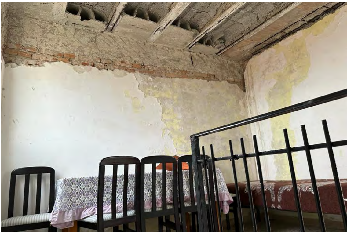
Foto n.14 Soggiorno al 4 piano
