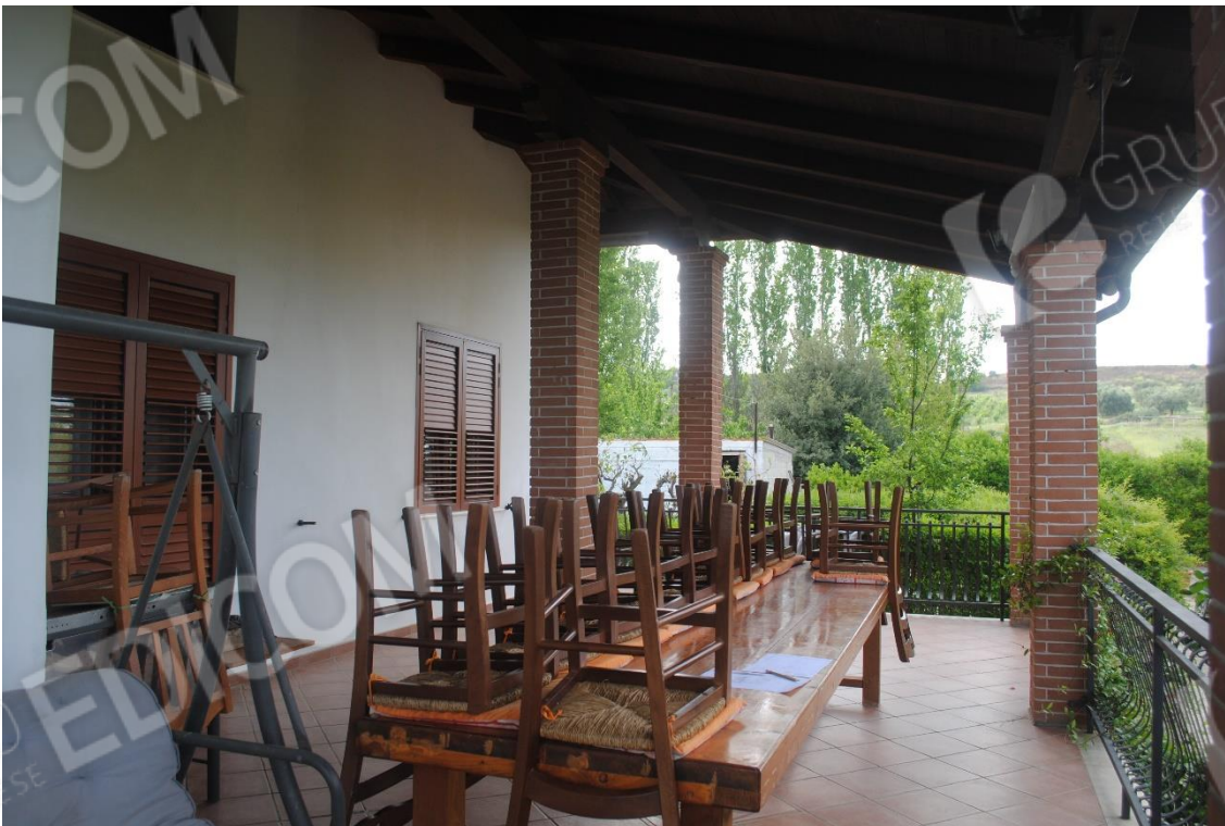
Foto n.10 – Vista Esterna il terrazzo vista giardino/terreno
