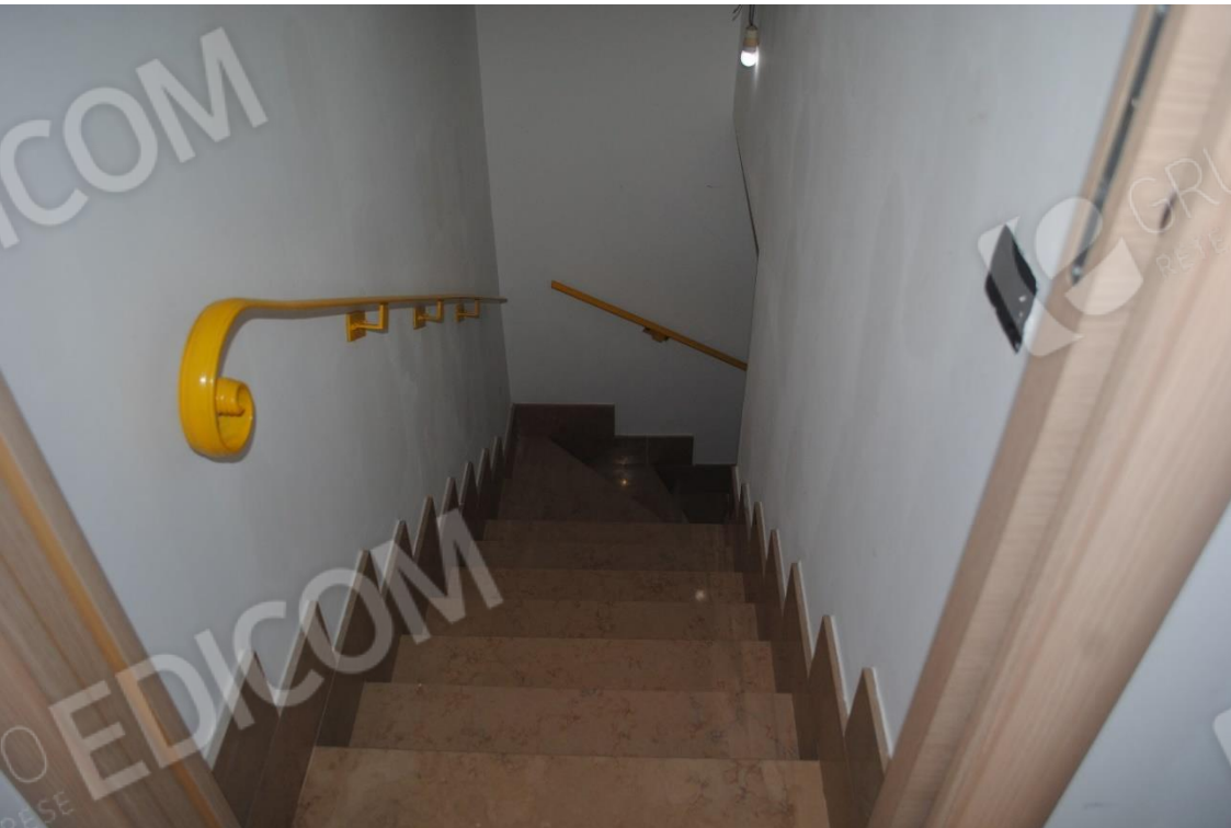
Foto n.16– Vista Interna : scala interna di collegamento tra i piani
