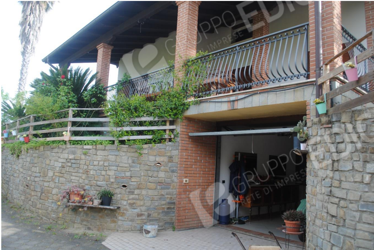
Foto n.19.– Vista esterna : prospetto laterale, ingresso garages
