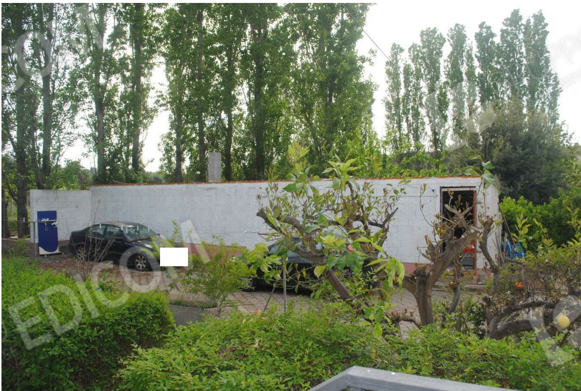
Foto n.20.– Vista esterna : giardino /deposito
