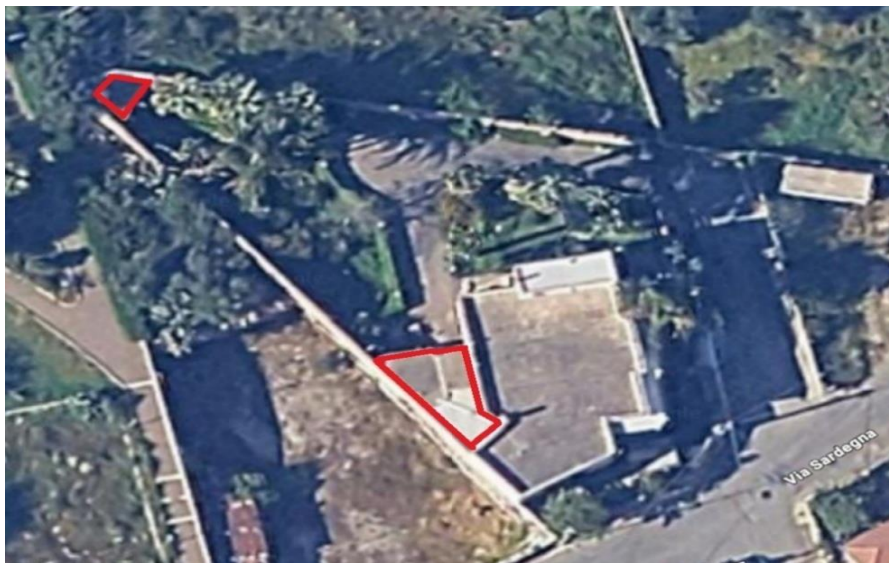
Zona rossa. Difformità urbanistiche edilizie
