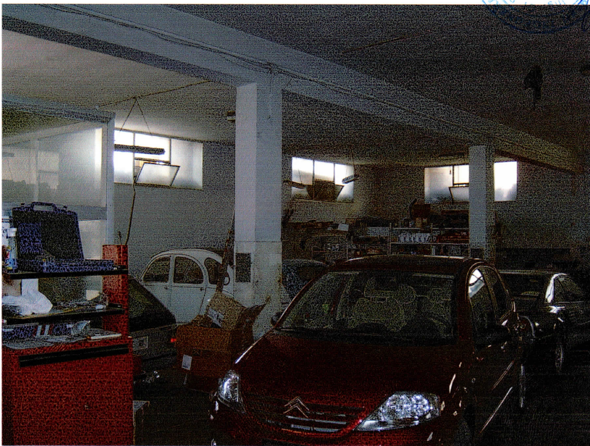
Foto n. 5 - Interno autofficina - (la trave costituisce la suddivisione reale della particella 355 in sub 3 e sub 4 - rispettivamente immobile B e immobile C)
