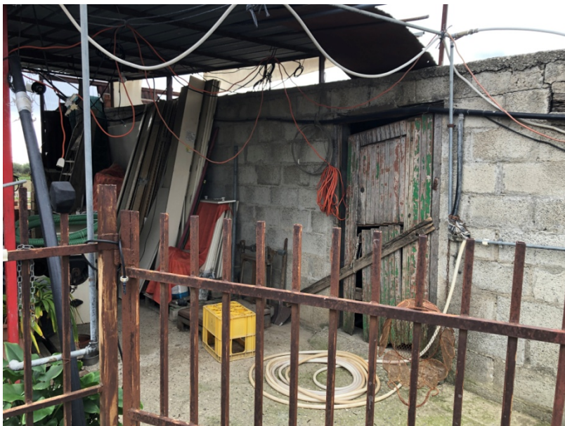
VISTA DA NORD: DEPOSITO IN TUFO E TETTOIA
