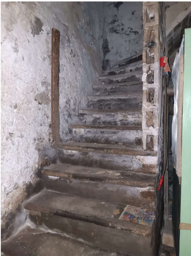
Foto relative al piano II seminterrato.
