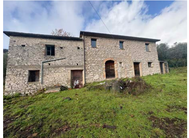
Fotografia n. 2 _ Prospetto principale del casolare
