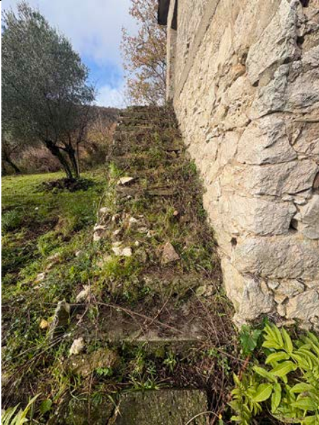
Fotografia n. 5 _ Scala di accesso al piano primo del deposito p.la 5238
