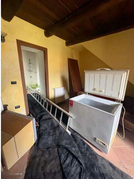
Fotografia n. 9 _ Vano p.lla 5237 sub 1 al piano terra
