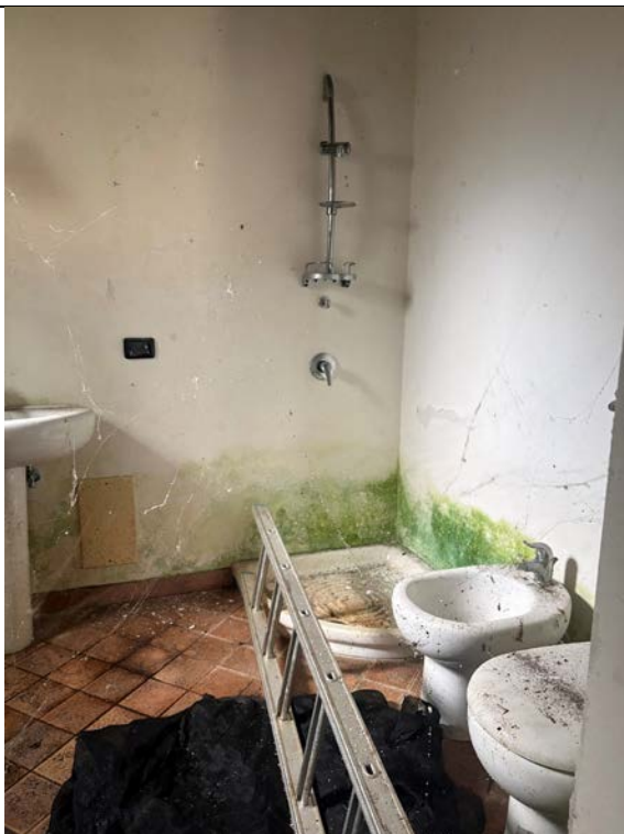
Fotografia n. 11 _ wc n. 1 al piano terra
