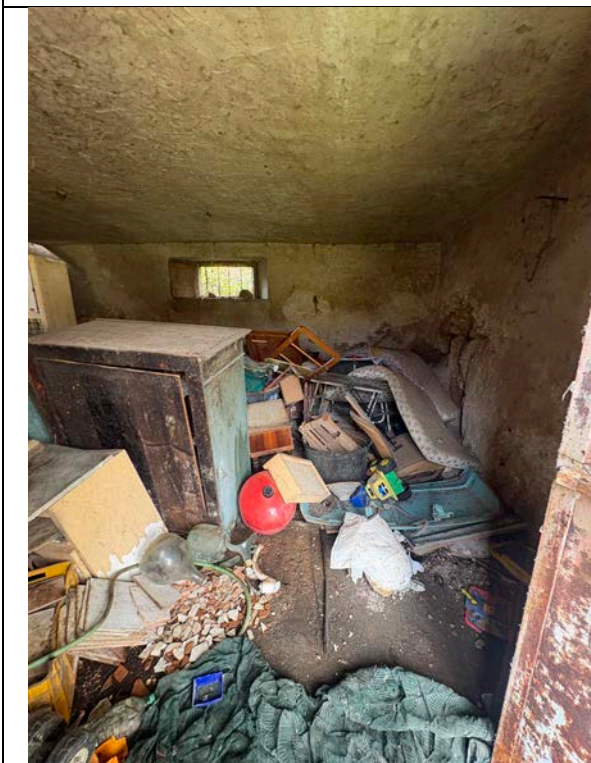
Fotografia n. 15 _ Deposito p.lla 5238 al piano terra
