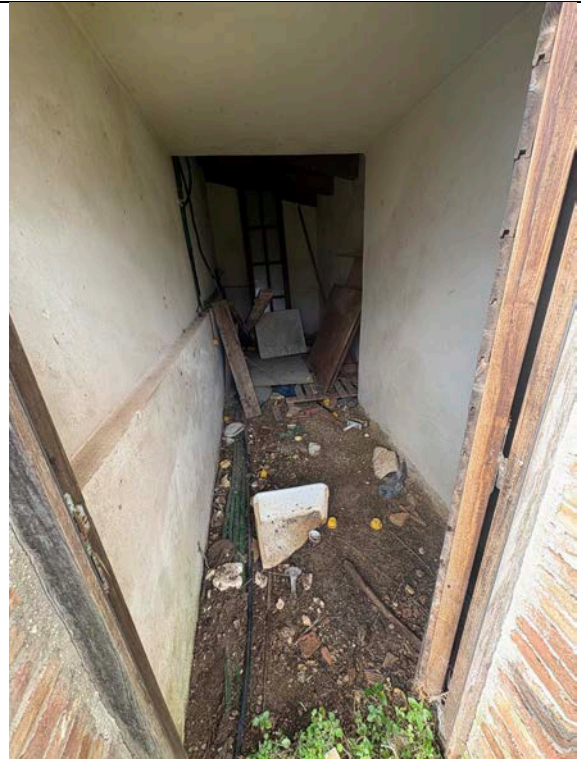
Fotografia n. 14 _ Cantinola p.lla 5235 sub 1 al piano terra
