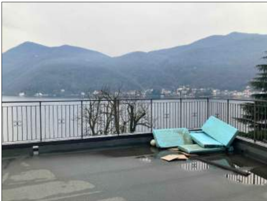
Foto 48 - COPERTURA: VISTA LAGO CERESIO ( VISTA VERSO EST)
