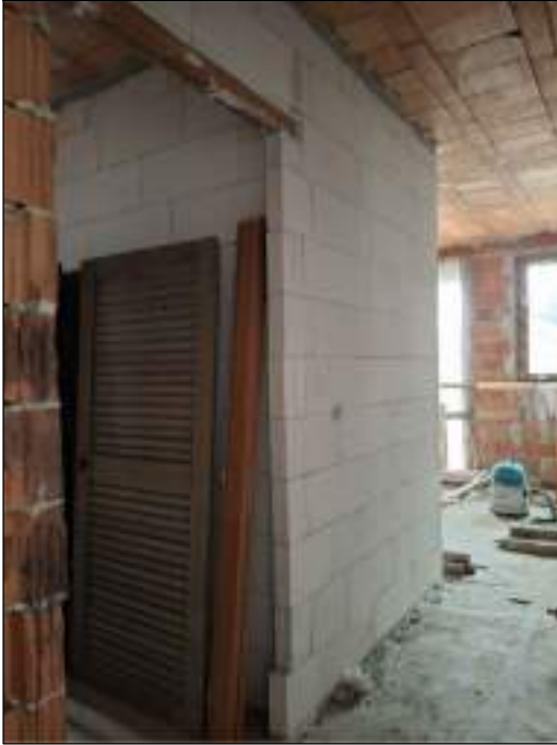
Foto 09 - CORRIDOIO LATO SUD
