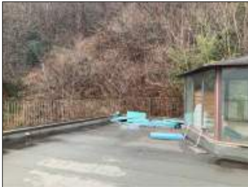
Foto 45 - BUSSOLA SU COPERTURA: VISTA VERSO SUD-OVEST
