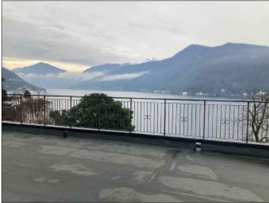
Foto 49 - COPERTURA: VISTA LAGO CERESIO ( VISTA VERSO EST)
