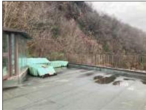
Foto 46 - BUSSOLA SU COPERTURA: VISTA VERSO NORD-OVEST
