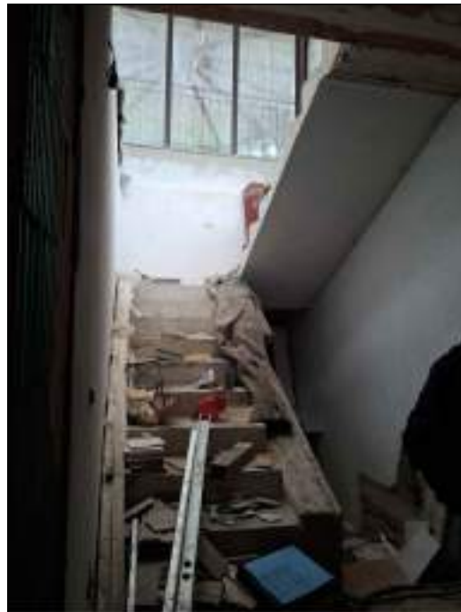
Foto 39 - SCALA DA TERZO PIANO A COPERTURA
