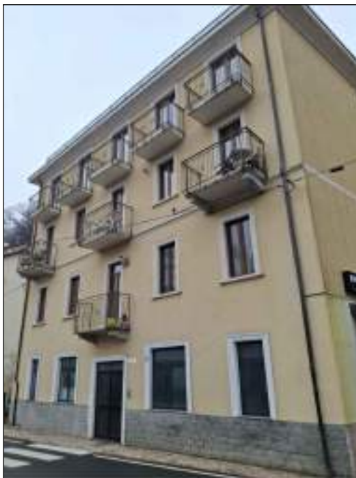
Foto 03 - FACCIATA SU VIA CASAMORA
