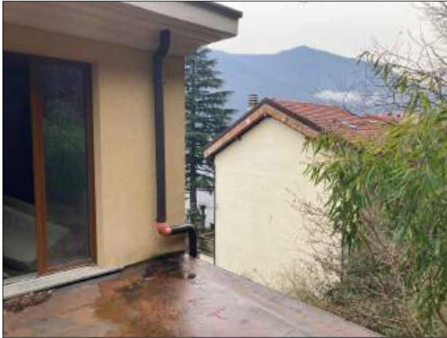
Foto 20 - TERRAZZA AD OVEST: VISTA VERSO SUD
