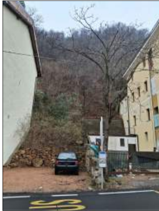
Foto 02 - VISTA IMMOBILE DA SUD-EST
