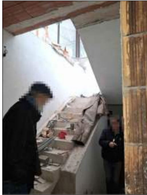
Foto 06 - SCALA VERSO LA COPERTURA
