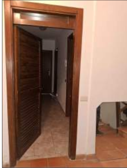
Foto 52 - ACCESSO AD UNITA' AL SECONDO PIANO
