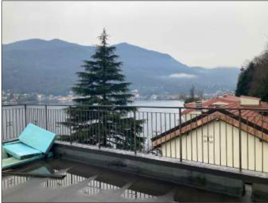
Foto 47 - COPERTURA: VISTA LAGO CERESIO ( VISTA VERSO SUD-EST)
