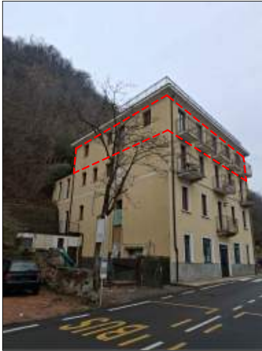
Foto 01 - VISTA IMMOBILE DA SUD
