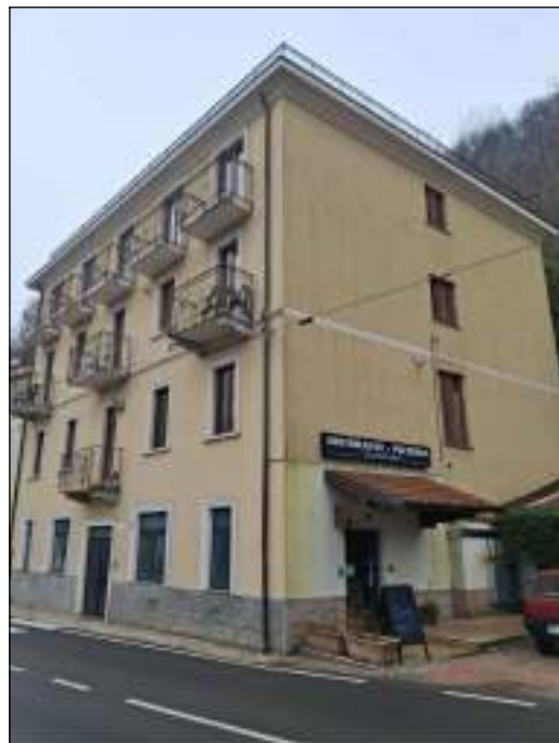
Foto 04 - VISTA IMMOBILE DA NORD-EST
