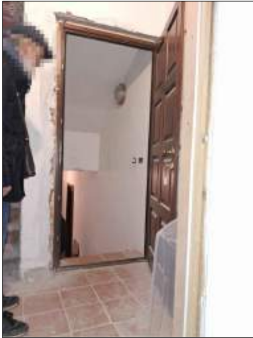
Foto 05 - PORTA DI ACCESSO AL TERZO PIANO
