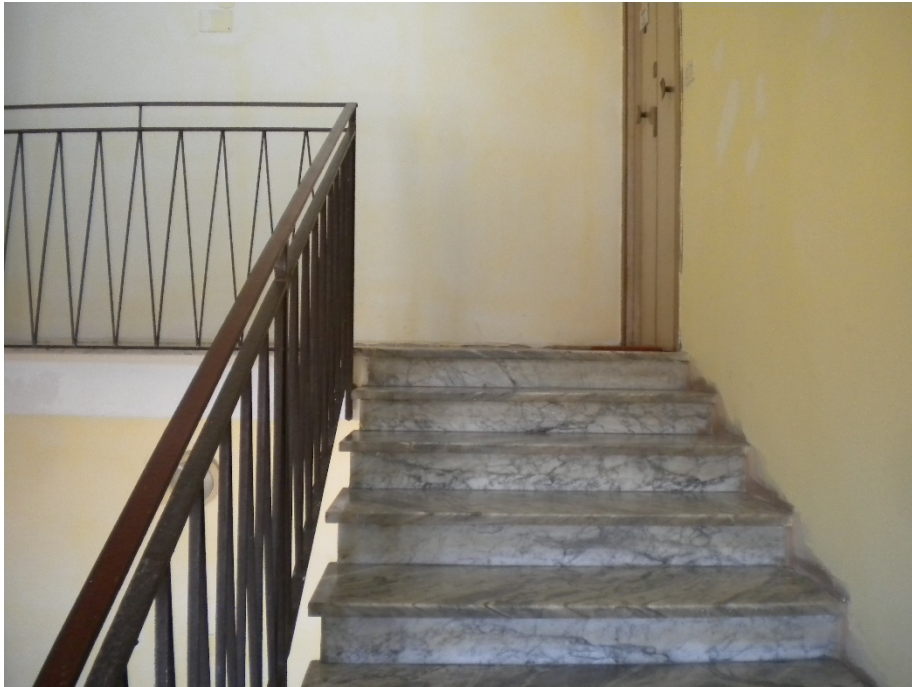
Foto 5- Scala condominiale terzo piano
