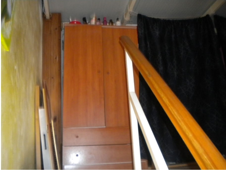
Foto 15 – Sbarco scala su soffitta-soppalco.
