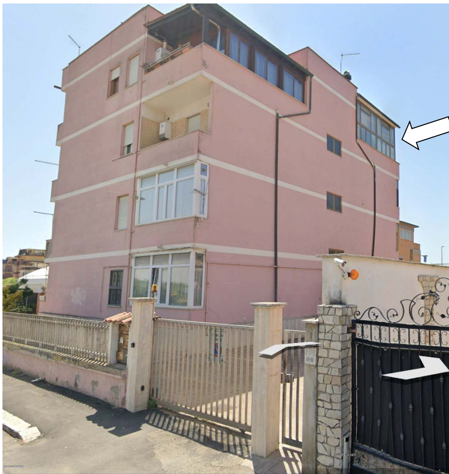
Foto 1- Prospetto palazzina con ingresso carrabile condominiale Via Rumenia 1. Con freccia bianca appartamento piano terzo lato cucina
