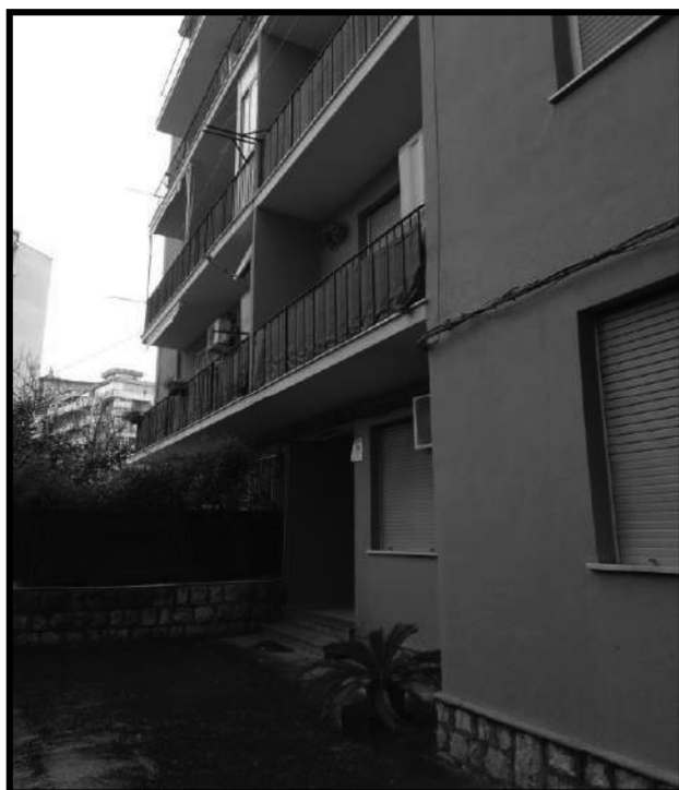
Foto n°4 = Vista dell'ingresso al condominio
