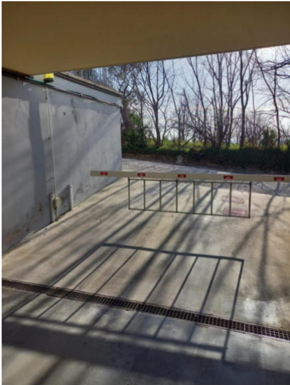
FOTO 1.19_accesso comune garage
