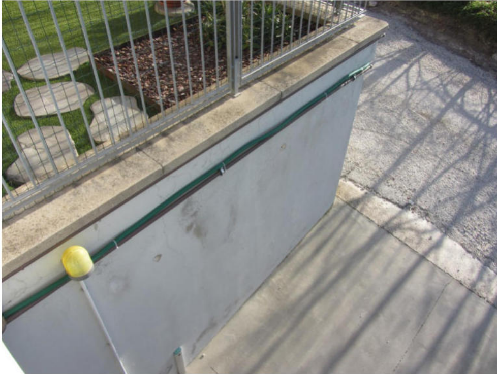
FOTO 1.25_tubo acqua calda
