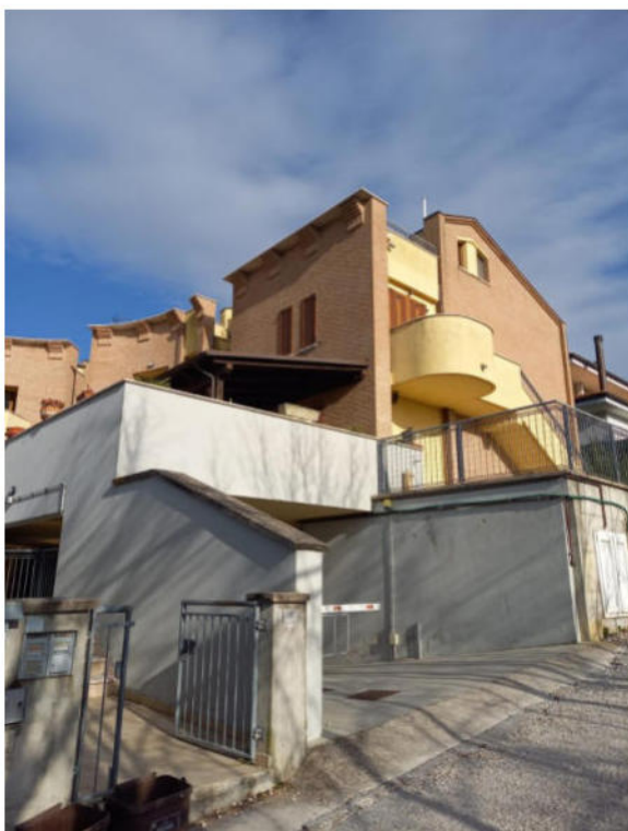
FOTO E.02_ Prospetto fronte/laterale
