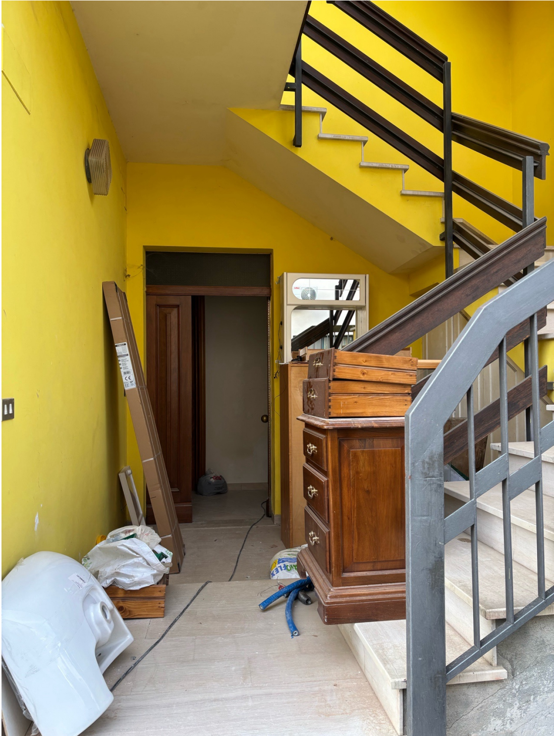
Foto n. 8 – Scala esterna: piano terra.
