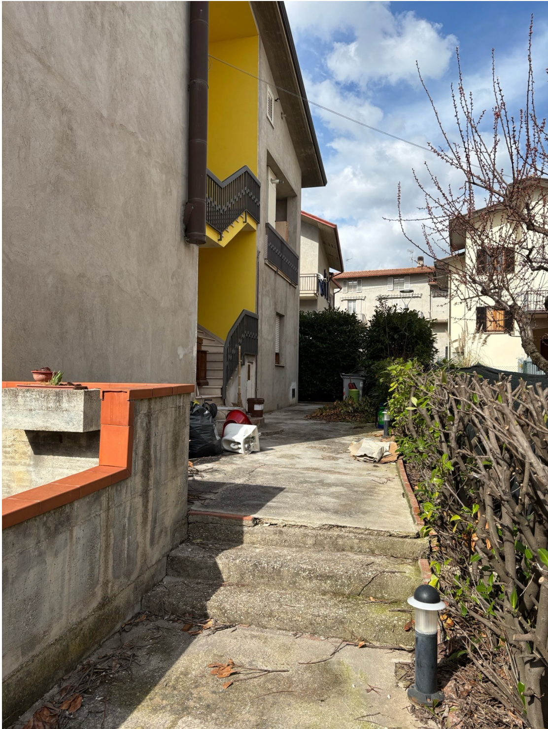
Foto n. 5 – Prospetto laterale (est).
