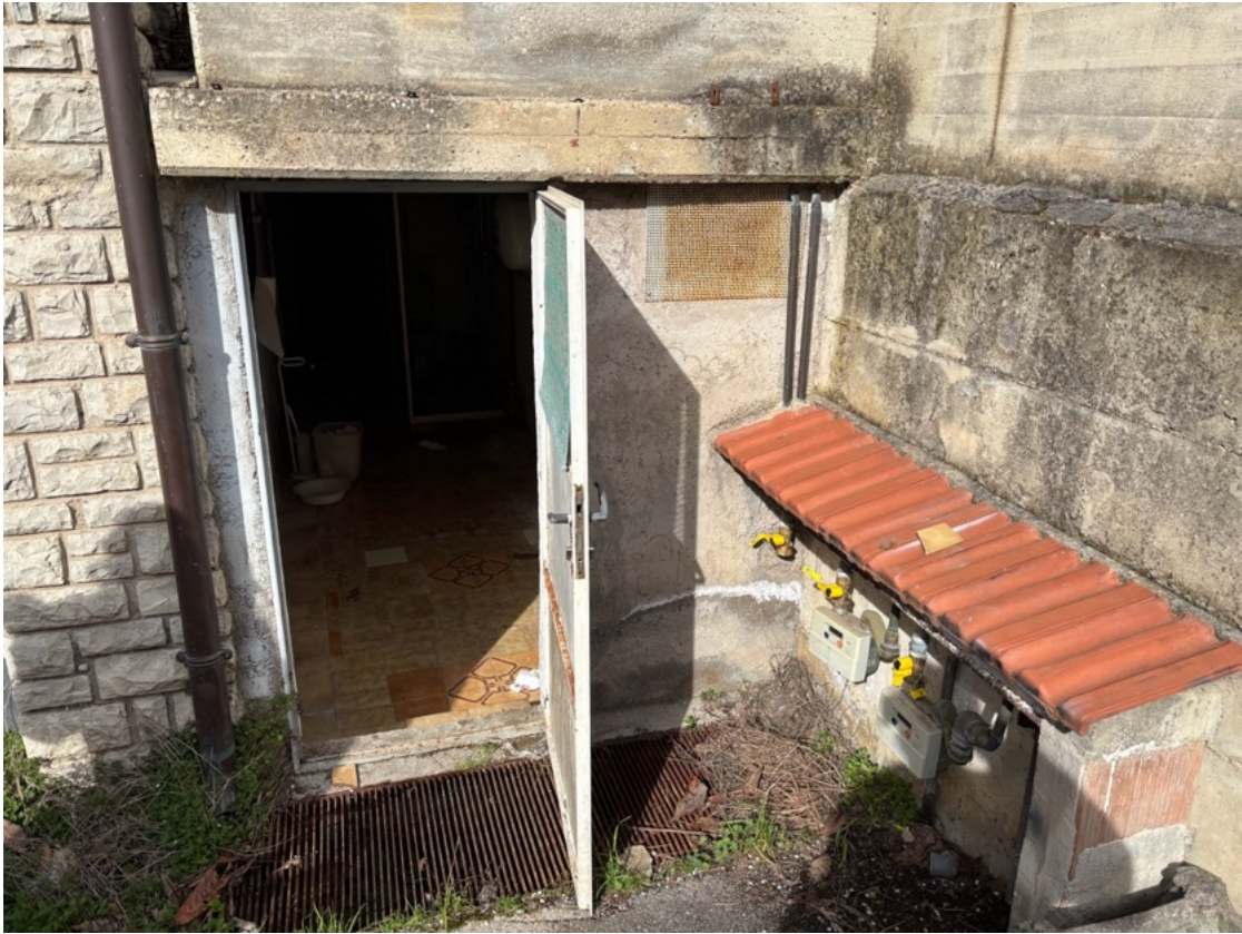
Foto n. 62 – Porta d'ingresso del locale fondo.
