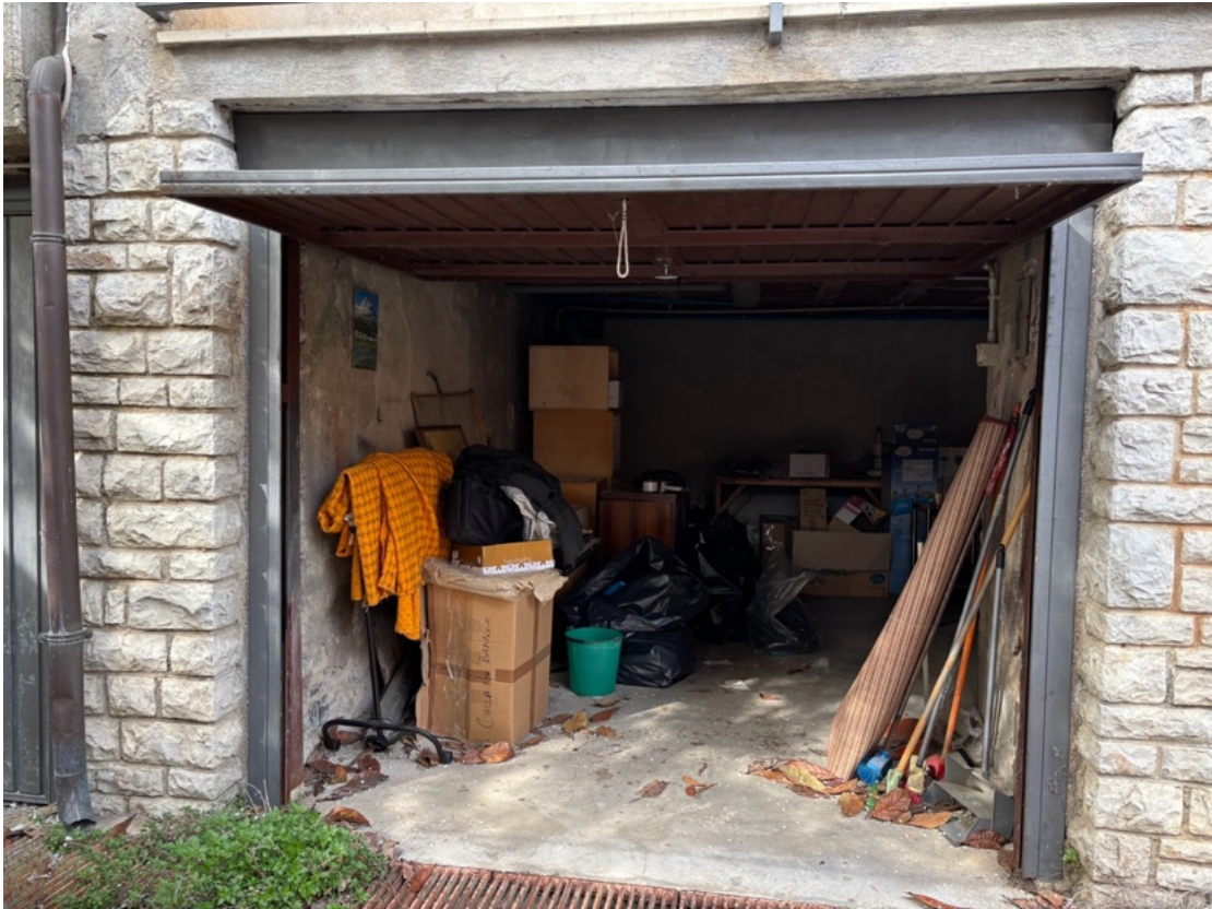
Foto n. 66 – Locale garage (sub. 4).
