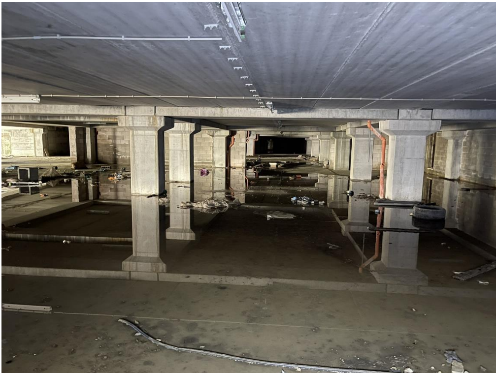
Fotografia n.3 – Piano Seminterrato – L'area destinata a parcheggi.
