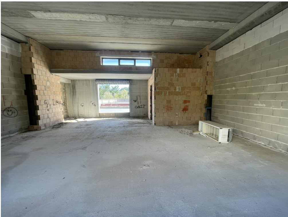
Fotografia n.25 – Piano Primo – Altra visuale interna dell’Ambiente interno del negozio Tipo.
