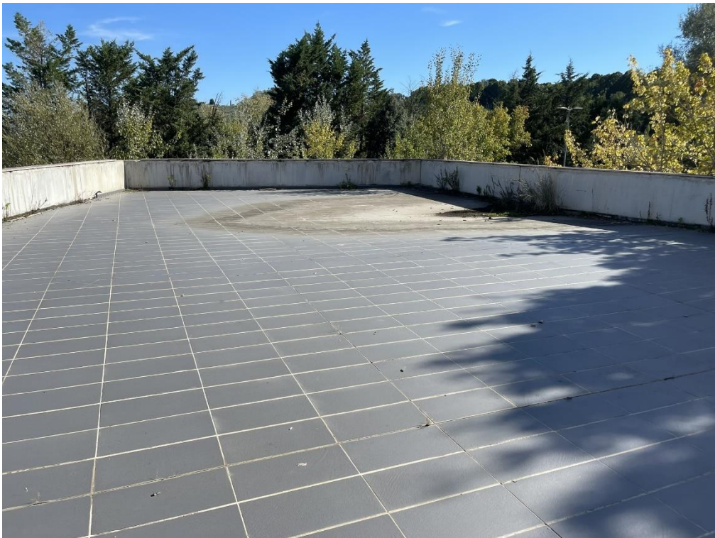
Fotografia n.33 – Piano Primo – Visuale del Portico Solare.
