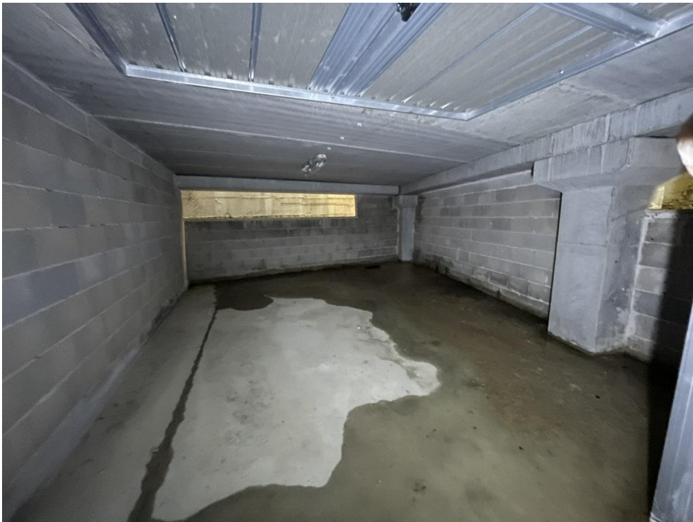
Fotografia n.7 – Piano Seminterrato – Altra visuale interna del Garage tipo.
