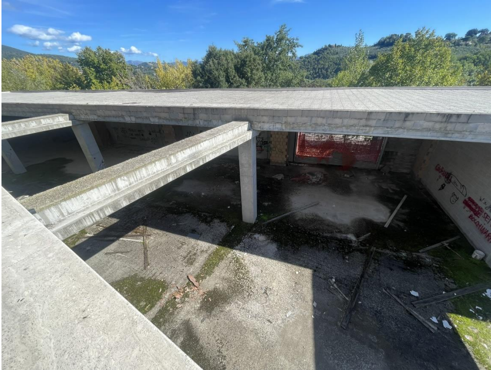
Fotografia n.20 – Piano Terra – Visuale degli spazi interni destinati a Supermercato ripresi dal Piano Primo.
