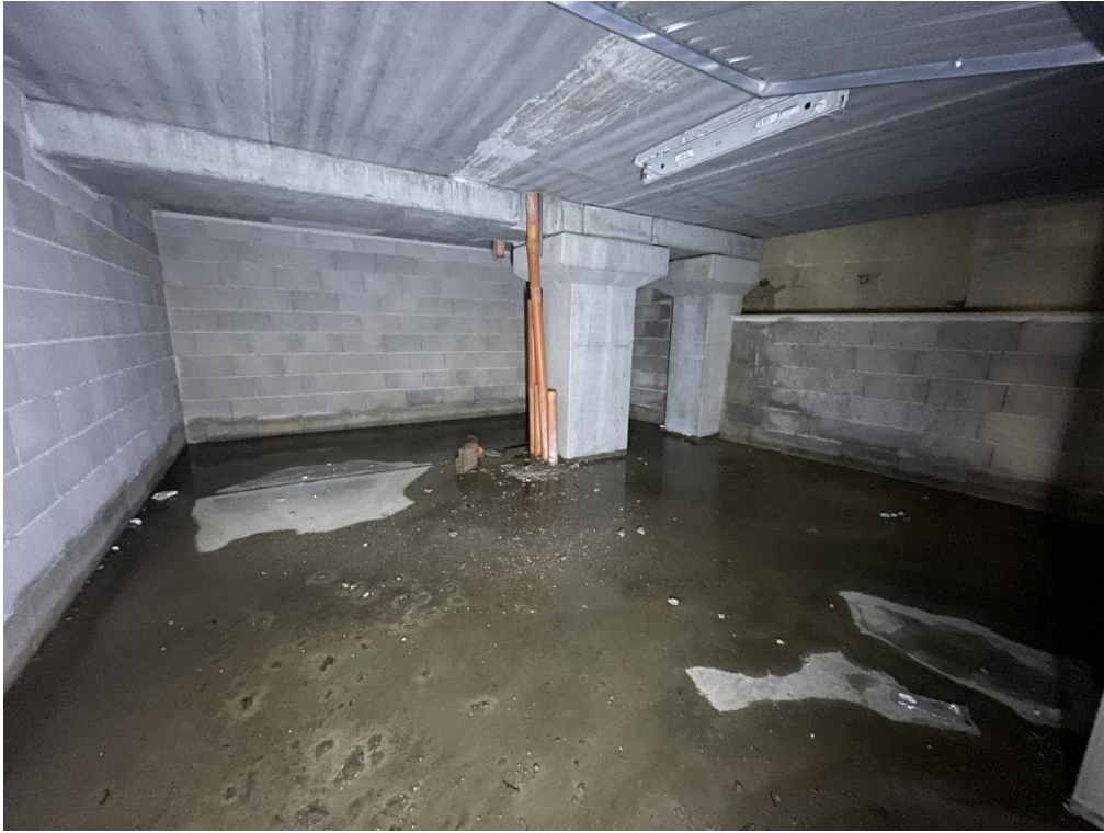
Fotografia n.6 – Piano Seminterrato – Altra visuale interna del Garage tipo.
