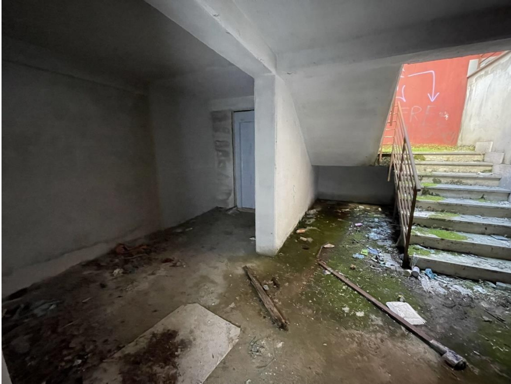
Fotografia n.8 – Piano Seminterrato – La scala ed il corpo ascensore di collegamento con il Piano Terra.
