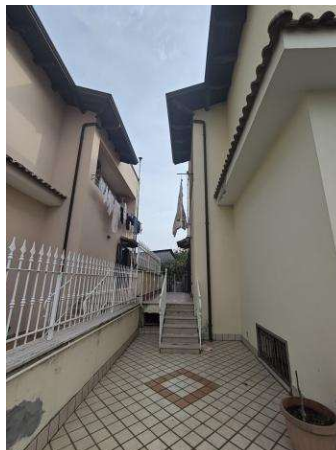
Foto 2/3/4 – CORTE ZONA INGRESSO – POSTERIORE – LATERALE SINISTRA
