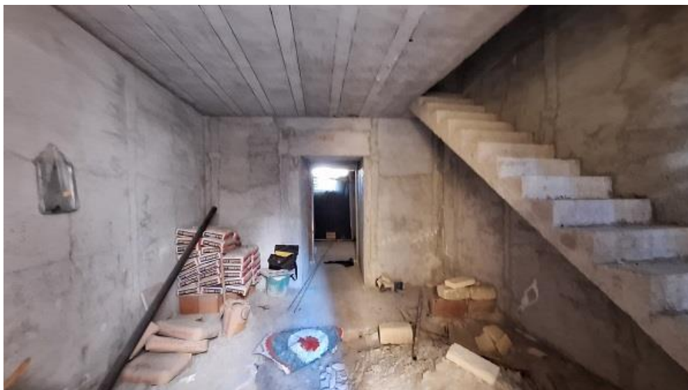
Vista dall'ingresso - P. T.
