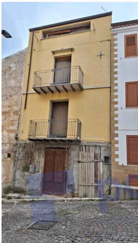
Prospetto principale sulla Via Trieste
