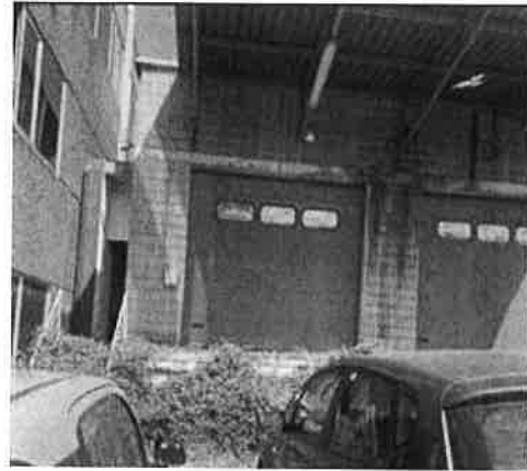
capannone lato via Trieste
