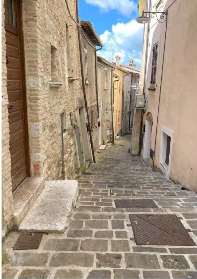
Foto 7 strada di accesso Vicolo del Curiale
