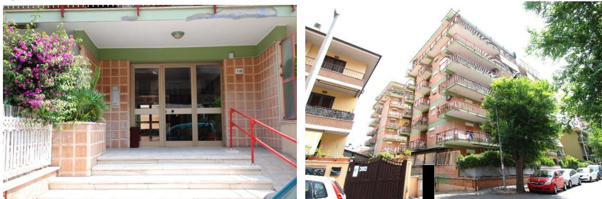
Figura 16. L'ingresso al fabbricato (a sin) e il fabbricato (a dx).
