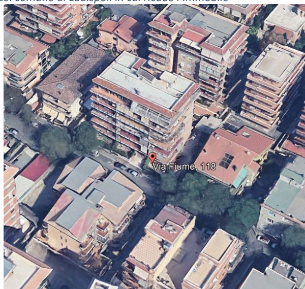
Figura 2. Vista di dettaglio del fabbricato in cui è inserito l'appartamento in oggetto
