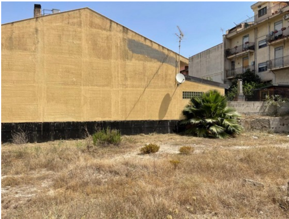
Fotografia C.10 - Carlentini-Foglio 16 p.la 2331-Terreno-Confin ovest
