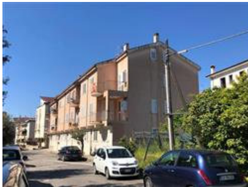
Prospetto Nord - Est del fabbricato, su via Filippo Turati
