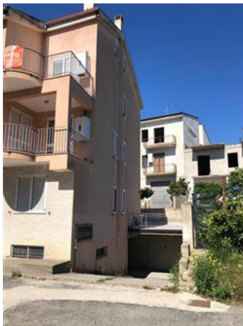
Vista esterna della rampa di accesso al garage, da Via Filippo Turati
