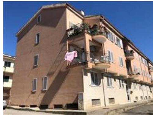
Prospetto Sud - Est del fabbricato, su via Filippo Turati
