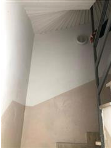
Vista interna del corpo scala (privo di ascensore)
