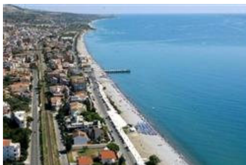
Veduta panoramica del lungomare di Trebisacce (CS)
