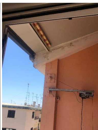
Vista del terrazzino al piano 2° - Dettaglio delle superfici ammalorate
