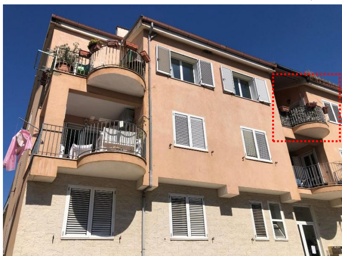
Vista esterna del fabbricato, da Via F. Turati
