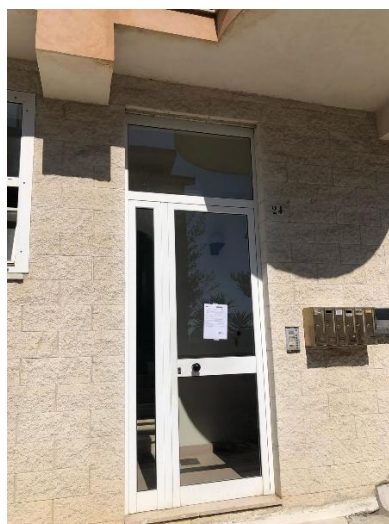
Portone d'accesso al fabbricato
