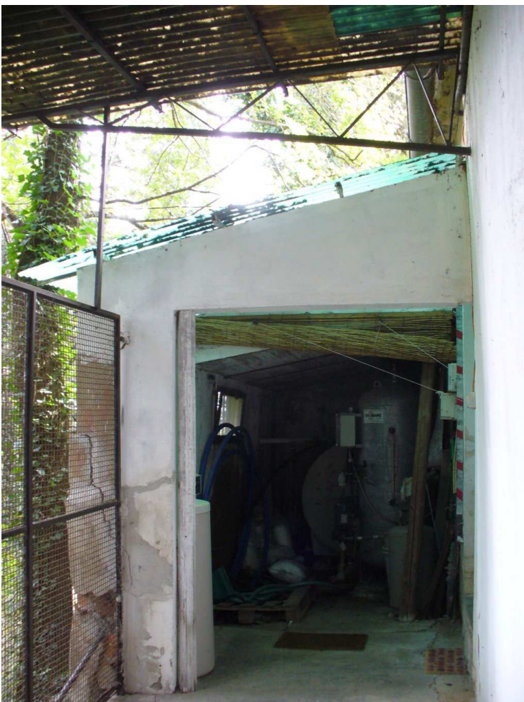
Foto n. 42 - edificio principale - magazzini P.T. - locale tecnico
