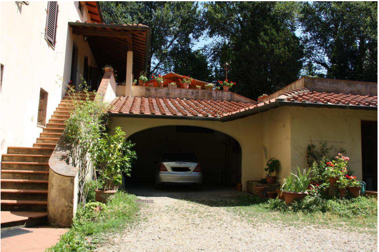
Foto n. 47 - edificio principale - esterno con scala di accesso e rimessa macchine
