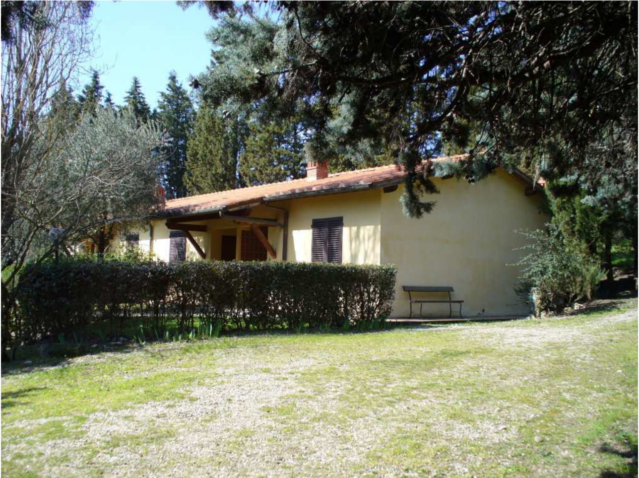
Foto n. 5 – Fabbricato “Poggetti” - prospetti frontale e laterale
