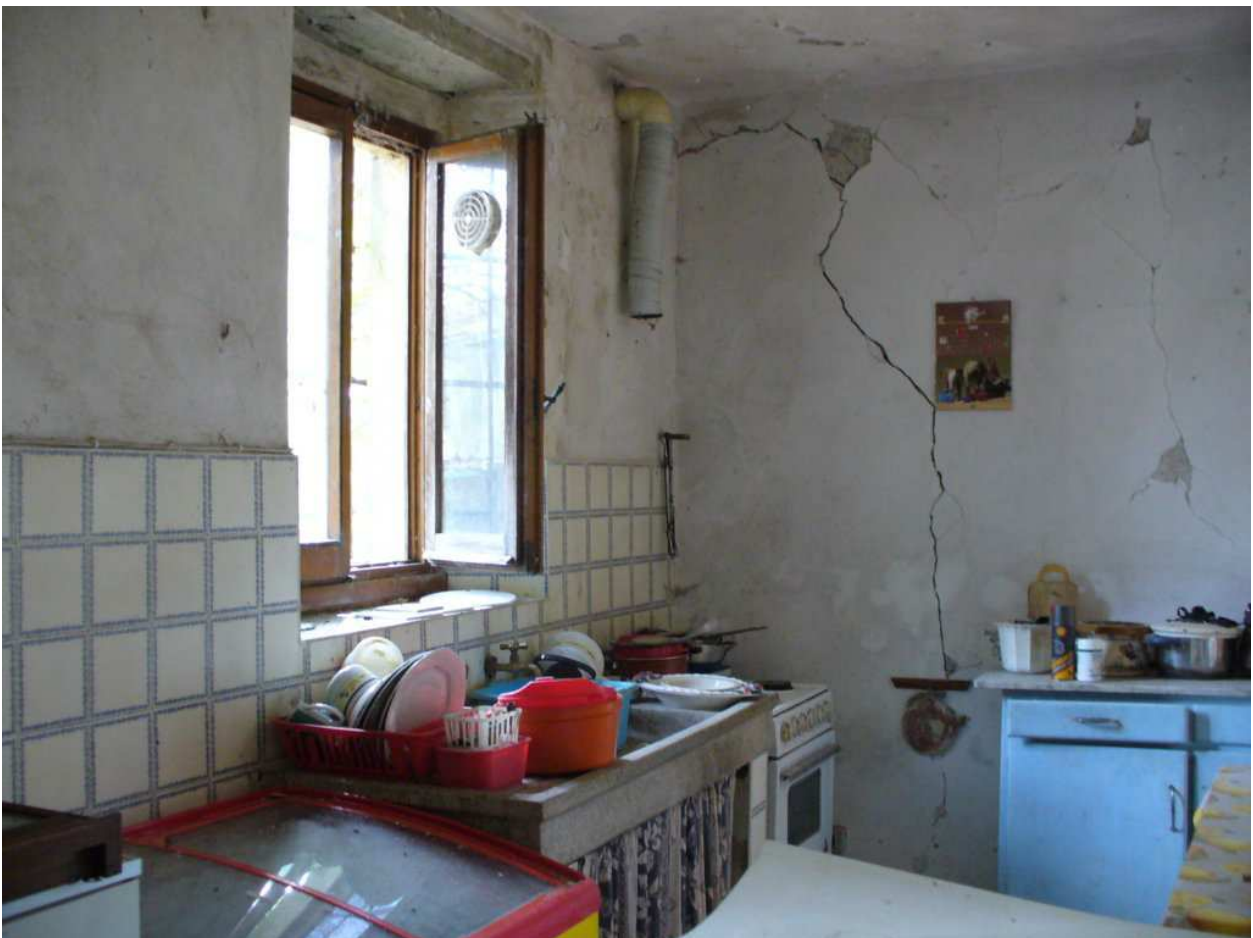
Foto n. 44 - edificio principale - magazzini P.T. - cucina rustica
