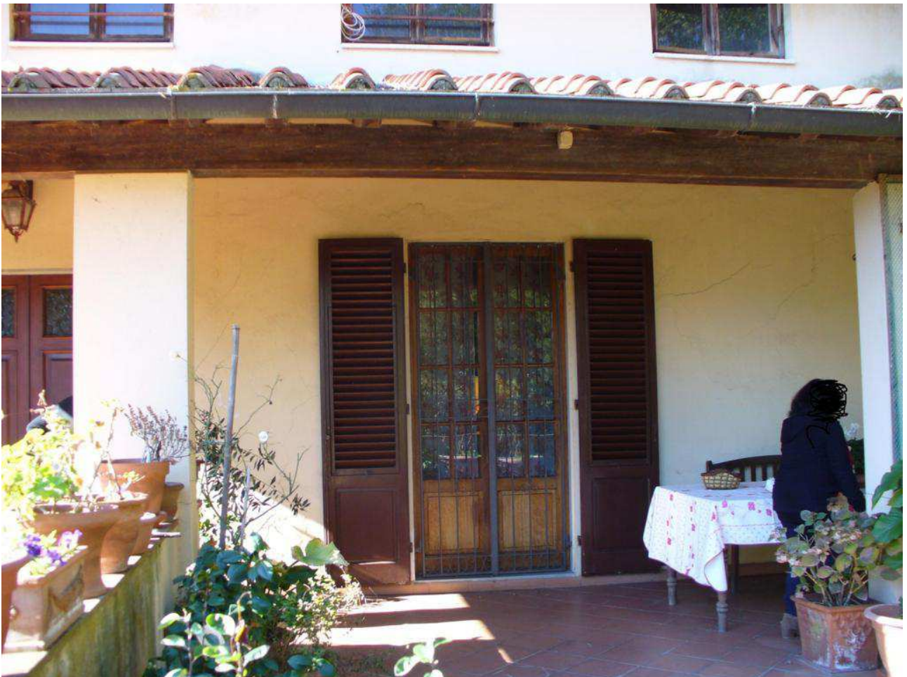
Foto n. 54 - edificio principale - civile abitazione - loggia
