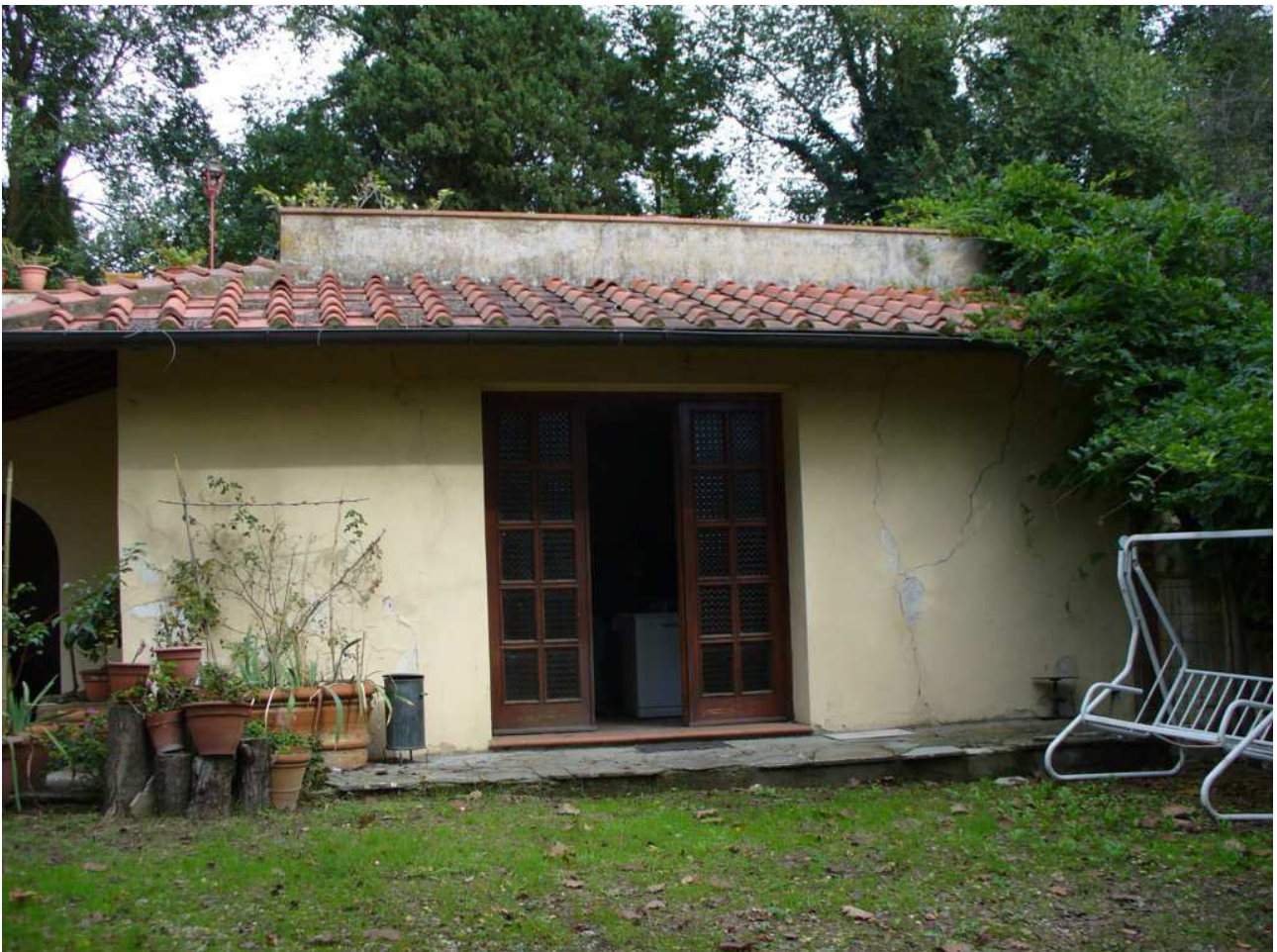
Foto n. 46 - edificio principale - magazzini P.T. - esterno della cucina rustica
