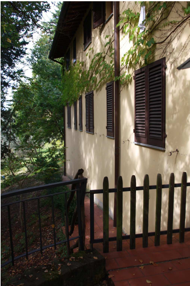
Foto n. 19 - edificio "Alberi" veduta del prospetto tergale
