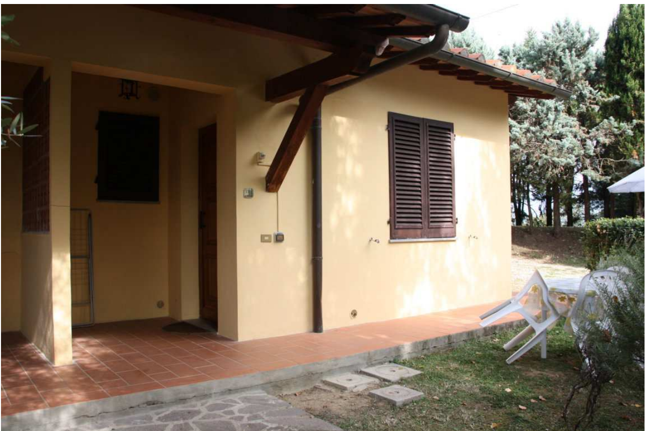
Foto n. 8 – Fabbricato "Poggetti" – particolare del prospetto principale
