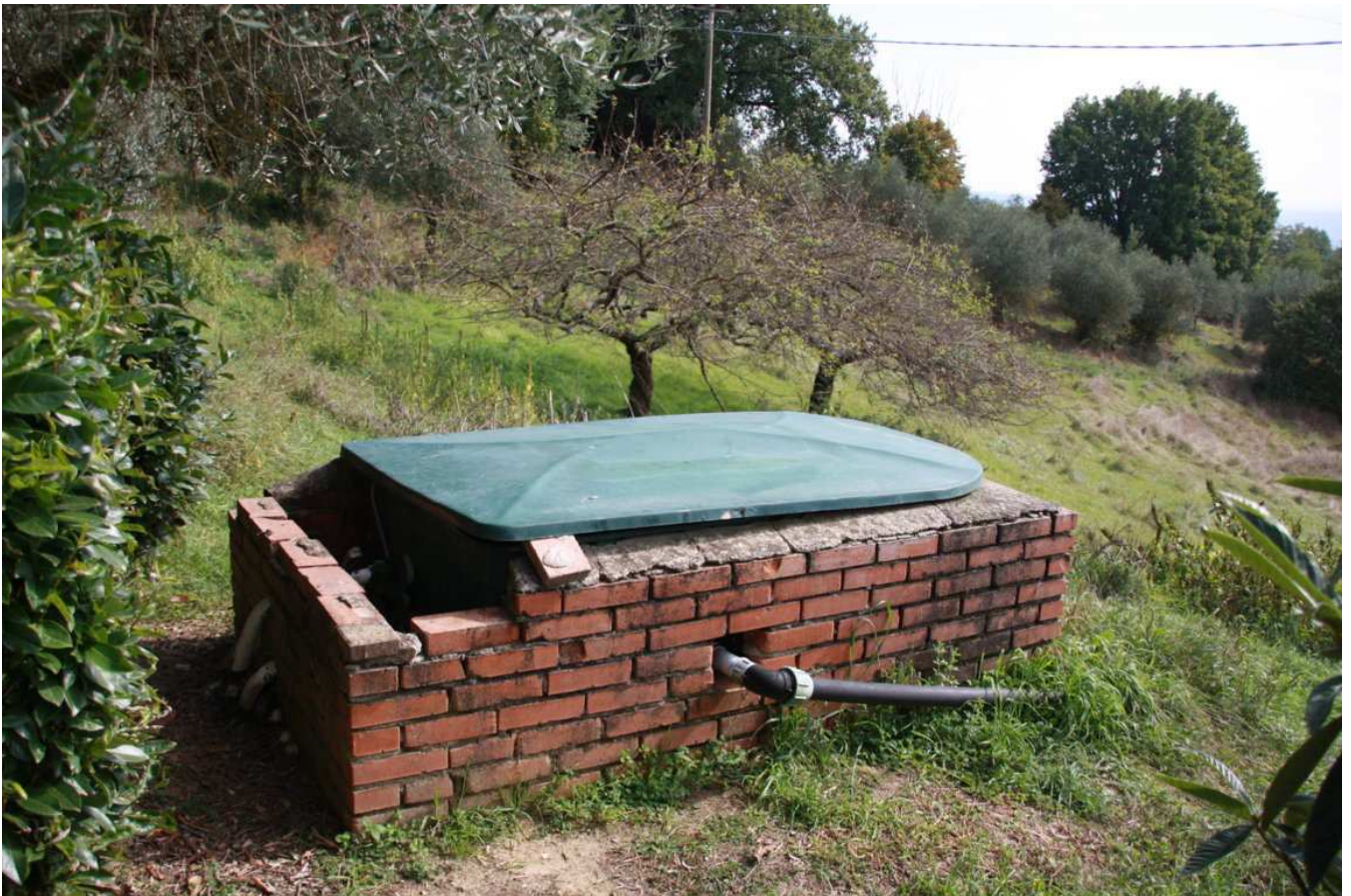
Foto n. 62 - vano tecnico della piscina
