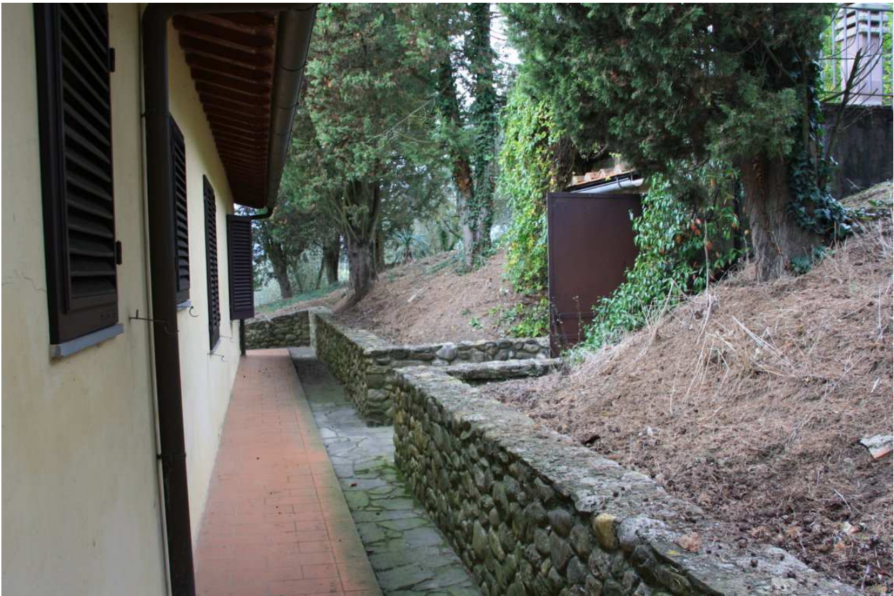
Foto n. 7 - Fabbricato "Poggetti" – prospetto tergale e accesso alla centrale termica
