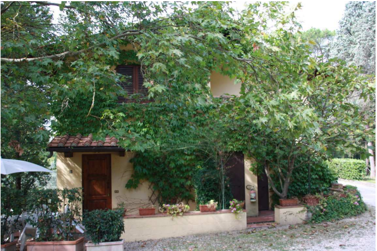
Foto n. 17 – edificio “Alberi” vista del prospetto sinistro (sud est)
