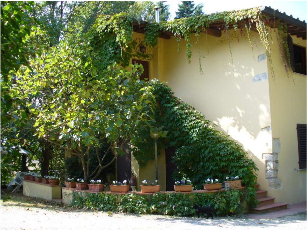
Foto n. 18 - edificio “Alberi” vista di una delle scale di accesso al piano primo
