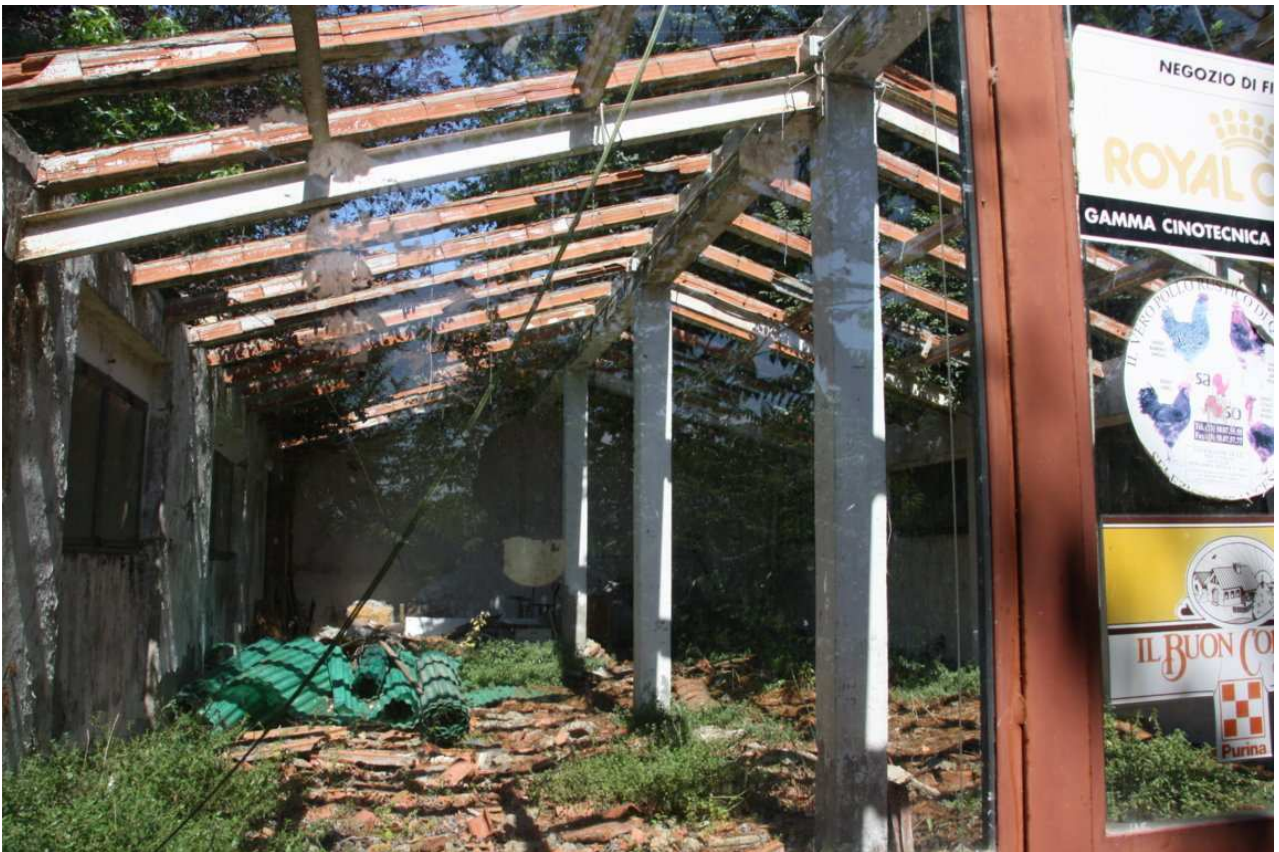
Foto n. 45 - edificio principale - magazzini al P.T. - capannone
