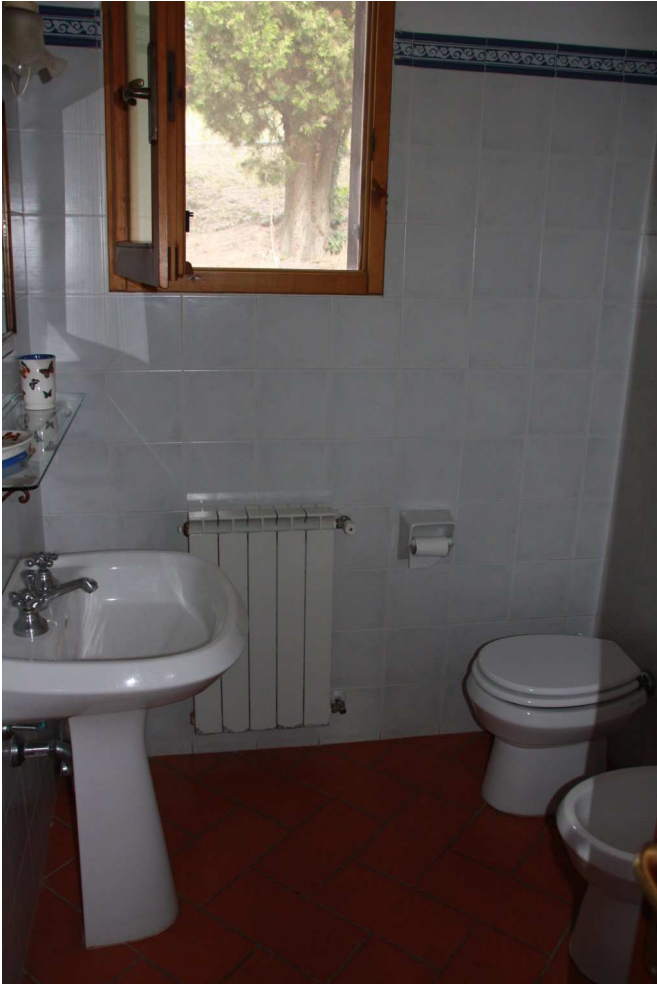
Foto n. 11 – Fabbricato “Poggetti” – bagno di uno degli appartamenti
