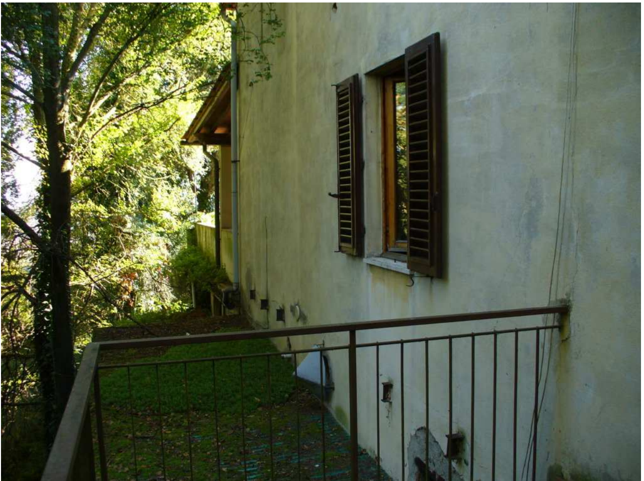
Foto n. 58 - edificio principale - civile abitazione - terrazza tergaie con accesso dalla camera
