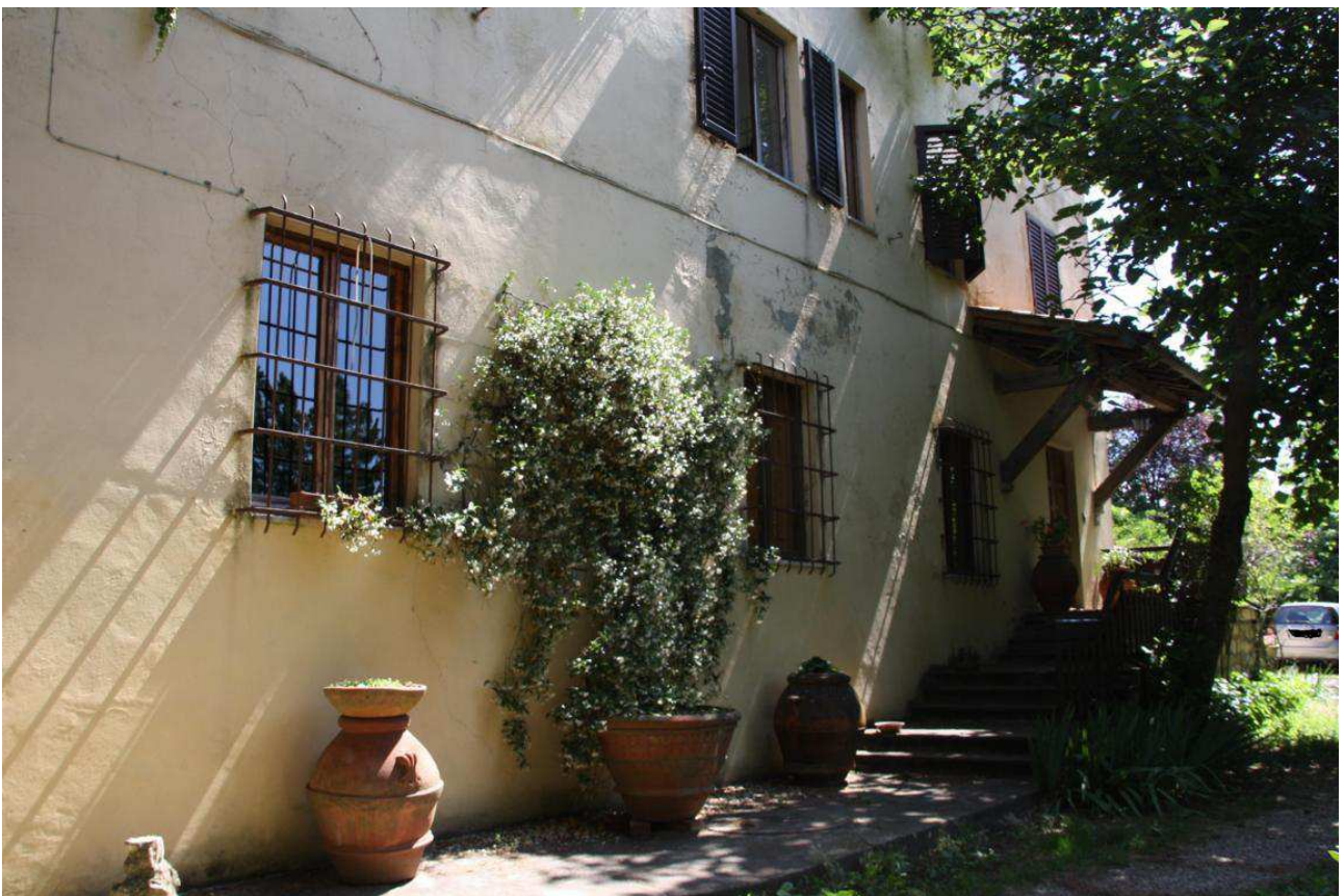
Foto n. 48 - edificio principale - ingresso all'abitazione rurale
