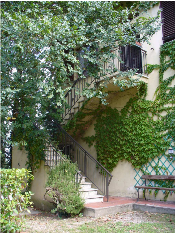
Foto n. 31- edificio principale "Boschetto 2" - scala di accesso
