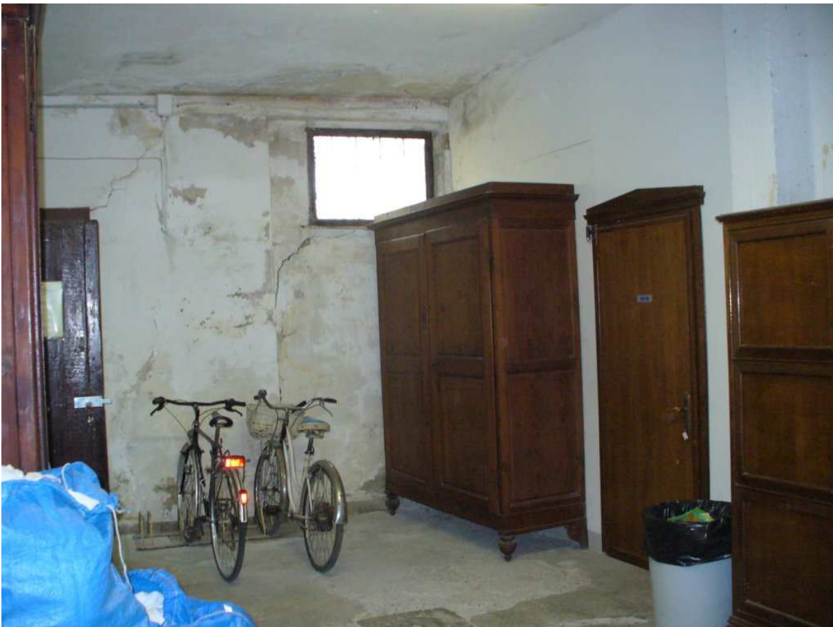
Foto n. 40 - edificio principale - deposito
