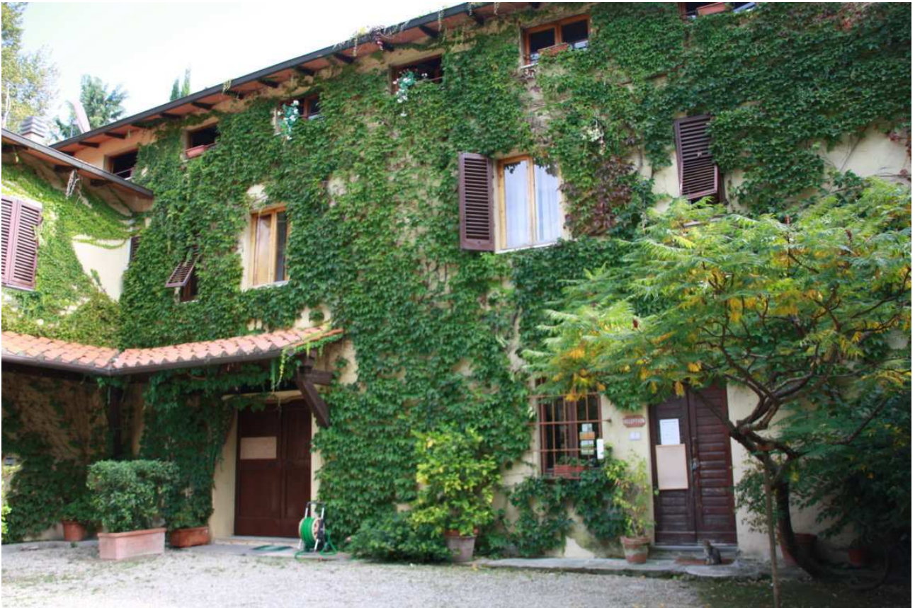
Foto n. 35 - edificio principale – accessi ai magazzini al P.T. (locali ricreativi e reception a destra)
