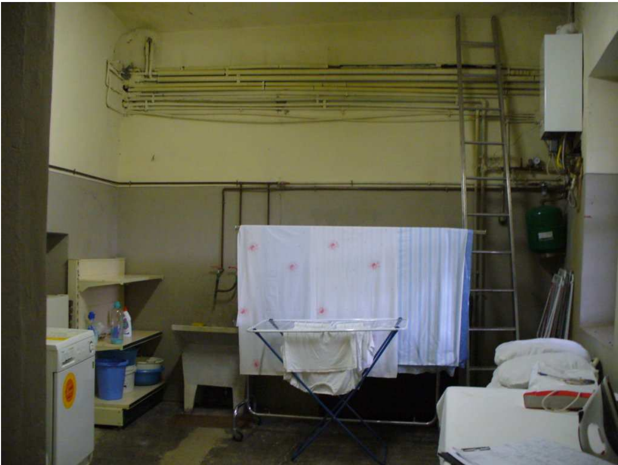
Foto n. 41 - edificio principale - magazzini P.T. (lavanderia)
