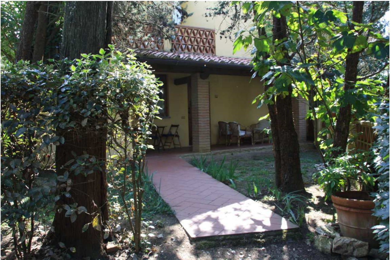
Foto n. 15 - edificio "Alberi" vista del prospetto nord ovest
