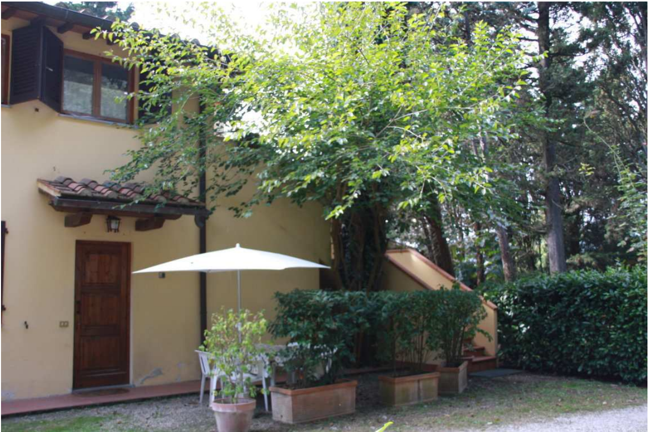
Foto n. 21 – edificio “Alberi” vista del prospetto principale
