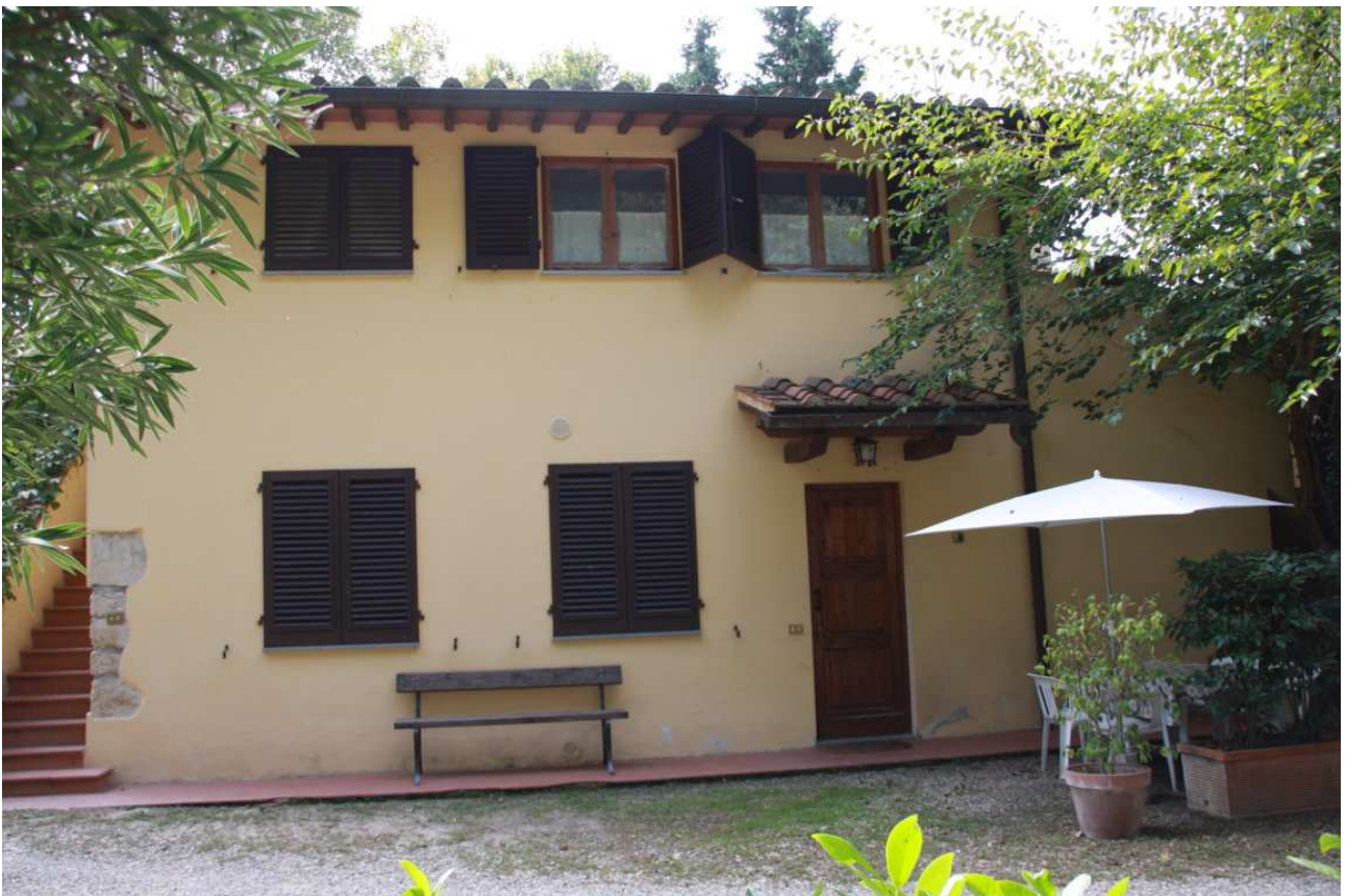
Foto n. 16 - edificio "Alberi" vista del prospetto principale
