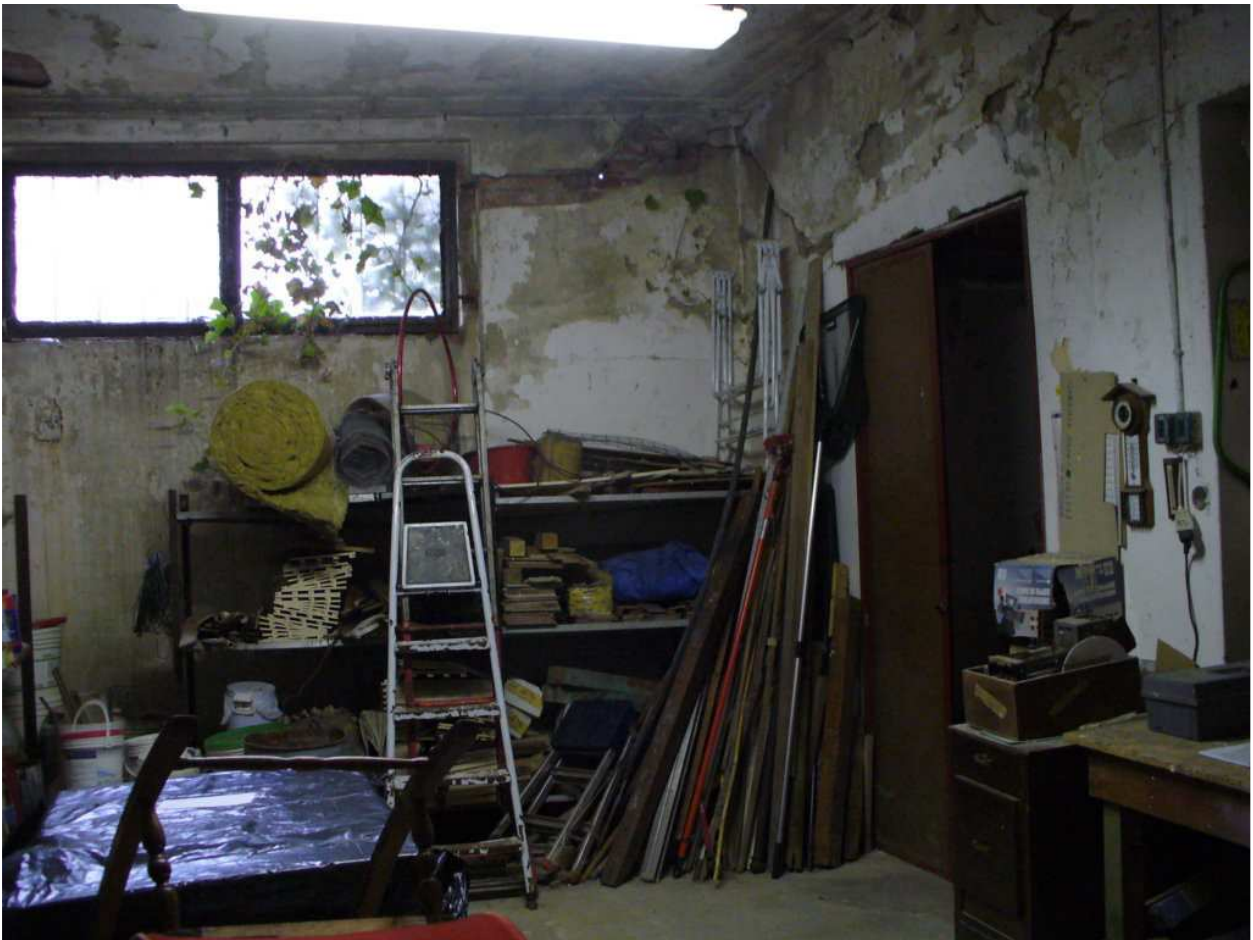
Foto n. 43 - edificio principale - magazzino tergaie
