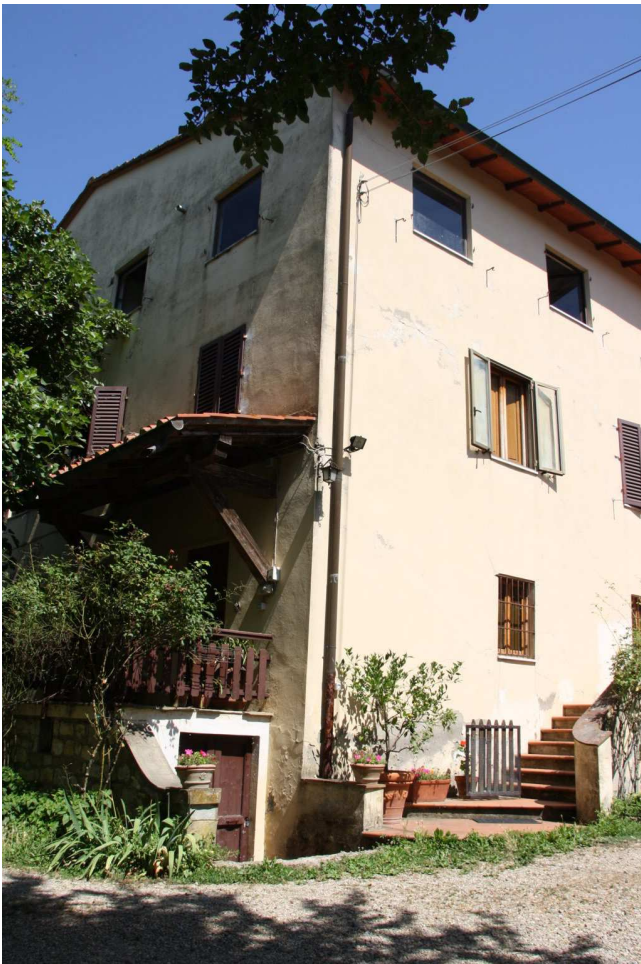
Foto n. 49 - edificio principale - ingresso alla cantina dell'abitazione rurale
