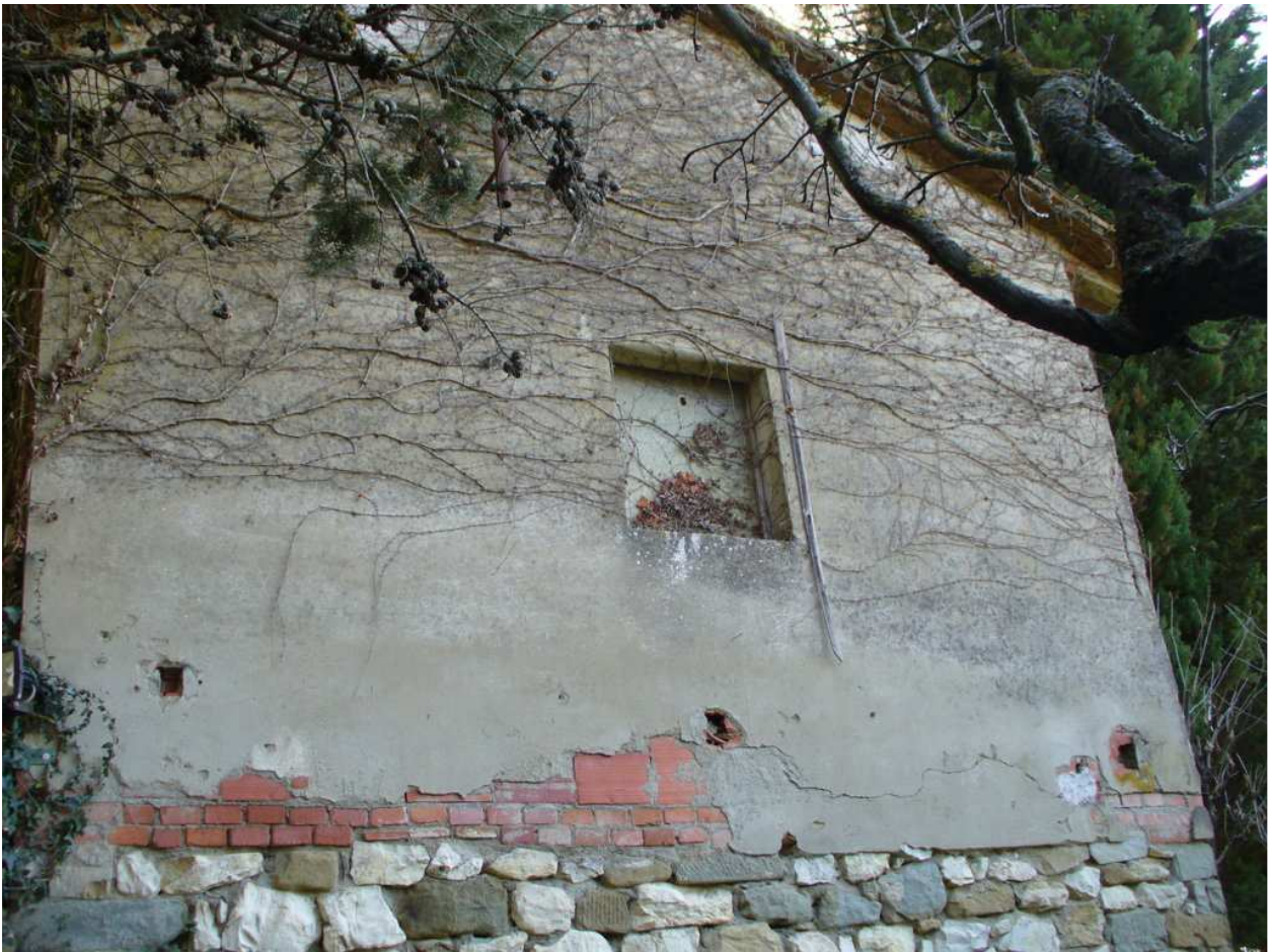
Foto n. 13 – magazzino isolato retro
