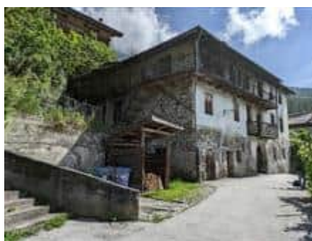
Foto n° 2: Vista fronte sud e ovest
