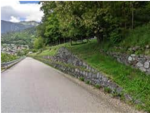
Foto n° 60: Accesso alla p.f. 1126 dalla p.f. 1127, vista in direzione nord-ovest
