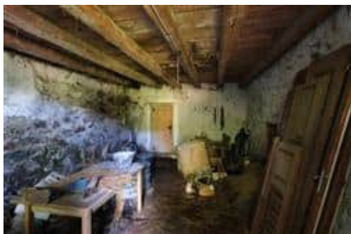
Foto n° 11: Piano primo, deposito
