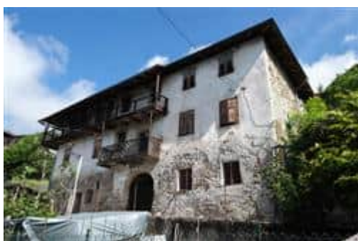
Foto n° 1: Vista fronte sud
