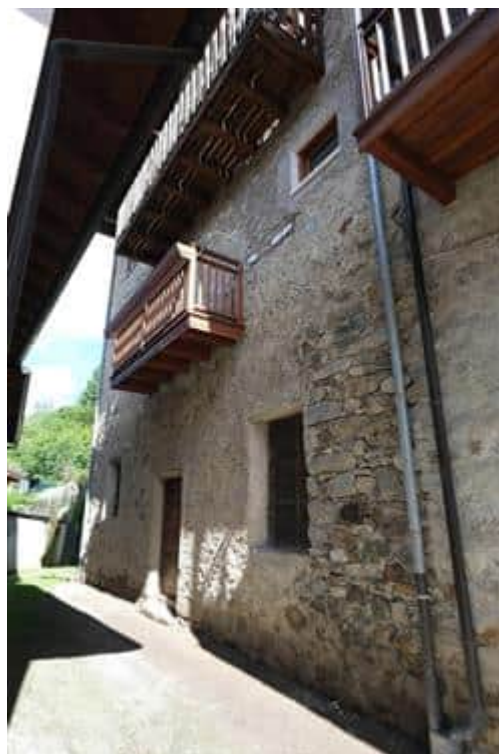
Foto n° 24: Vista fronte sud
