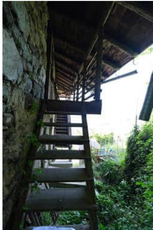
Foto n° 4: Fronte ovest - Scala di accesso al secondo piano
