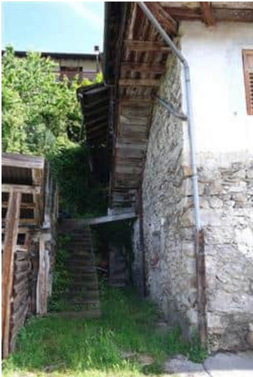
Foto n° 3: Fronte ovest - Scala di accesso al primo piano
