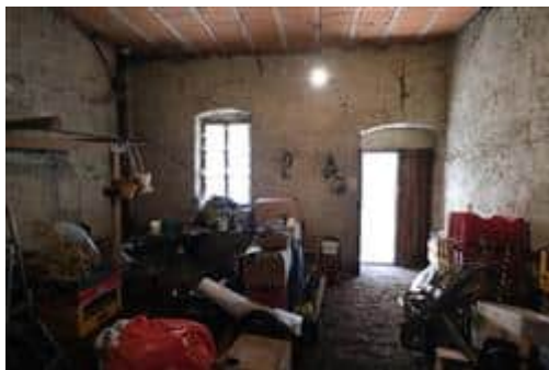
Foto n° 25: Piano seminterrato, cantina sud
