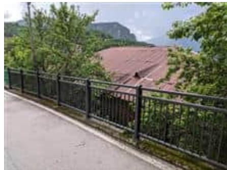
Foto n° 3: Vista fronte nord
