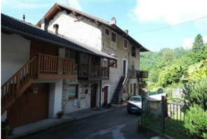
Foto n° 21: Vista d'insieme fronte nord
