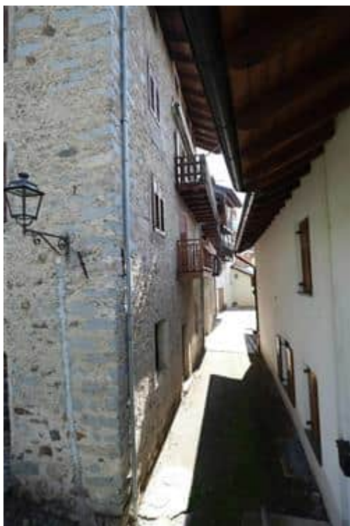
Foto n° 23: Vista d'insieme fronte sud
