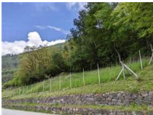
Foto n° 61: P.f. 1125 e 1122, vista in direzione nord-ovest
