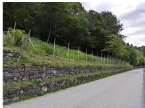
Foto n° 62: P.f. 1125, vista in direzione est
