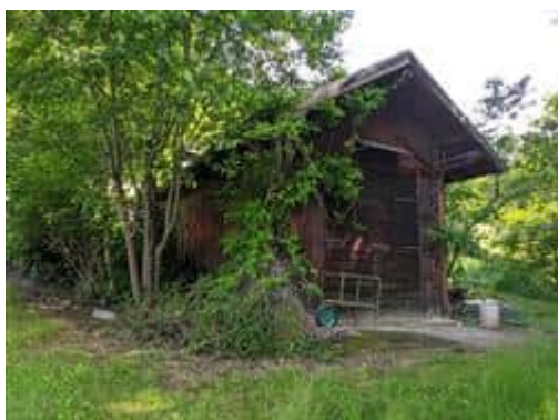
Foto n° 47: Vista fronte sud e ovest
