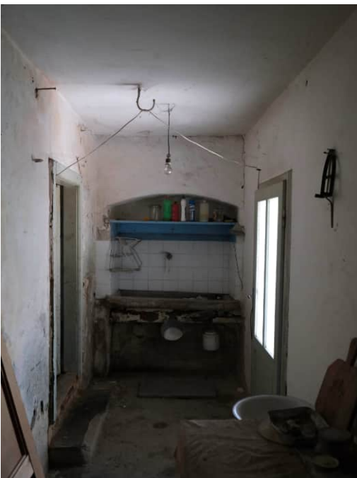
Foto n° 17: Piano primo, dispensa
