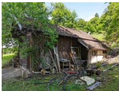
Foto n° 48: Vista fronte est
