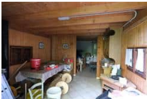
Foto n° 50: Piano terra, vano sud
