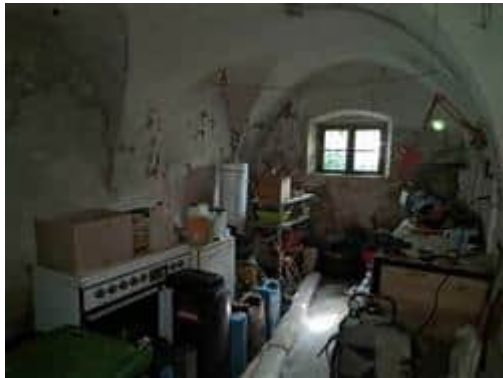
Foto n° 7: Piano terra, avvolto nord-est
