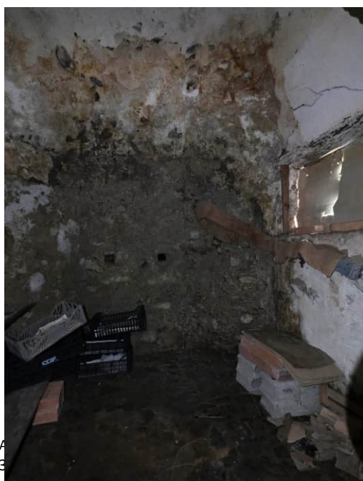
Foto n° 18: Piano primo, ripostiglio
