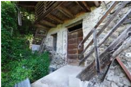
Foto n° 5: Fronte ovest - Accesso al deposito di primo piano
