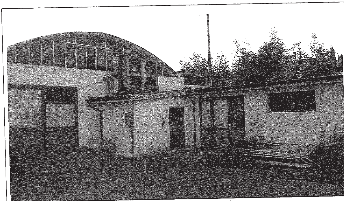
Immagine 7 – Prospetto Est e centrale termica a comune
