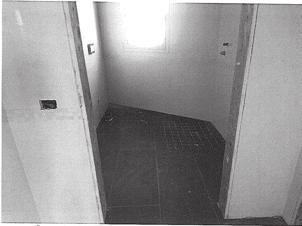
Immagine 17 – Piano secondo – porzione commerciale (sub.505) Locale bagni da completare
