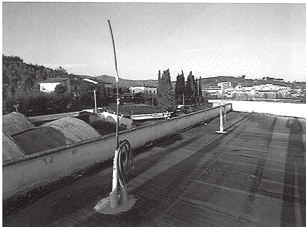
Immagine 10 – Copertura della parte artigianale (piano secondo)
