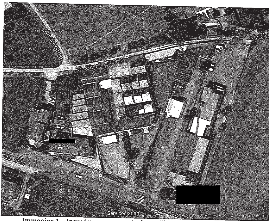
Immagine 1 – Inquadramento generale da satellite dei lotti oggetto di perizia
