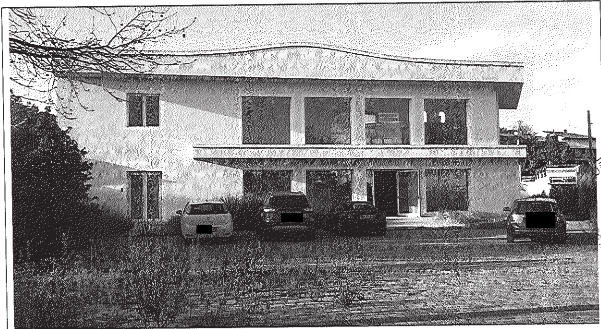
Immagine 3 – Prospetto Sud del fabbricato
