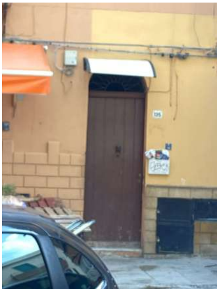
Portone di accesso sulla via Montalbo
