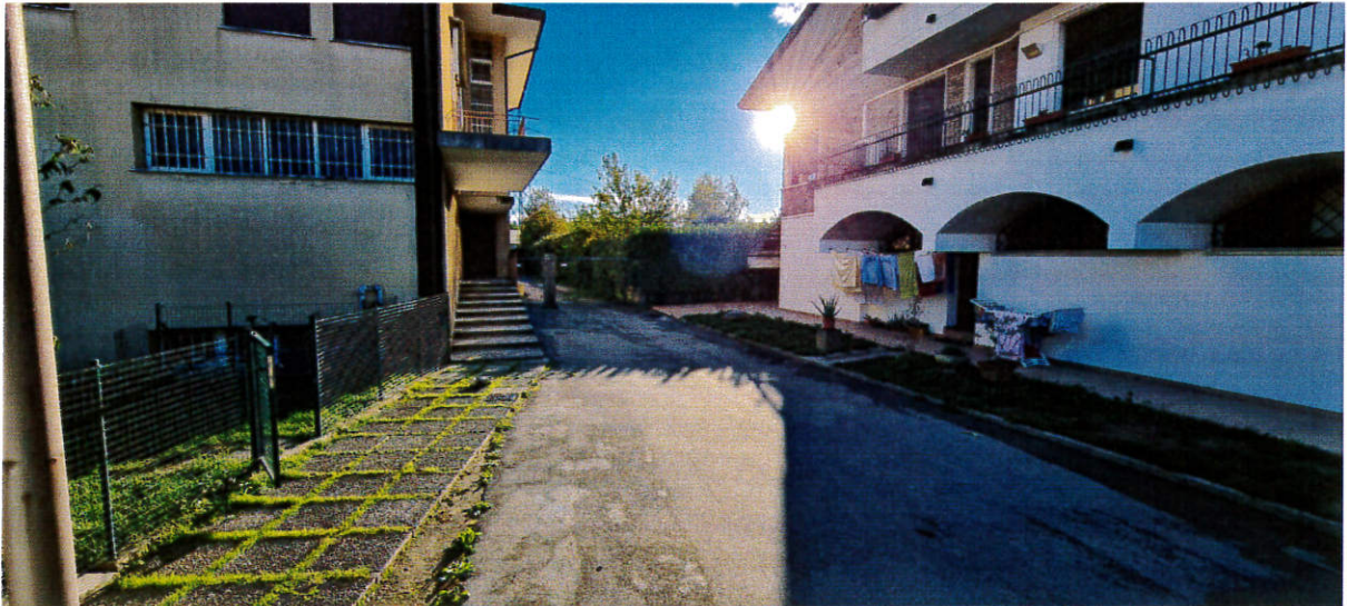
Vista del passaggio promiscuo dal cancello carrabile posto ad ovest
