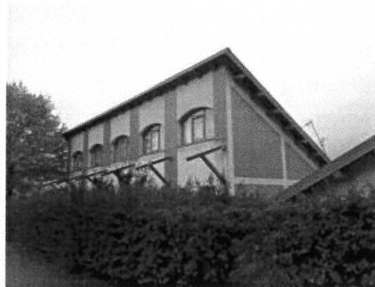
Vista fabbricato su part. 132
