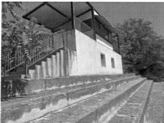
Vista fabbricato su part. 169
