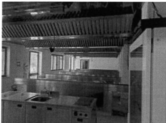
Vista fabbricato su part. 160
