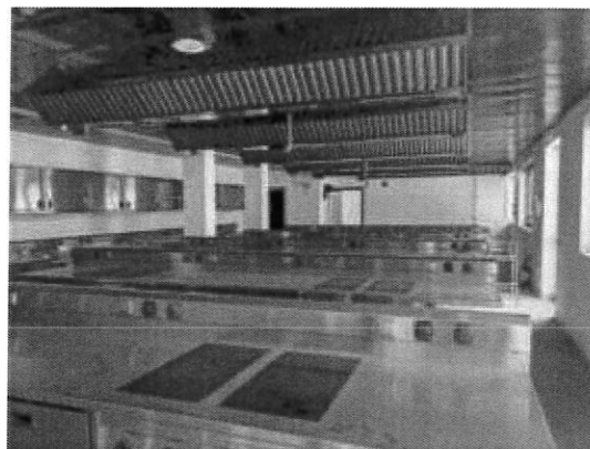
Vista fabbricato su part. 160
