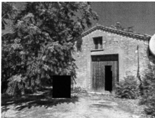
Vista fabbricato su part. 158
