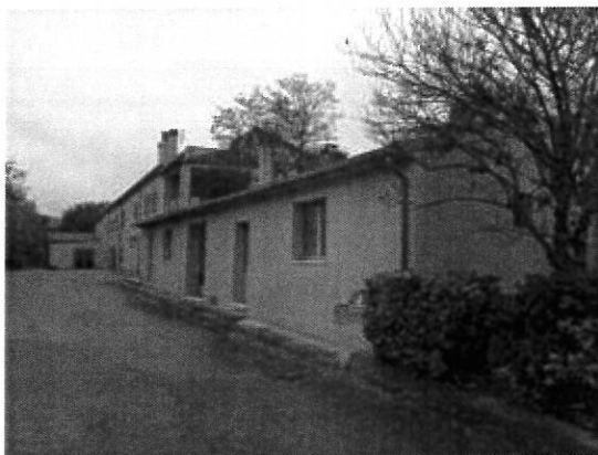
Vista fabbricato su part. 157
