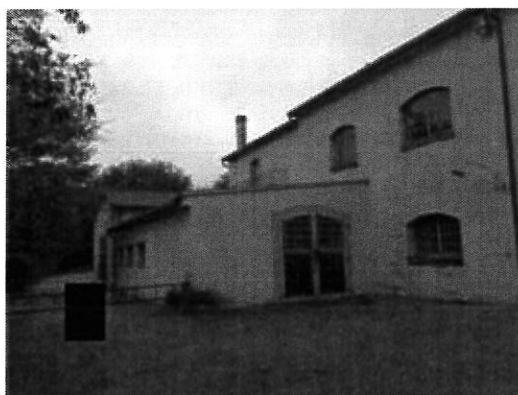
Vista fabbricato su part. 138
