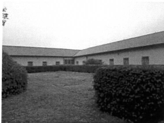
Vista fabbricato su part. 131
