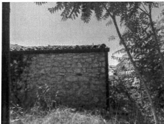
Vista fabbricato su part. 161
