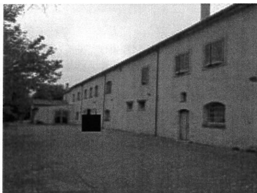
Vista fabbricato su part. 138
