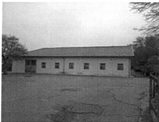
Vista fabbricato su part. 131
