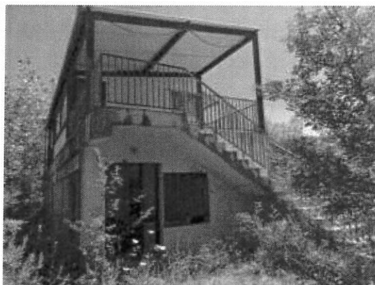
Vista fabbricato su part. 169
