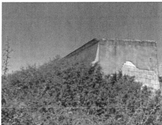
Vista fabbricato su part. 169
