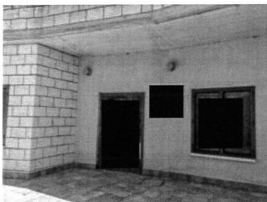
Vista fabbricato su part. 162
