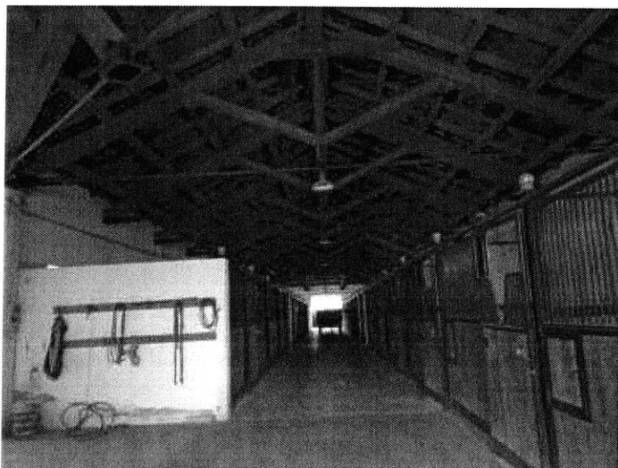
Foto n. 73 – Fabbricato ricadente sulla part. 131
