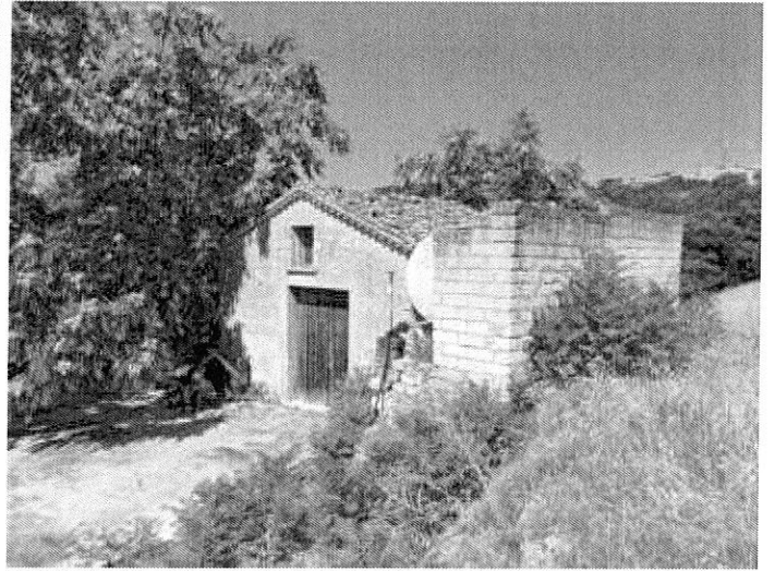
Foto n. 112 – Fabbricato ricadente sulla part. 158
