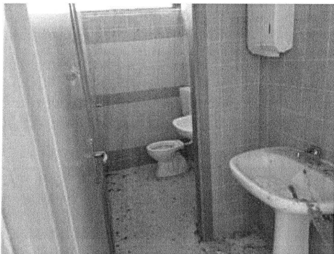
Foto n. 141 – Fabbricato ricadente sulla part. 169
