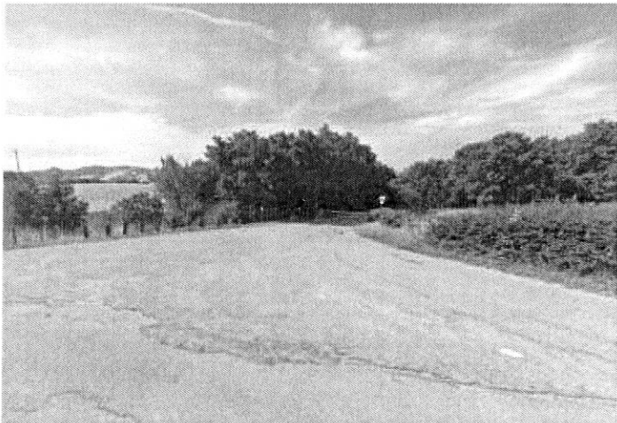
Foto n. 3 – Vista accesso compendio immobiliare
