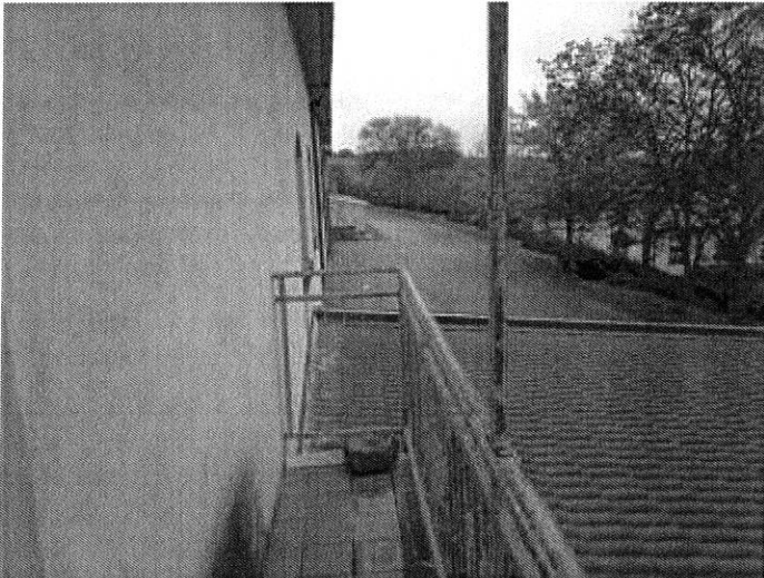
Foto n. 59 – Fabbricato ricadente sulla part. 138 – piano primo
