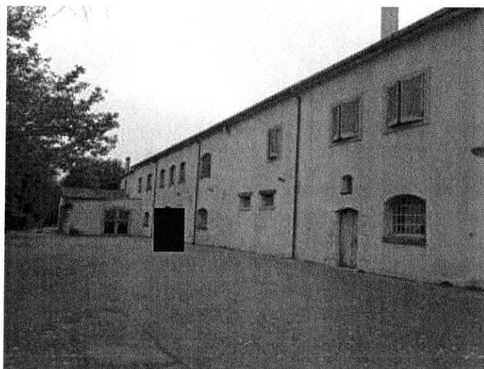
Foto n. 10 – Fabbricato ricadente sulla part. 138 – vista esterna
