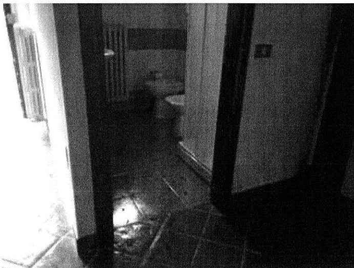
Foto n. 109 – Fabbricato ricadente sulla part. 132 – piano primo
