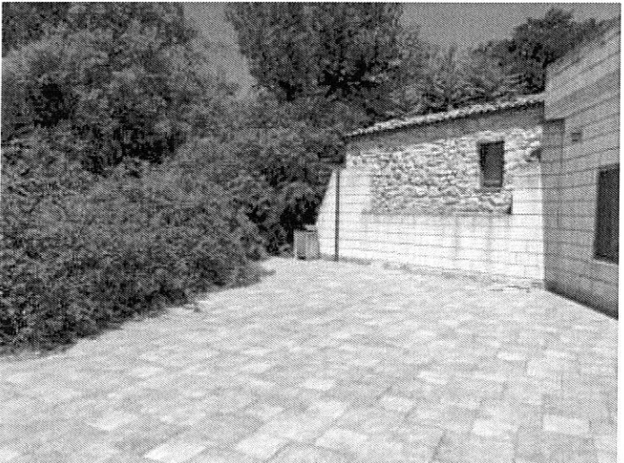
Foto n. 125 – Fabbricato ricadente sulla part. 161
