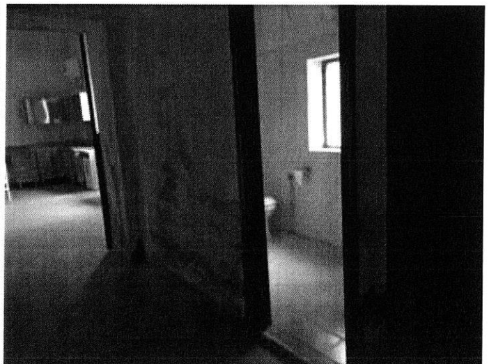
Foto n. 38 – Fabbricato ricadente sulla part. 138 – piano terra
