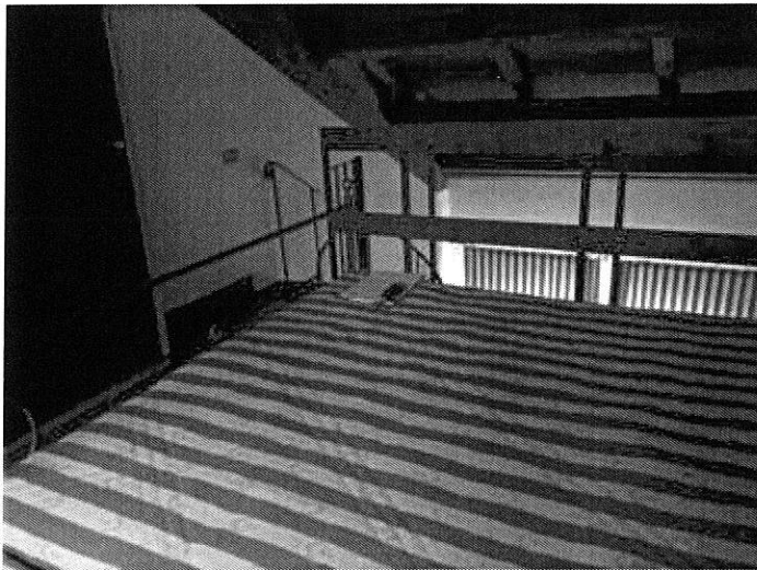
Foto n. 101 – Fabbricato ricadente sulla part. 132 – piano primo
