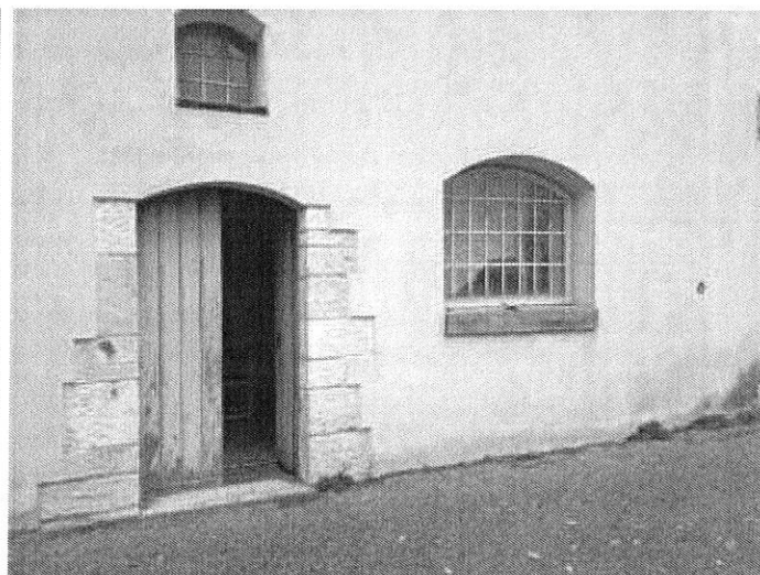
Foto n. 24 – Fabbricato ricadente sulla part. 138 – piano terra
