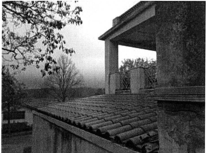
Foto n. 62 – Fabbricato ricadente sulla part. 138 – piano primo
