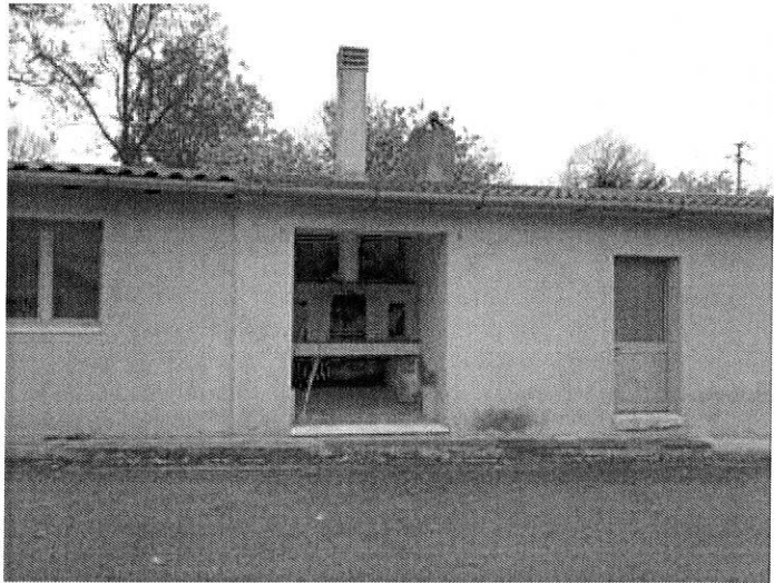
Foto n. 64 – Fabbricato ricadente sulla part. 157
