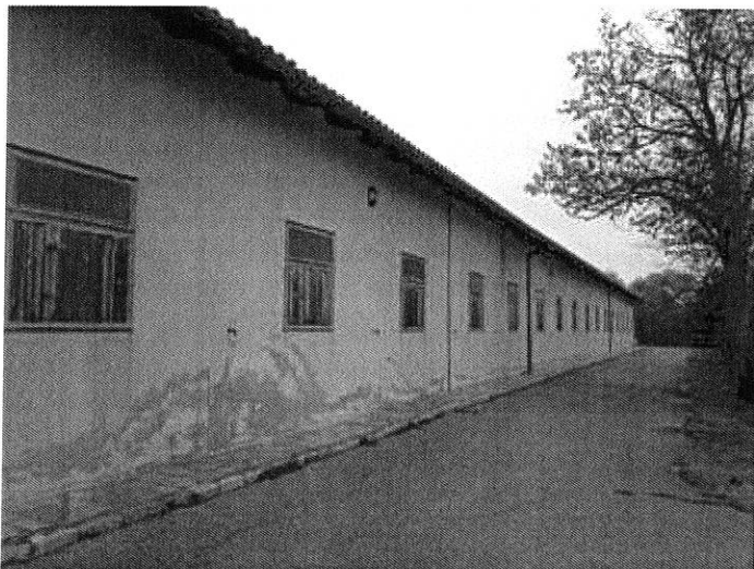
Foto n. 71 – Fabbricato ricadente sulla part. 131
