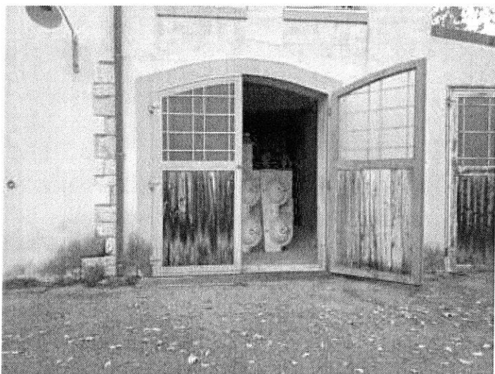
Foto n. 21 – Fabbricato ricadente sulla part. 138 – piano terra
