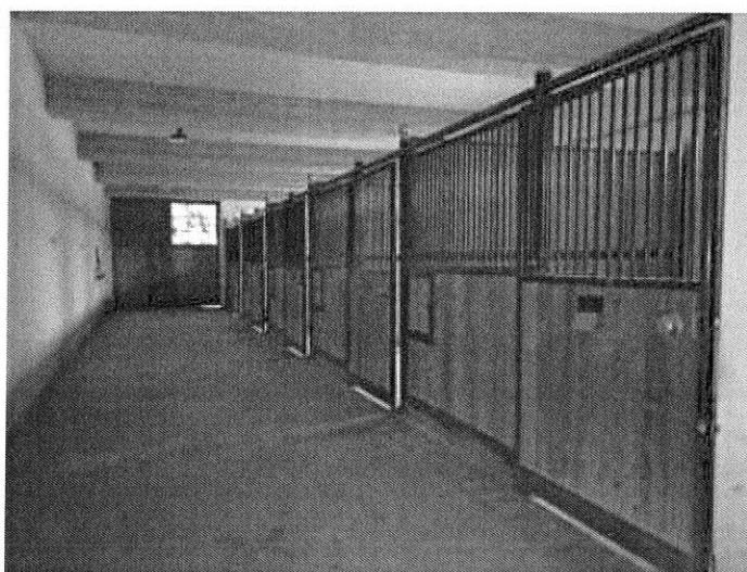
Foto n. 88 – Fabbricato ricadente sulla part. 132 – piano terra
