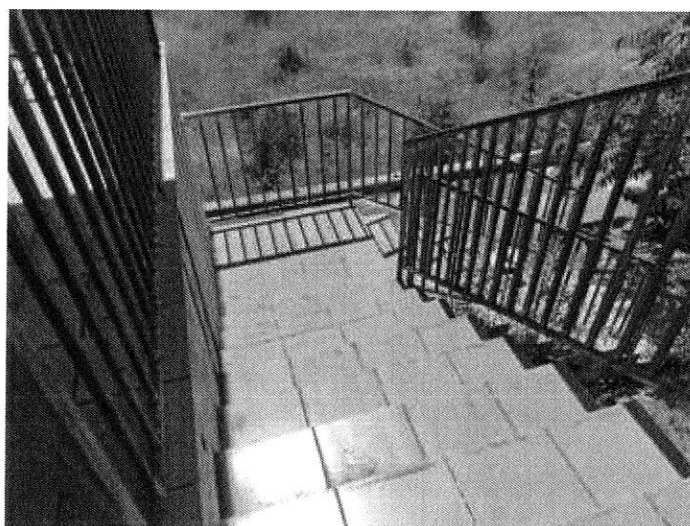
Foto n. 146 – Fabbricato ricadente sulla part. 169
