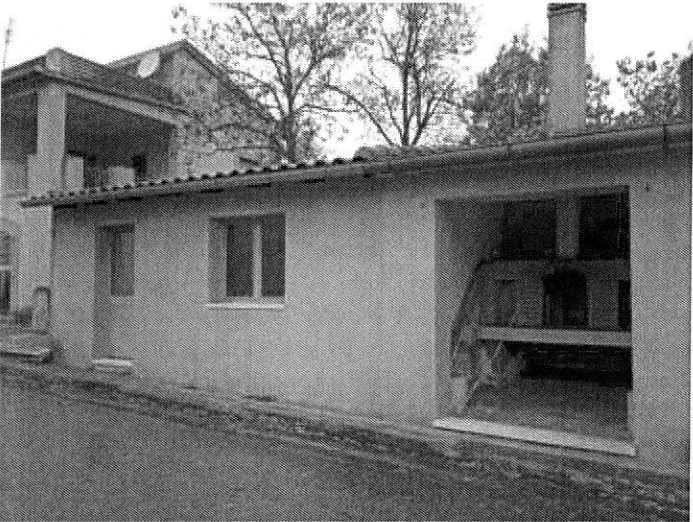
Foto n. 65 – Fabbricato ricadente sulla part. 157
