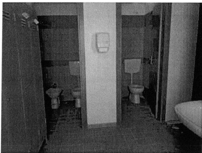
Foto n. 123 – Fabbricato ricadente sulla part. 160
