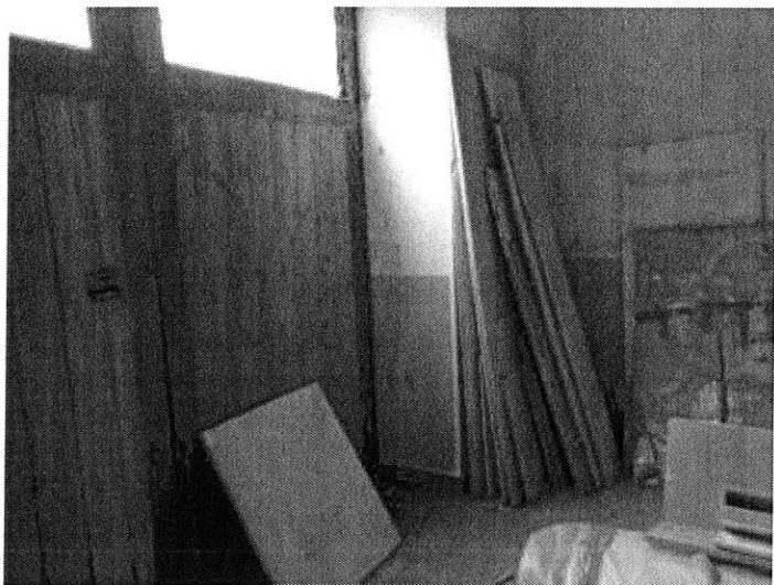
Foto n. 45 – Fabbricato ricadente sulla part. 138 – piano terra
