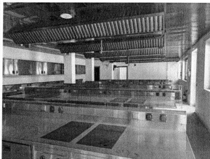
Foto n. 118 – Fabbricato ricadente sulla part. 160
