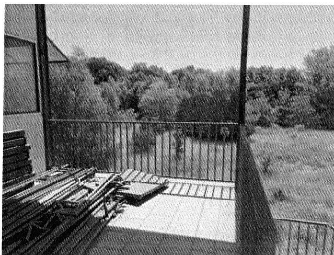
Foto n. 142 – Fabbricato ricadente sulla part. 169
