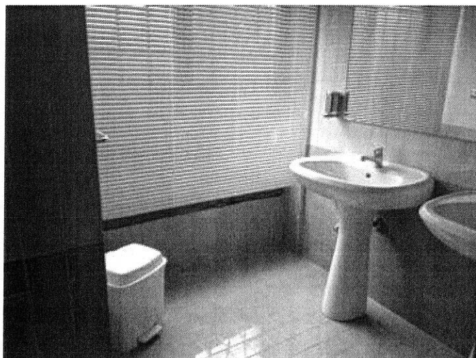
Foto n. 49 – Fabbricato ricadente sulla part. 138 – piano primo
