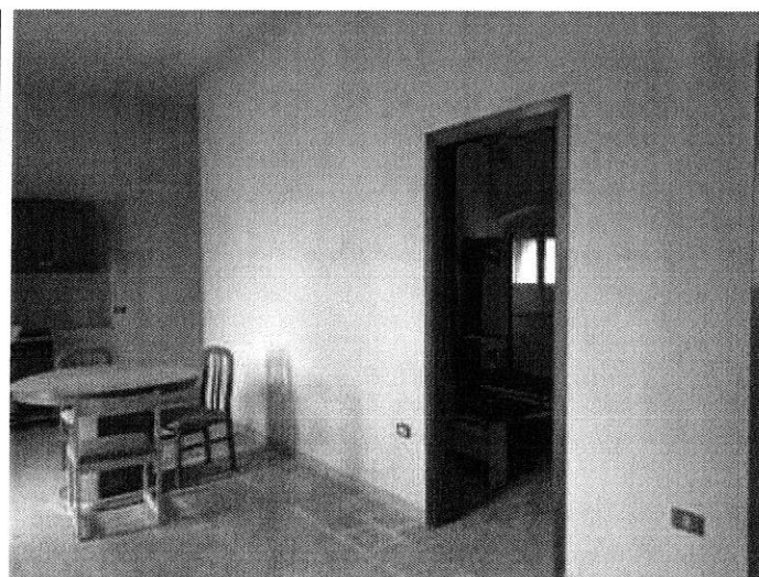
Foto n. 26 – Fabbricato ricadente sulla part. 138 – piano terra
