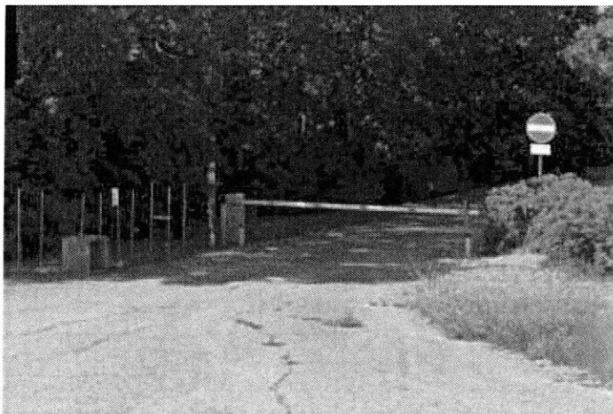
Foto n. 4 – Vista accesso compendio immobiliare
