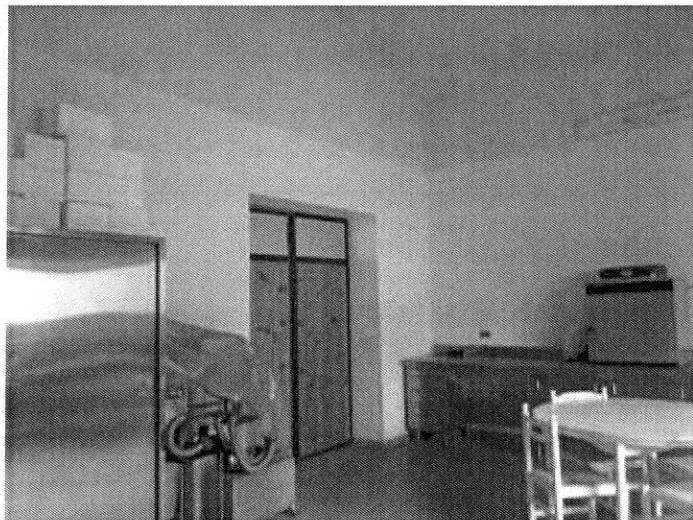
Foto n. 42 – Fabbricato ricadente sulla part. 138 – piano terra
