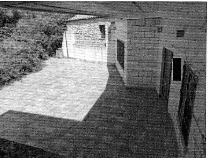
Foto n. 128 – Fabbricato ricadente sulla part. 161
