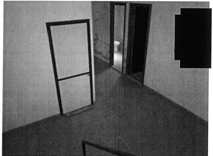
Foto n. 36 – Fabbricato ricadente sulla part. 138 – piano terra
