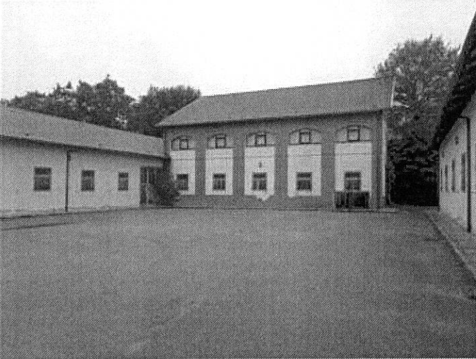
Foto n. 77 – Fabbricato ricadente sulla part. 132
