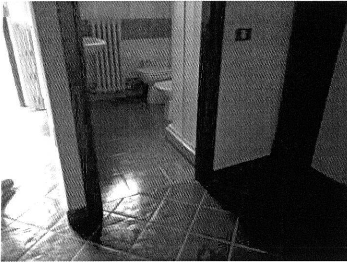
Foto n. 99 – Fabbricato ricadente sulla part. 132 – piano primo
