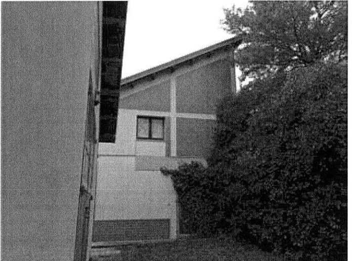
Foto n. 80 – Fabbricato ricadente sulla part. 132
