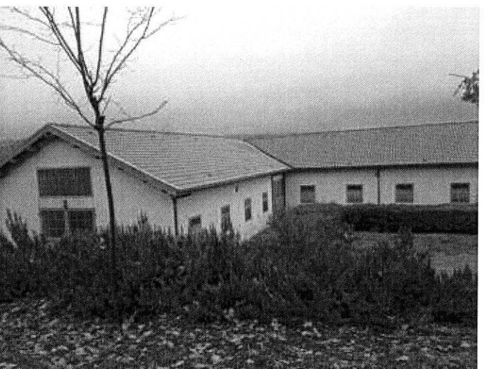
Foto n. 68 – Fabbricato ricadente sulla part. 131
