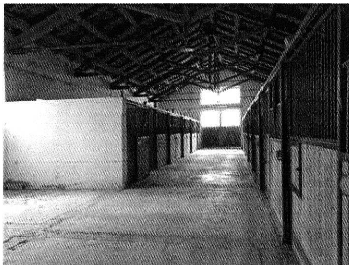
Foto n. 86 – Fabbricato ricadente sulla part. 132 – piano terra
