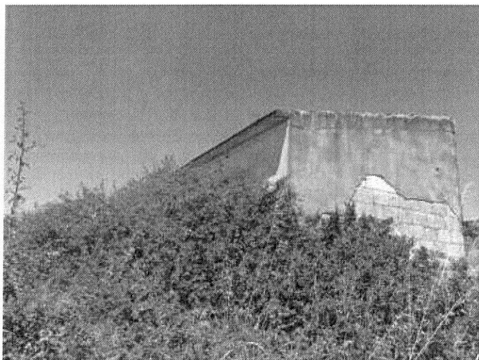
Foto n. 149 – Fabbricato ricadente sulla part. 139
