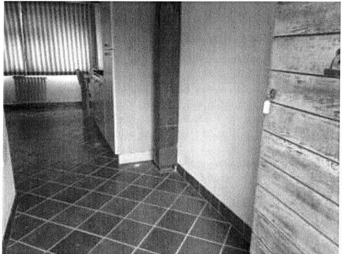
Foto n. 108 – Fabbricato ricadente sulla part. 132 – piano primo
