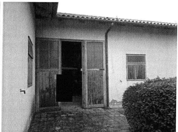
Foto n. 72 – Fabbricato ricadente sulla part. 131
