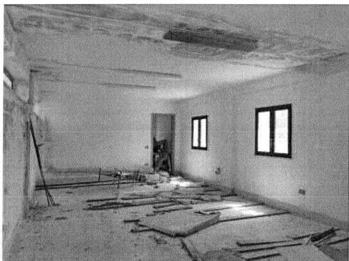
Foto n. 139 – Fabbricato ricadente sulla part. 169
