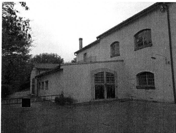
Foto n. 11 – Fabbricato ricadente sulla part. 138 – vista esterna
