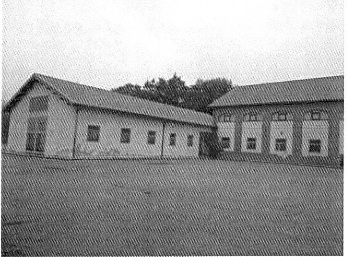
Foto n. 78 – Fabbricato ricadente sulla part. 132
