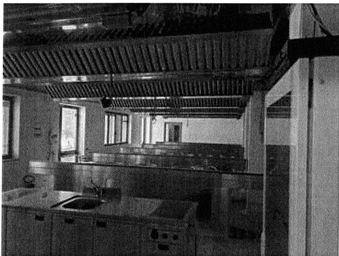
Foto n. 119 – Fabbricato ricadente sulla part. 160
