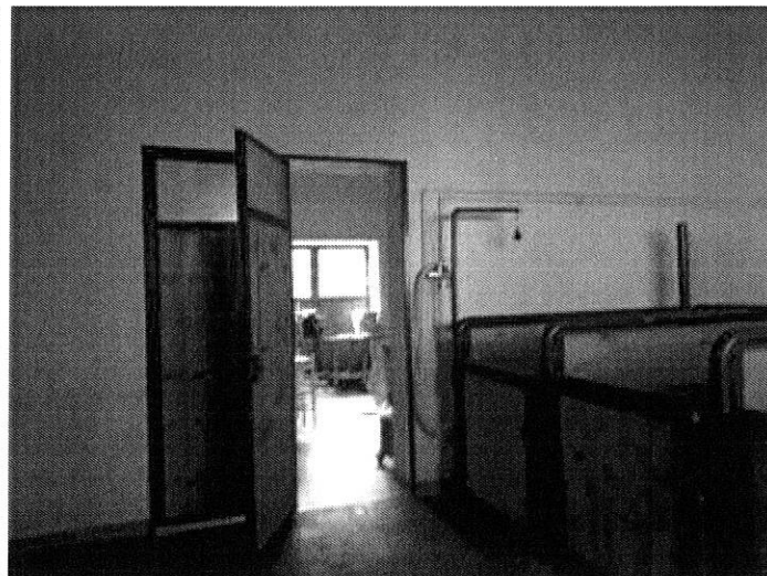
Foto n. 44 – Fabbricato ricadente sulla part. 138 – piano terra
