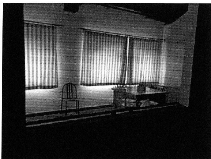
Foto n. 90 – Fabbricato ricadente sulla part. 132 – piano primo
