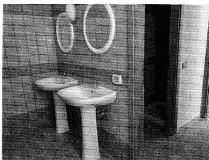
Foto n. 122 – Fabbricato ricadente sulla part. 160
