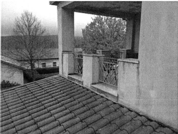
Foto n. 61 – Fabbricato ricadente sulla part. 138 – piano primo
