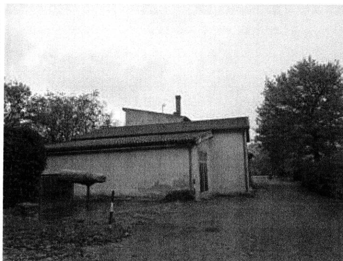
Foto n. 14 – Fabbricato ricadente sulla part. 138 – vista esterna
