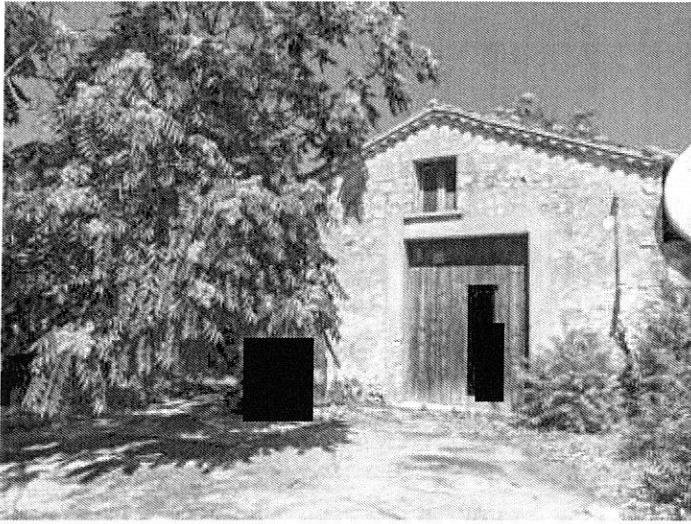
Foto n. 111 – Fabbricato ricadente sulla part. 158
