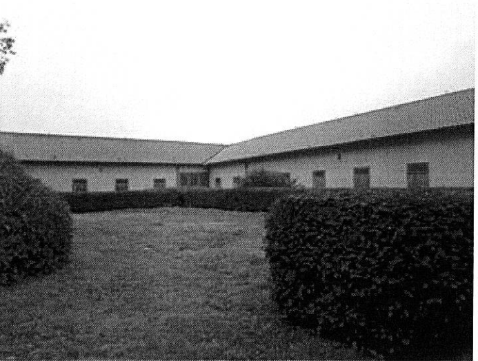
Foto n. 67 – Fabbricato ricadente sulla part. 131
