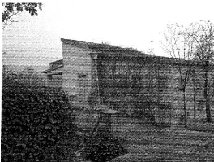
Foto n. 17 – Fabbricato ricadente sulla part. 138 – vista esterna
