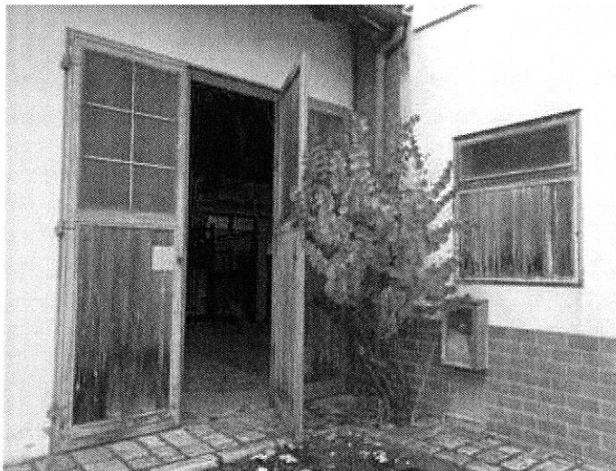
Foto n. 84 – Fabbricato ricadente sulla part. 132 – piano terra
