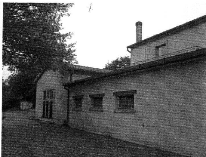
Foto n. 12 – Fabbricato ricadente sulla part. 138 – vista esterna
