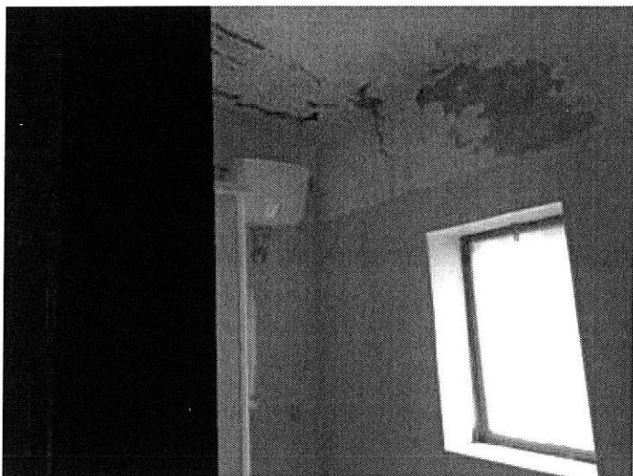
Foto n. 39 – Fabbricato ricadente sulla part. 138 – piano terra
