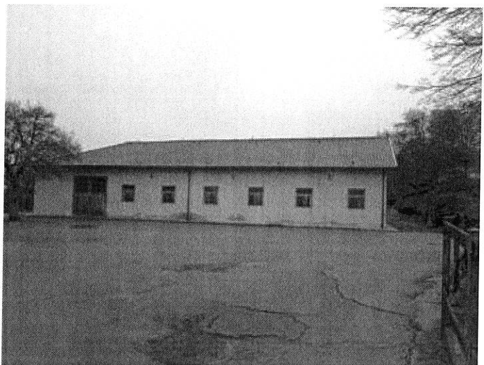
Foto n. 70 – Fabbricato ricadente sulla part. 131
