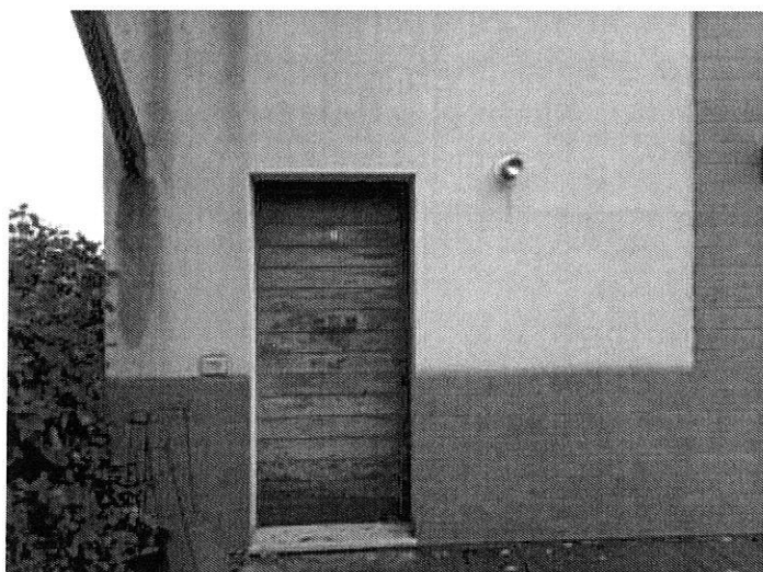
Foto n. 89 – Fabbricato ricadente sulla part. 132 – piano primo
