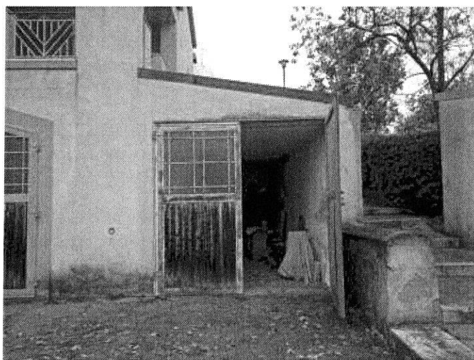
Foto n. 18 – Fabbricato ricadente sulla part. 138 – piano terra
