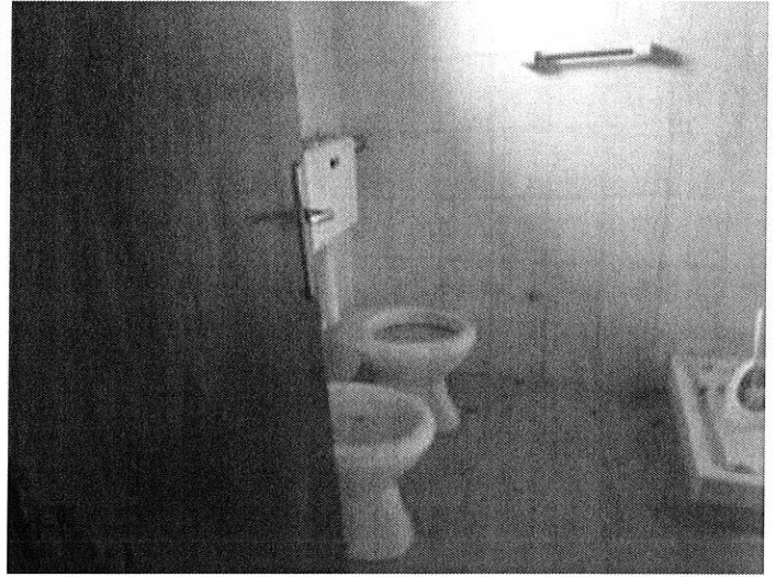
Foto n. 58 – Fabbricato ricadente sulla part. 138 – piano primo
