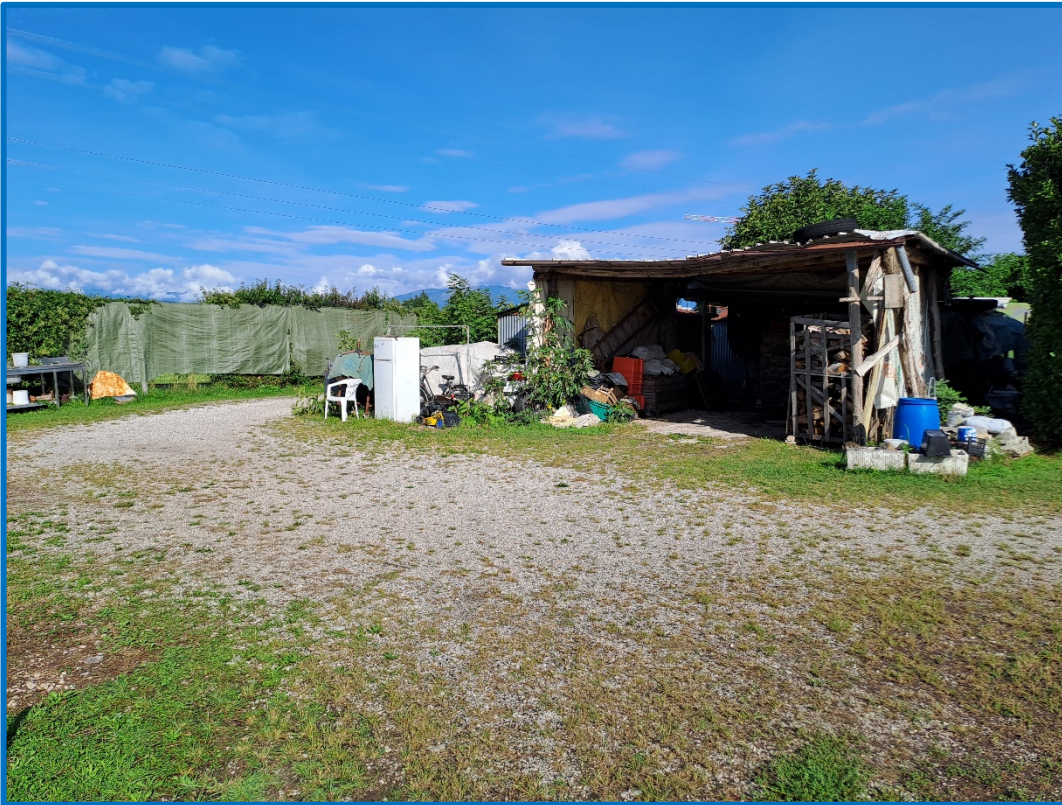
n° 11 – Scoperto con alcuni dei manufatti da demolire
