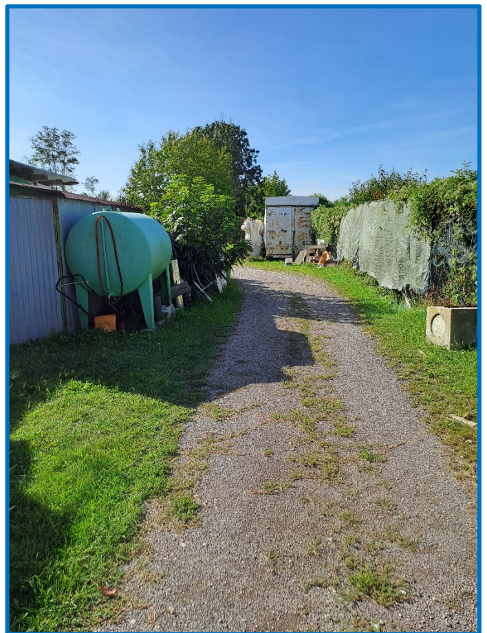
n° 12 – Scoperto con alcuni dei manufatti da demolire
