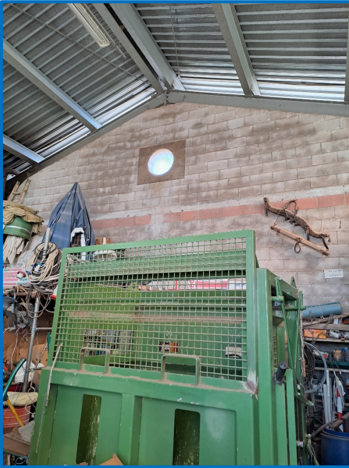
n° 5 Interno capannone
