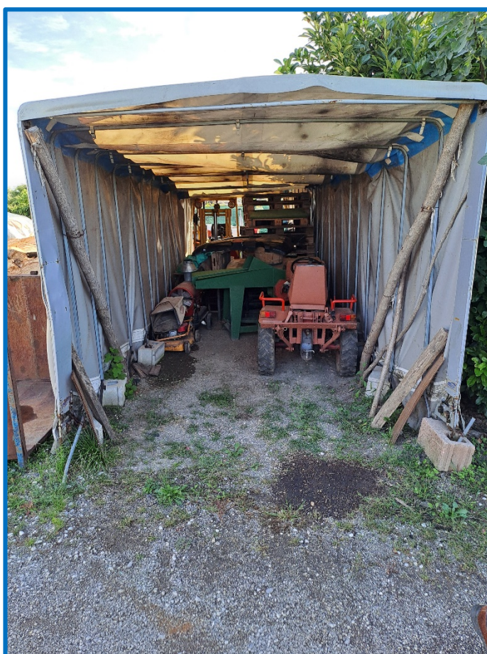
n° 14 - Manufatto da demolire
