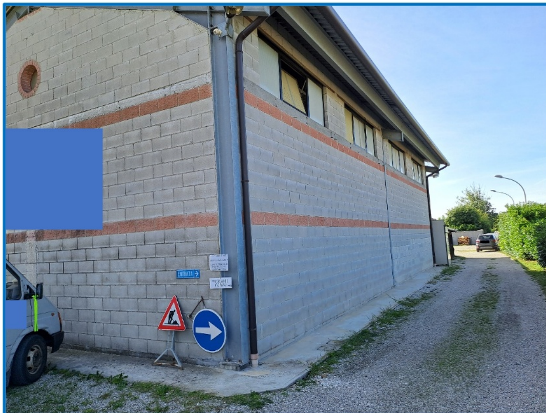
n° 3 Esterno capannone lato ovest
