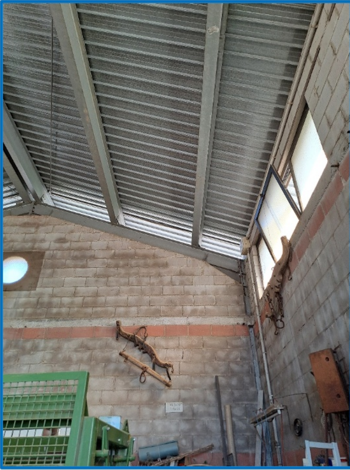
n° 7 Interno capannone
