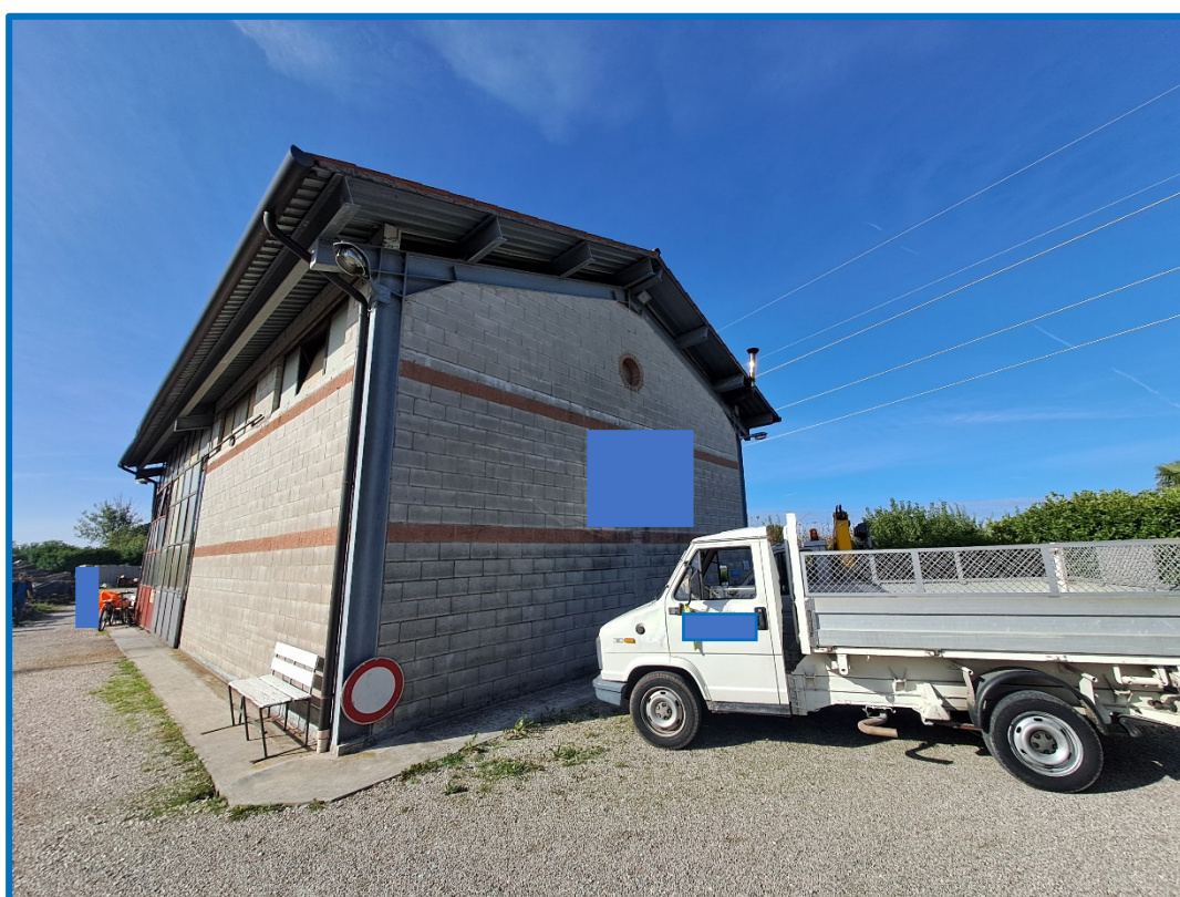
n° 2 Esterno capannone lato nord
