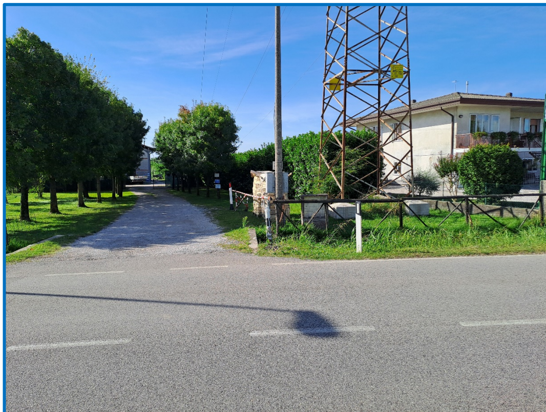
n° 1 – Accesso da via degli Alpini
