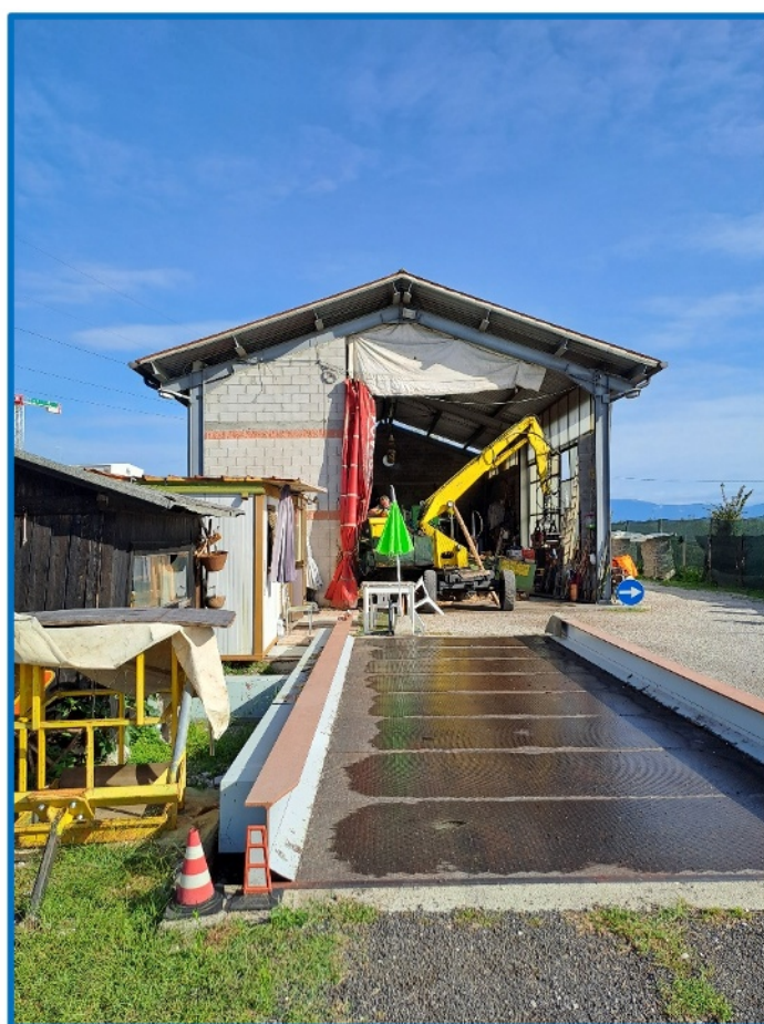
n° 4 Esterno capannone lato sud
