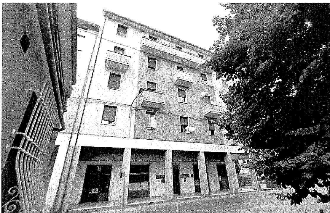
01 – Vista esterna fabbricato
