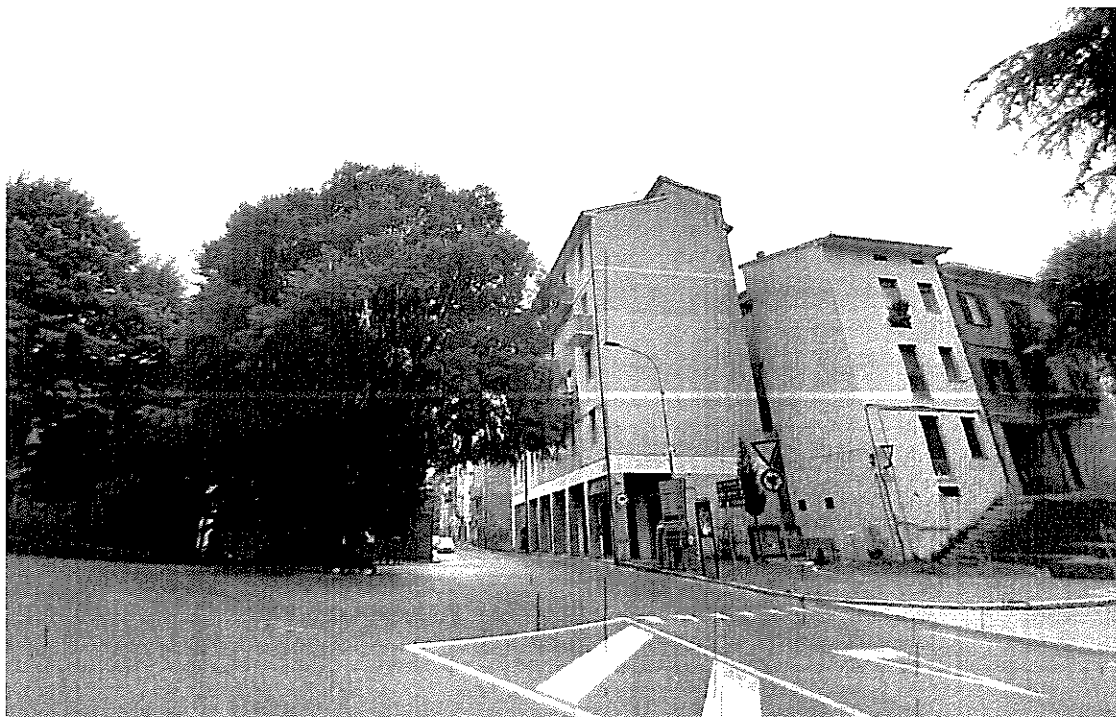
02 – Vista esterna fabbricato
