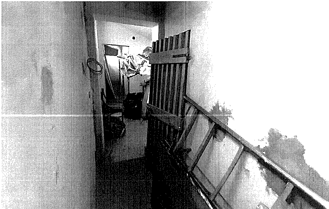
14 – Vista ingresso soffitta
