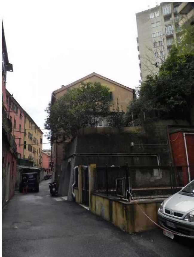
Foto 9 - Vista della palazzina su Via Ponterotto
