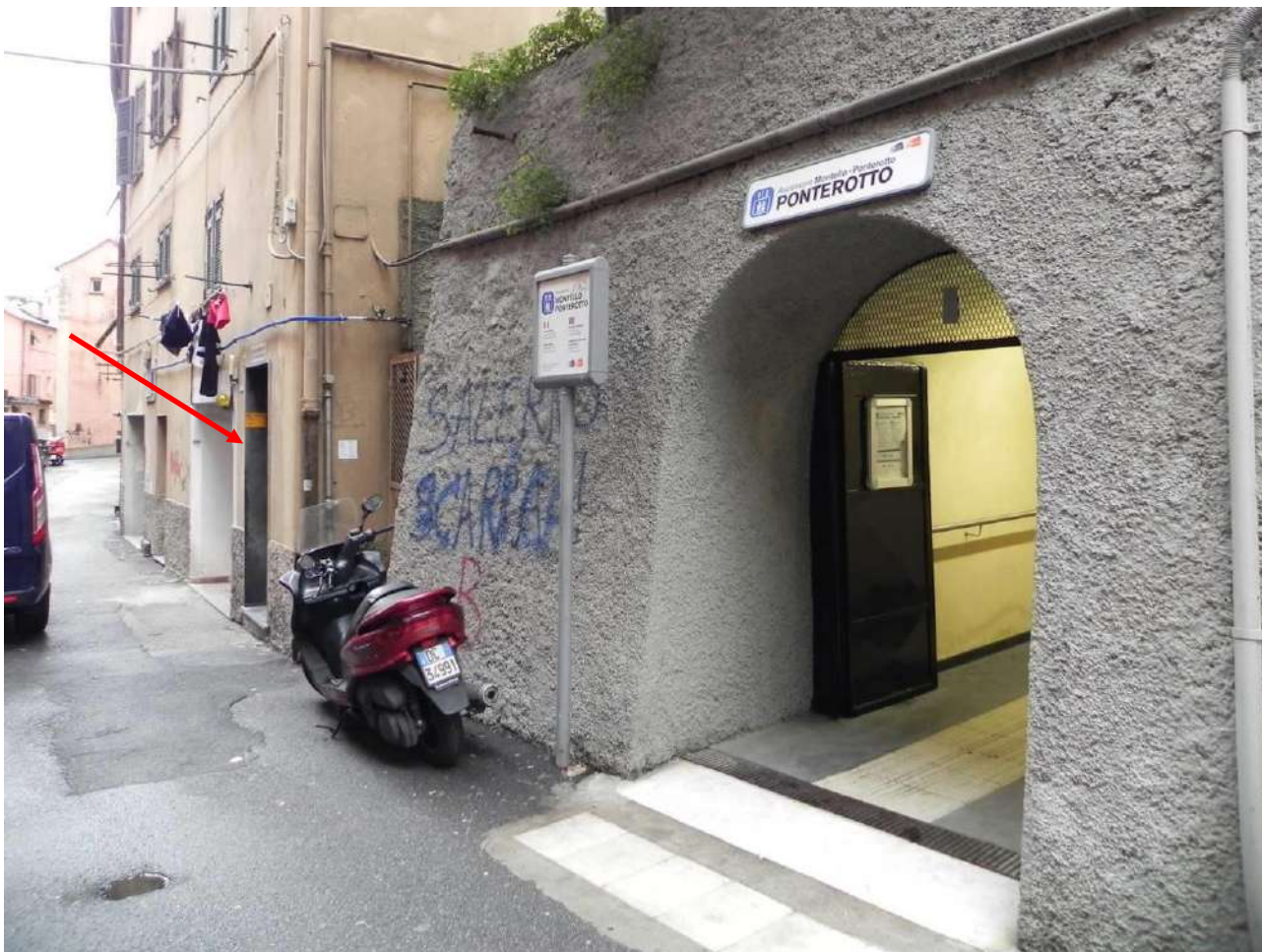
Foto 13 - Vista dell'ingresso all'ascensore pubblico fermata Ponterotto che è posizionato proprio di fianco all'ingresso condominiale della palazzina su Via Ponterotto 80
