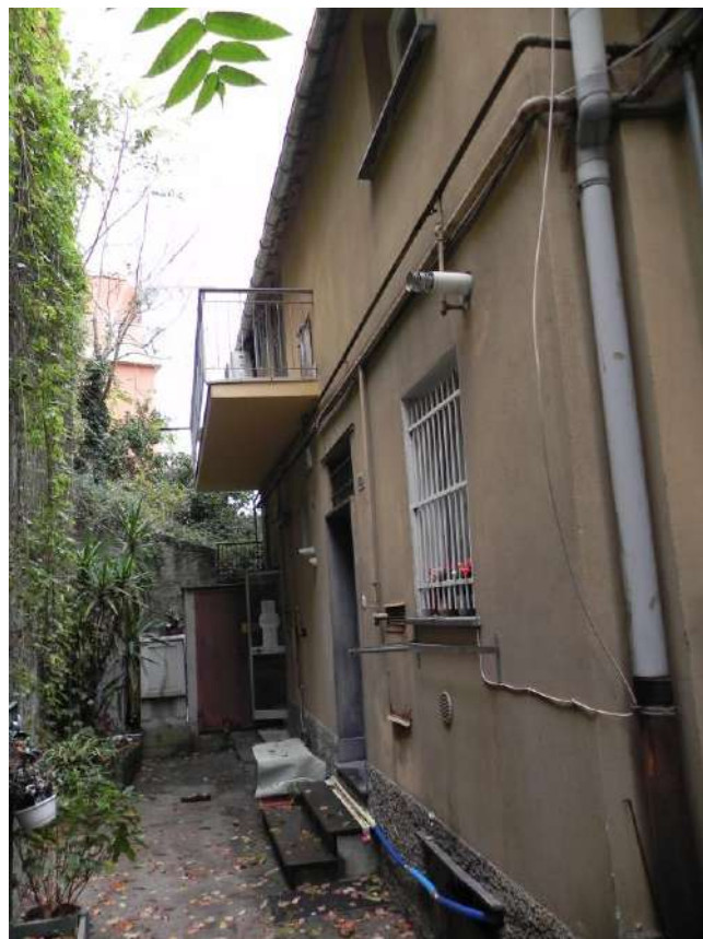
Foto 10 - Vista della corte interna della palazzina su Via Ponterotto civico 80 In evidenza il balcone dell'appartamento interno int. 3
