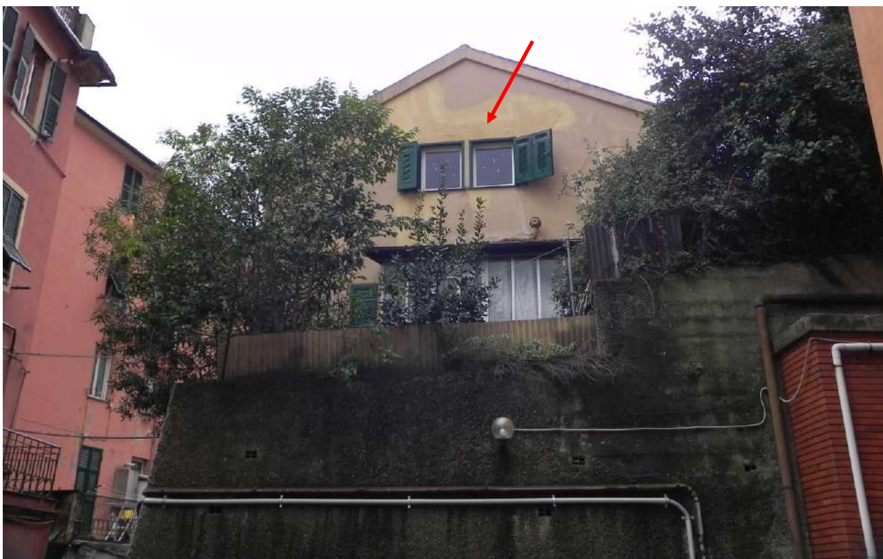
Foto 11 - Vista della palazzina su Via Ponterotto 80 di Genova (Marassi) In evidenza la finestra del soggiorno dell'interno 3 oggetto di procedura
