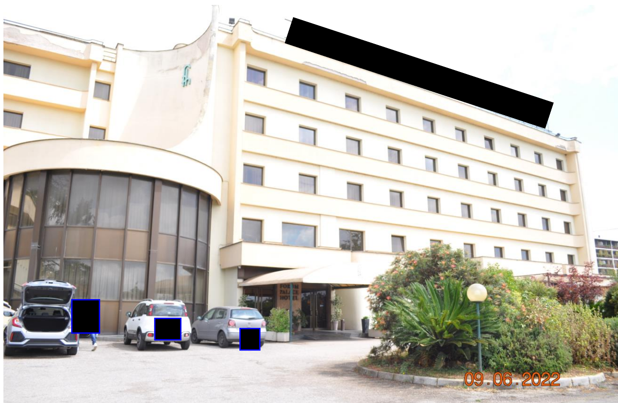
Foto n.3– Prospetto principale hotel
