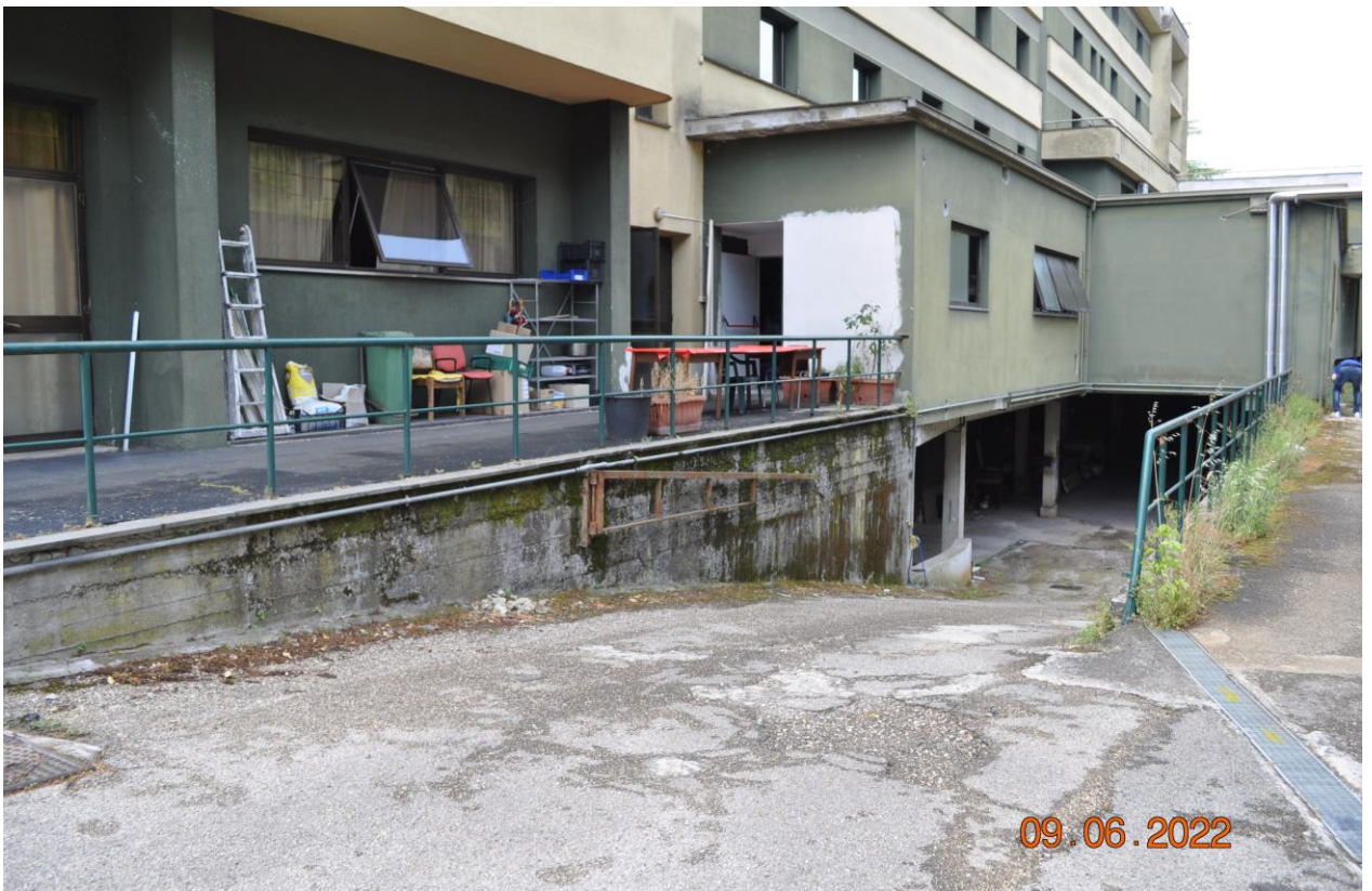
Foto n.13 – zona posteriore hotel – ingresso seminterrato
