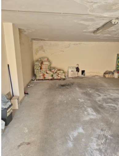
Figura 14 interno del box auto al piano interrato
