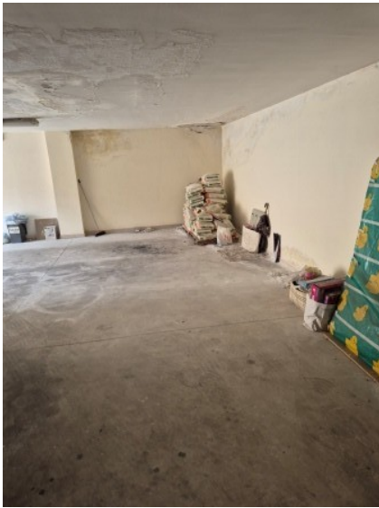
Figura 16 interno del box auto al piano interrato
