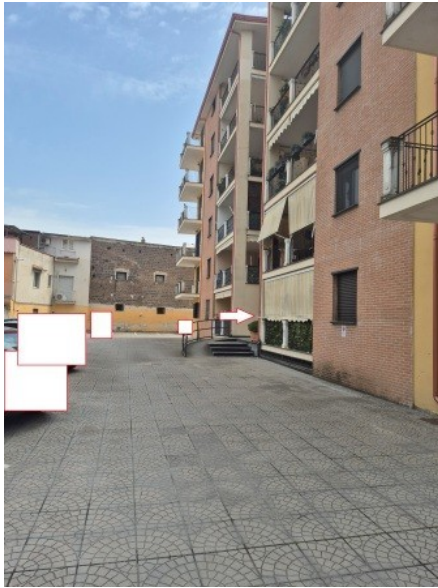
Figura 10 cortile comune con accesso al vano scala
