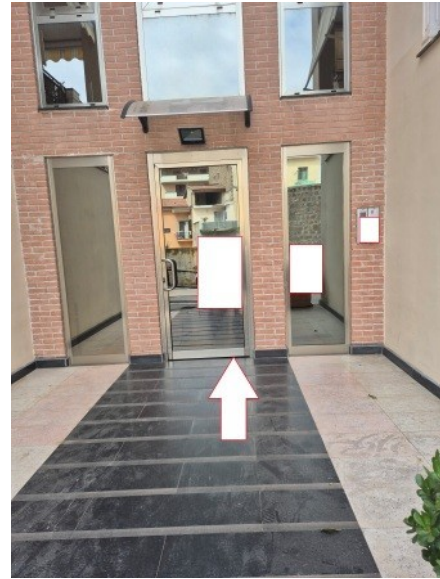
Figura 11 accesso al vano scala
