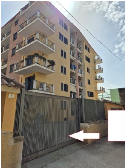
Figura 8 facciata ovest del fabbricato a cui appartengono gli immobili pignorati con accesso carrabile dal vicolo Togliatti
