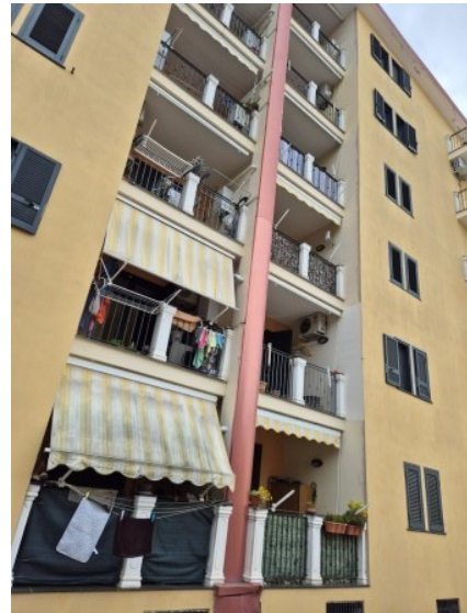
Figura 9 facciata sud del fabbricato a cui appartengono gli immobili pignorati
