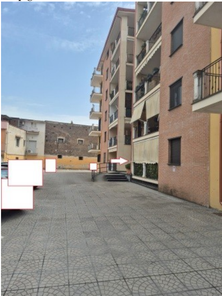
Figura 10 cortile comune con accesso al vano scala
