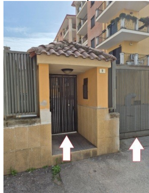
Figura 6 accesso pedonale e carrabile al fabbricato del XXXXXXXXXXXX in santa Maria Capua Vetere
