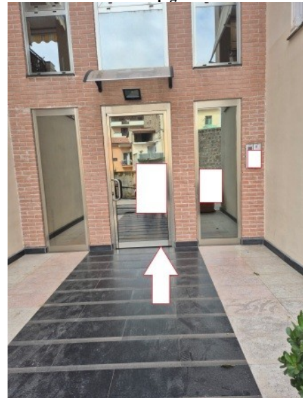
Figura 11 accesso al vano scala
