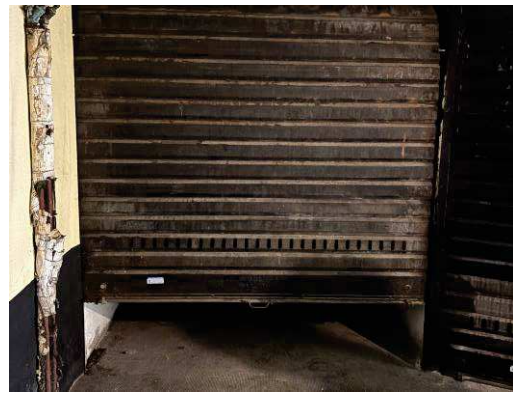
PORTONE DI ACCESSO AL GARAGE
