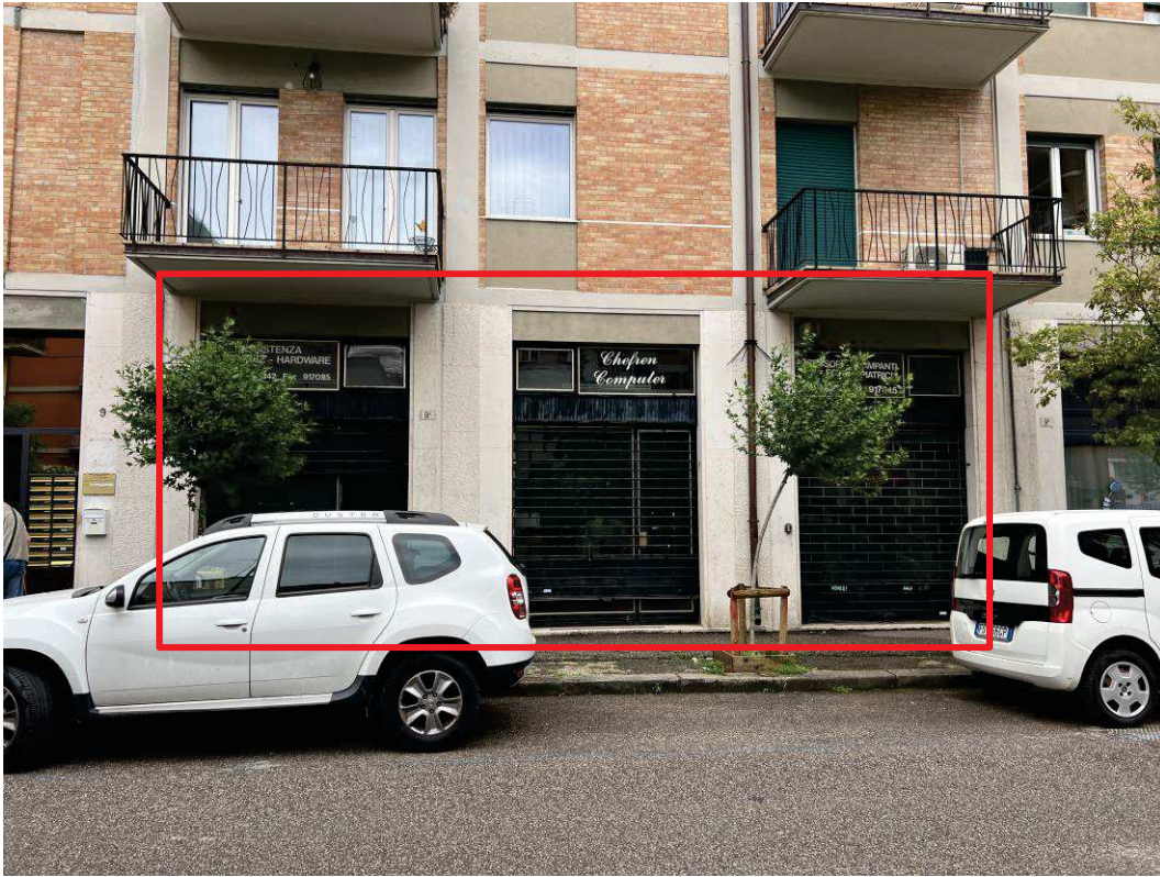
VERANDE DEL LOCALE COMMERCIALE
