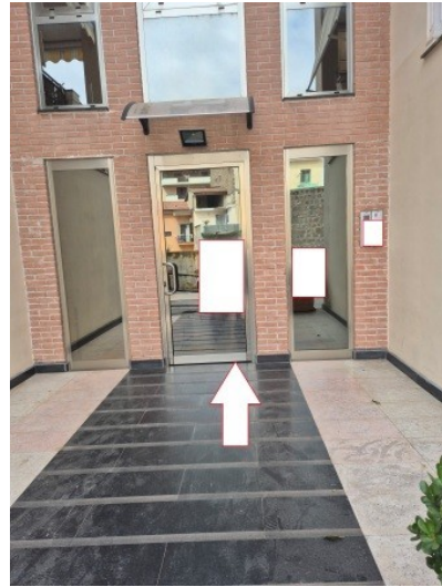
Figura 11 accesso al vano scala
