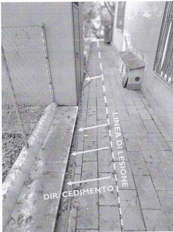
IMMAGINE 7 – Marciapiede esterno
