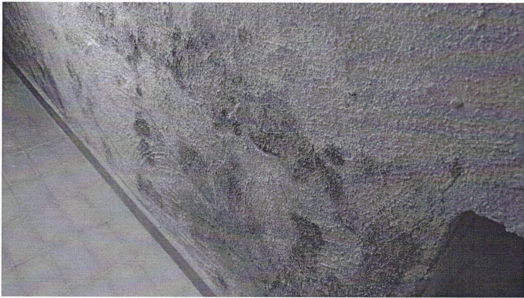
IMMAGINE 2 – Parete laterale della cantina
