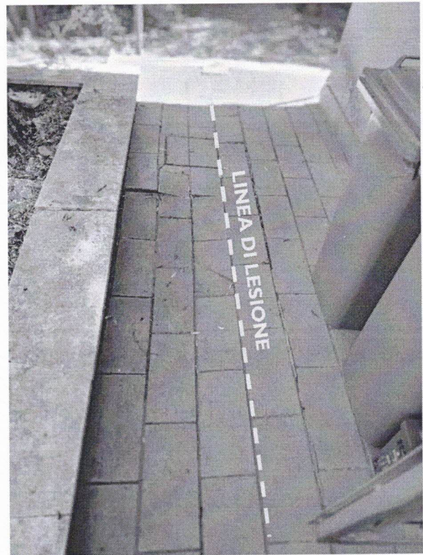
IMMAGINE 8 – Marciapiede esterno
