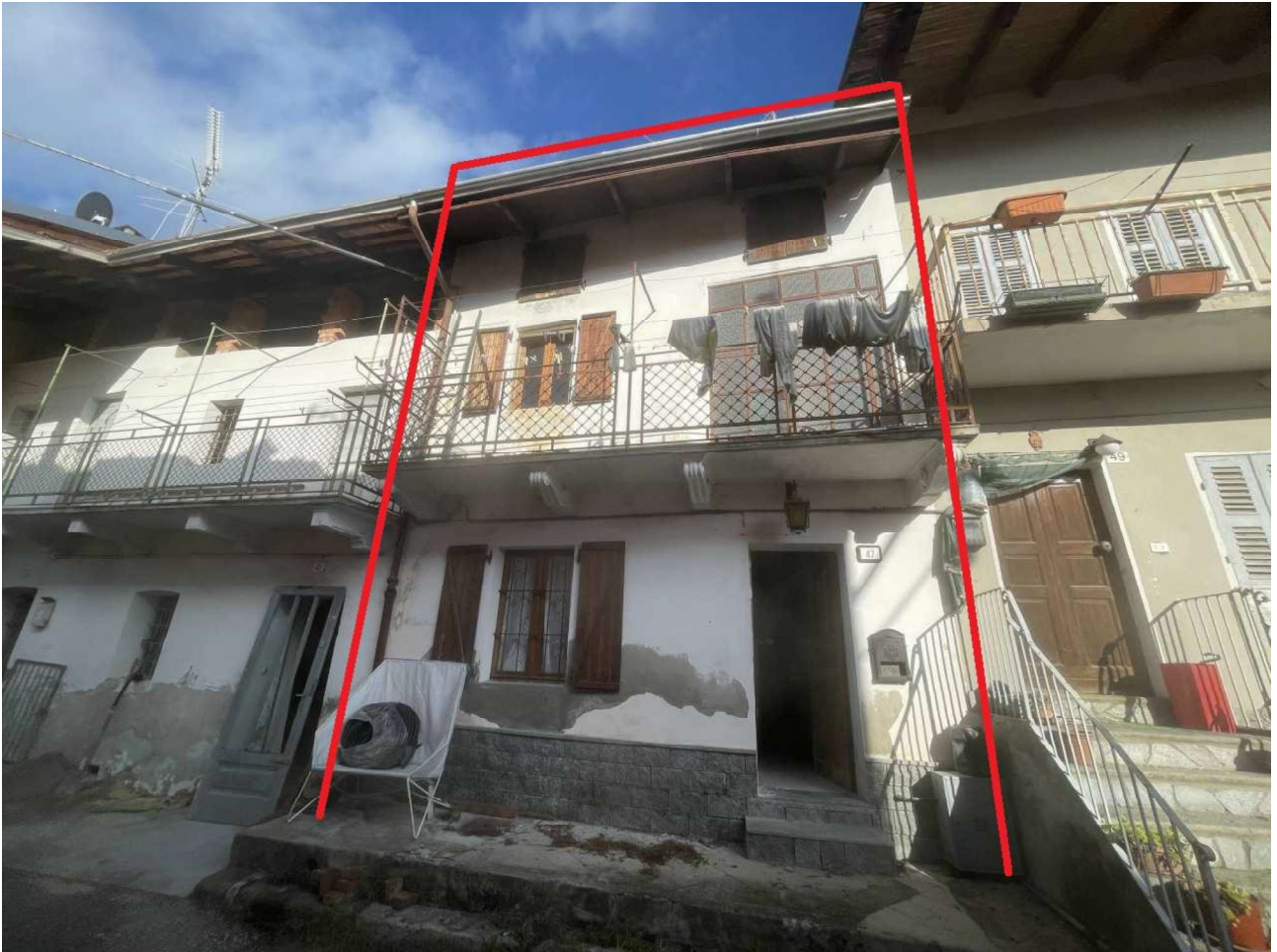
Bene N° 1 – Fabbricato civile ubicato in Strona (BI) Frazione Boero, 47
