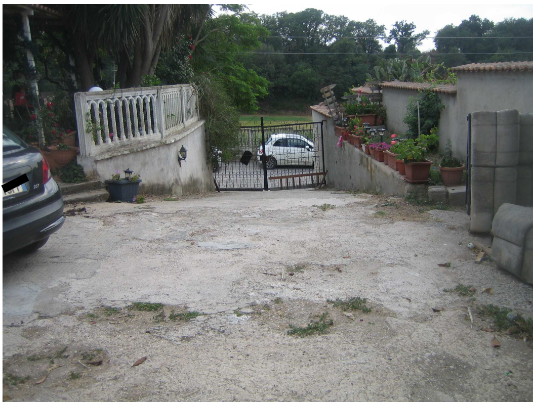
FOTO n. 4 - Panoramica esterna dell'immobile
