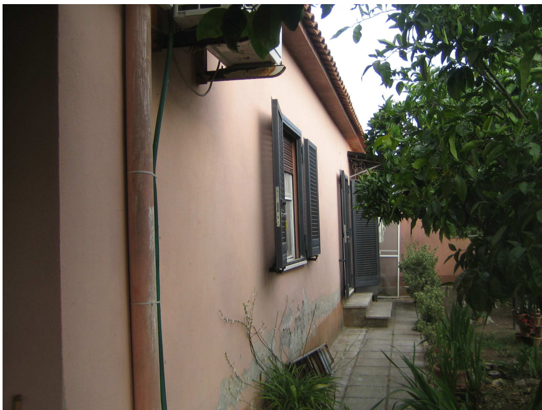
FOTO n. 3 - Panoramica esterna dell'immobile
