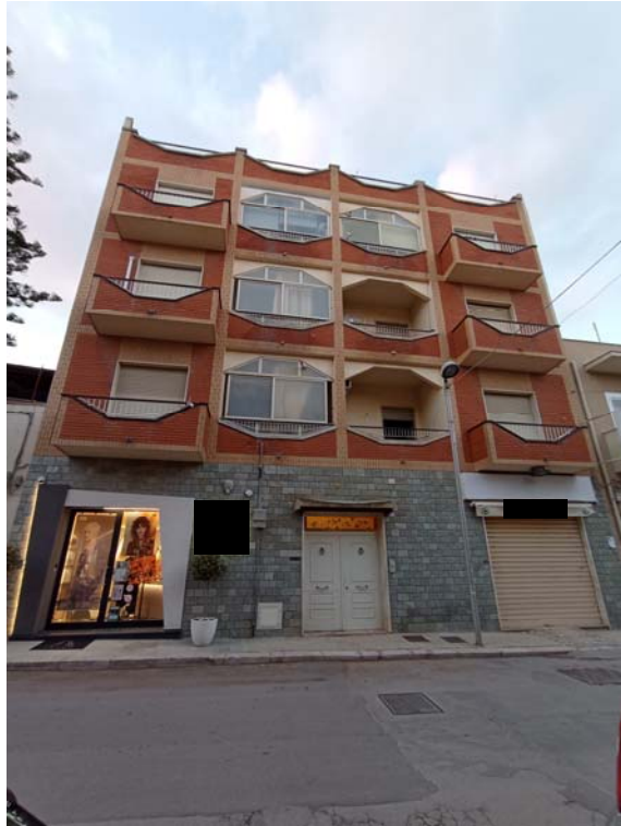
facciata edificio su via G. Quattrocchi
