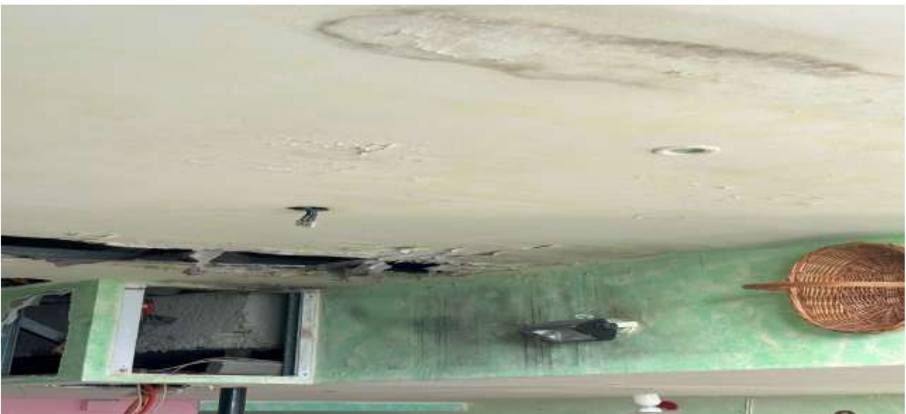
Foto 12 – segni di infiltrazioni sulla controsoffittatura
