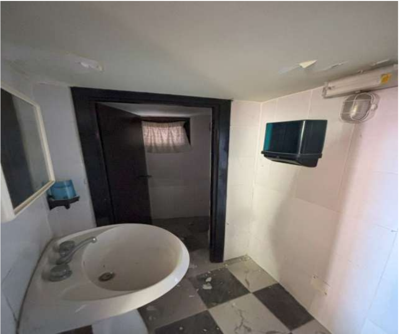
Foto 12 – segni di infiltrazioni sulla controsoffittatura
