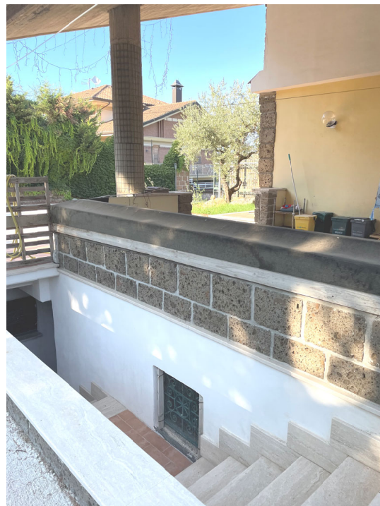
Ingresso al piano interrato dal terrazzo antistante abitazione
