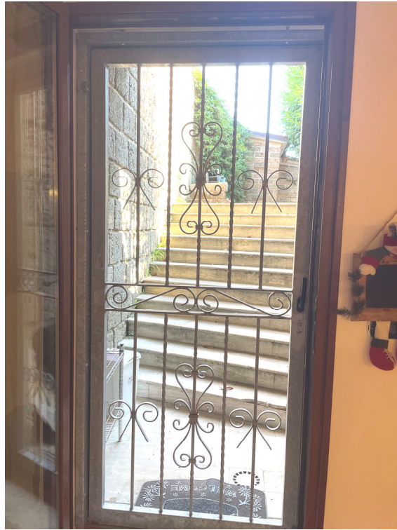
Ingresso al piano interrato dall'esterno
