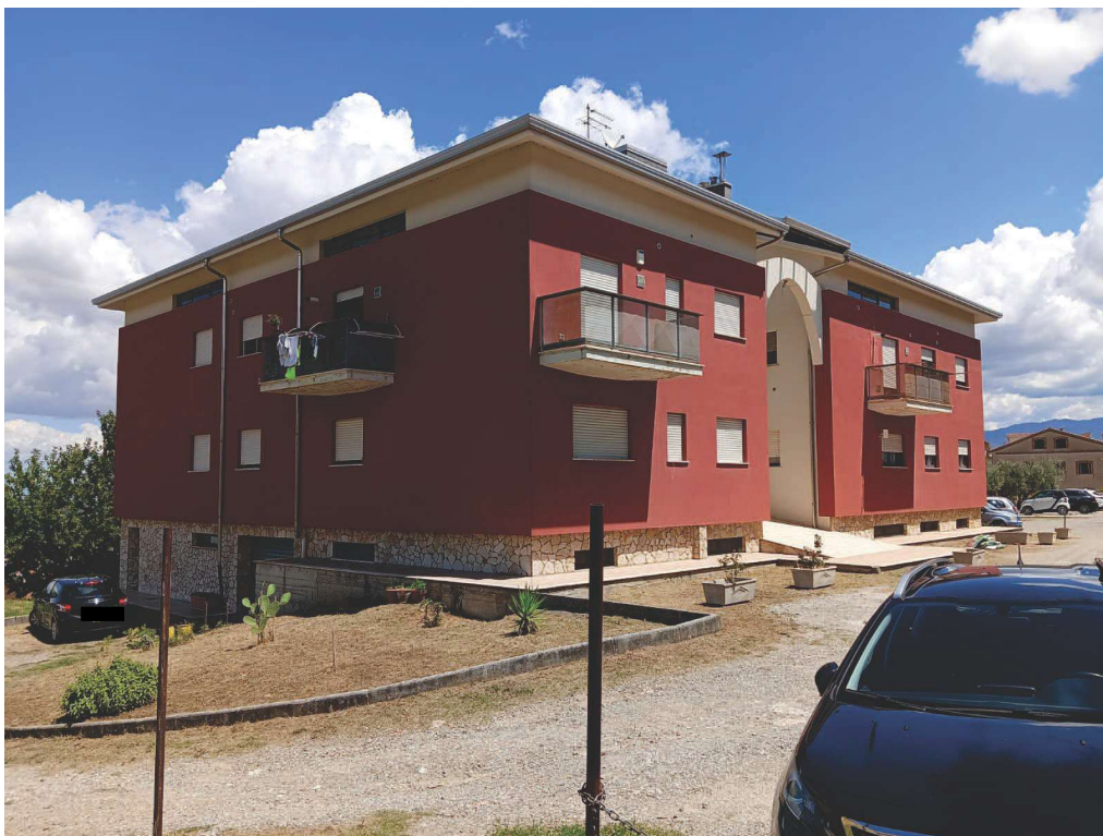
Foto n°1: Fabbricato denominato “Blocco n.02” comprendente le unità immobiliari pignorate
