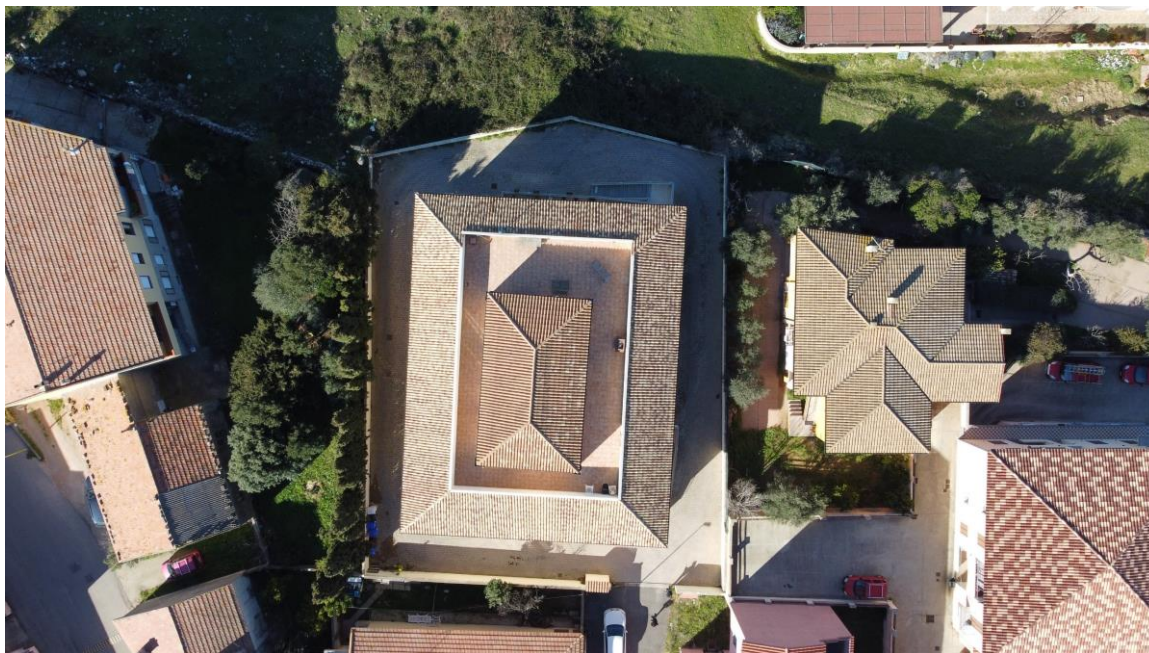
Figura 2 – Ubicazione – vista area del fabbricato che ospita l'unità immobiliare oggetto del presente elaborato peritale
