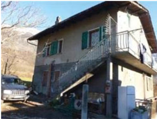
Fabbricato con corte adiacente
