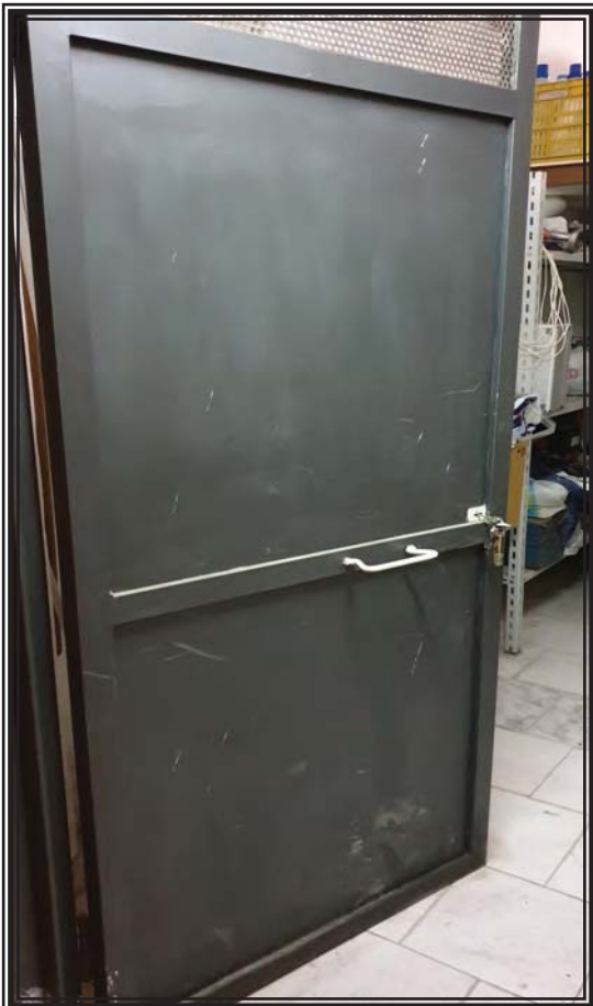
FOTO 18 - Accesso alla cantinola in uso al cespite pignorato
