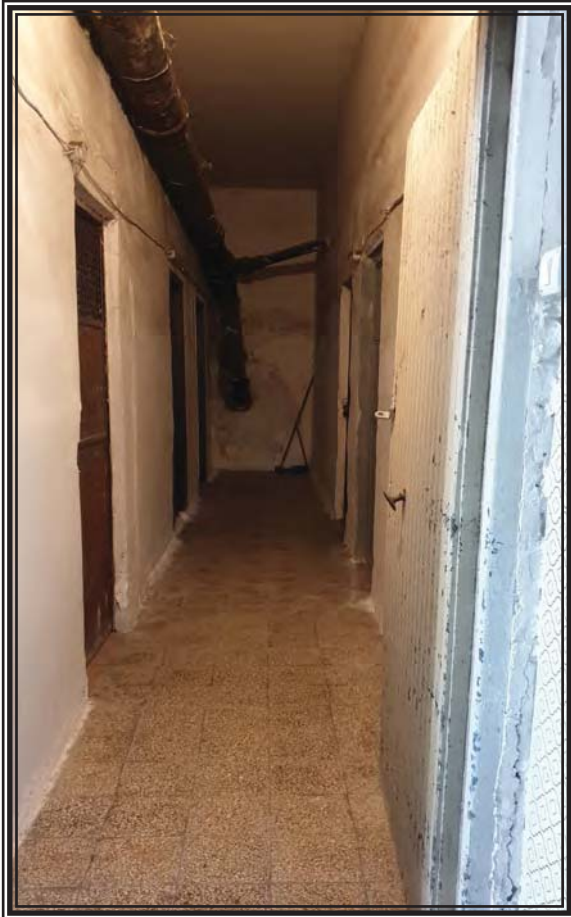
FOTO 17 - Disimpegno piano seminterrato
