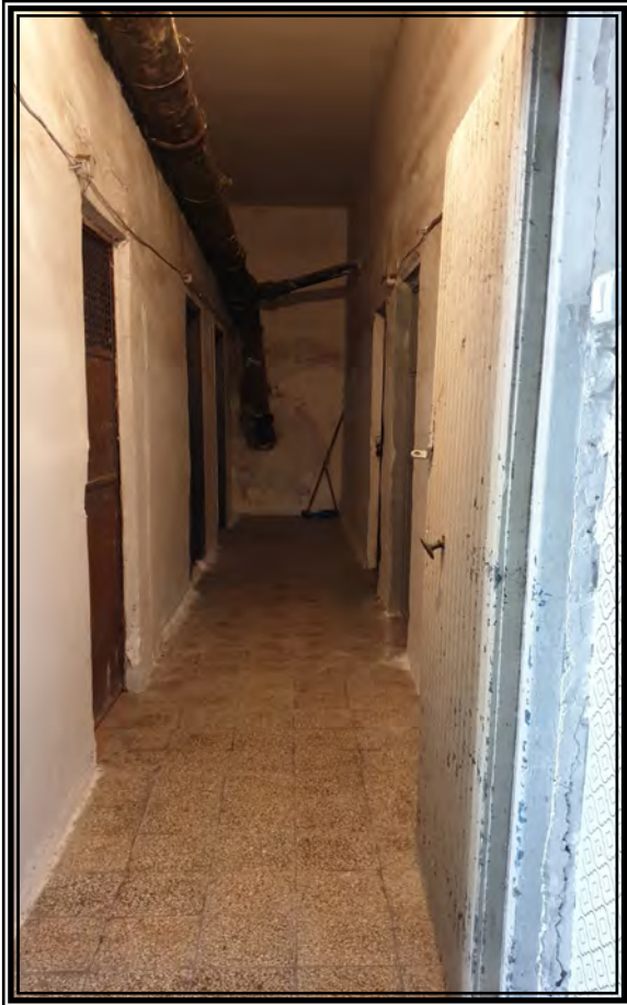
FOTO 17 - Disimpegno piano seminterrato
