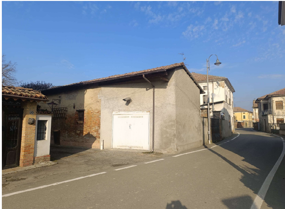
Autorimessa – vista esterna
