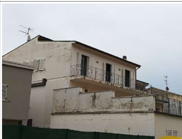
Prospetto angolo nord/ovest
