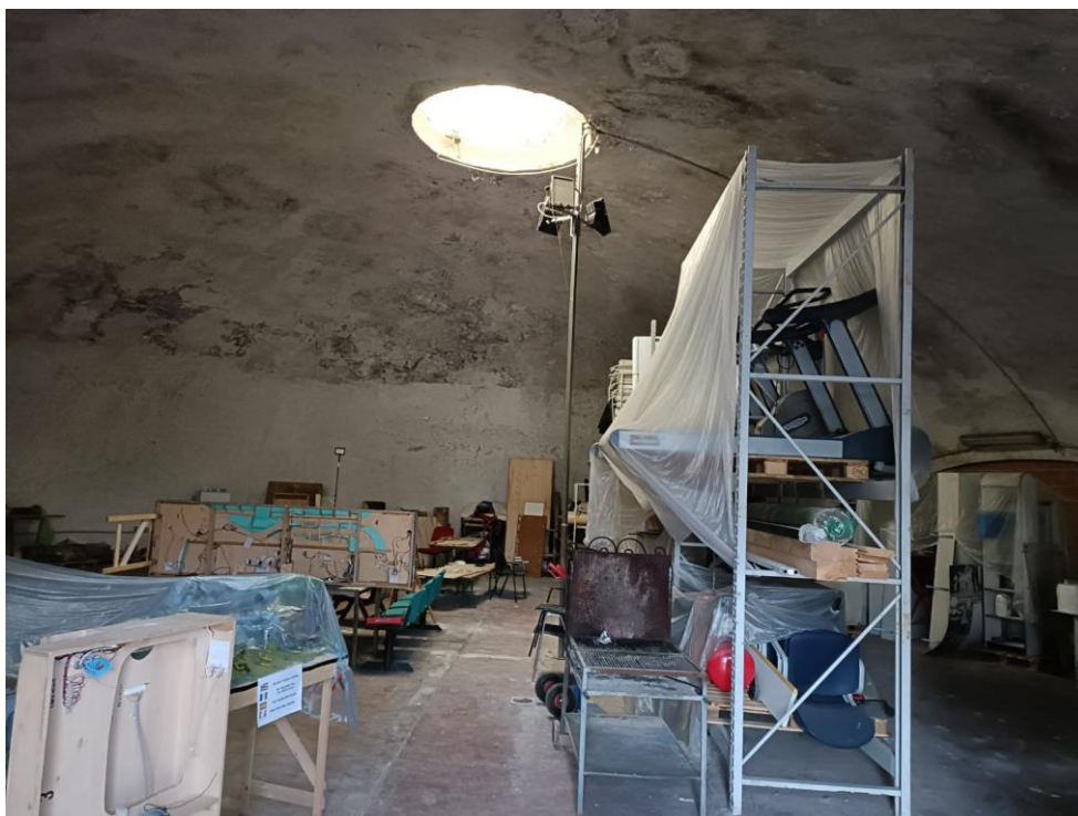
FOTO 7 – Prima vista dell'interno della cupola che ospita il magazzino.
