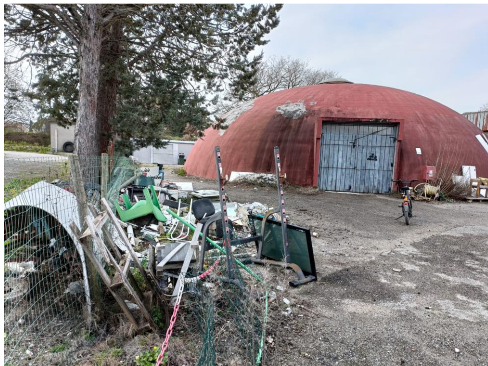
FOTO 6 – Seconda vista dall'esterno della cupola che ospita il magazzino.
