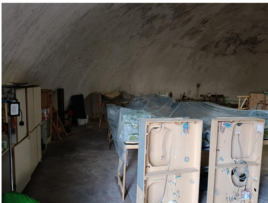
FOTO 8 – Seconda vista dell'interno della cupola che ospita il magazzino.
